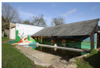
Vue d'ensemble du lavoir.
