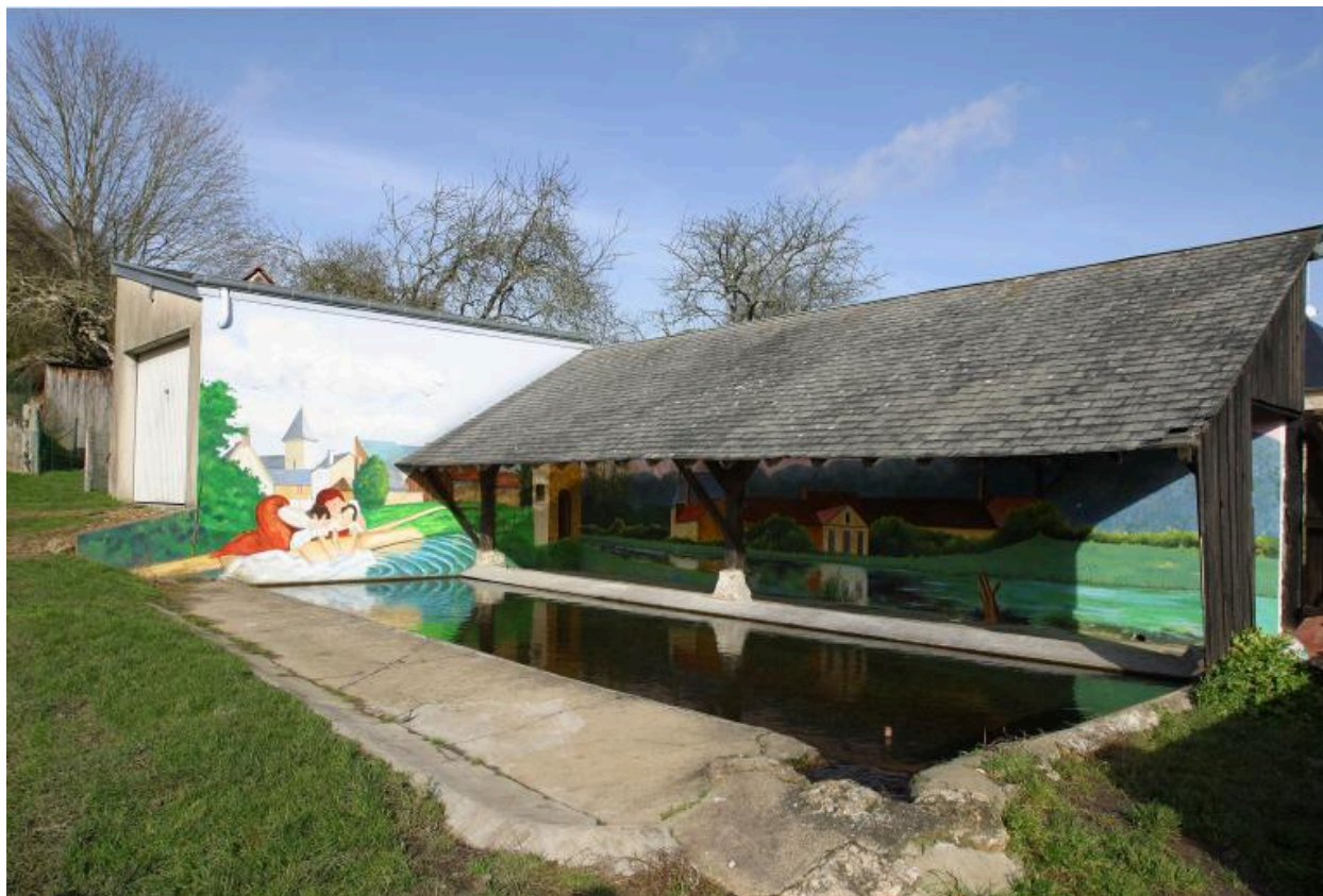
Vue d'ensemble du lavoir.
