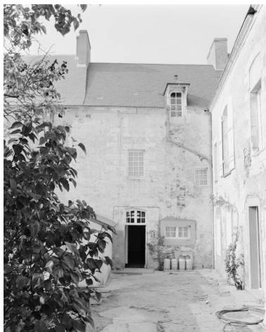
Façade postérieure, partie droite. Phot. Bruno Rousseau IVR52_19854901793X
