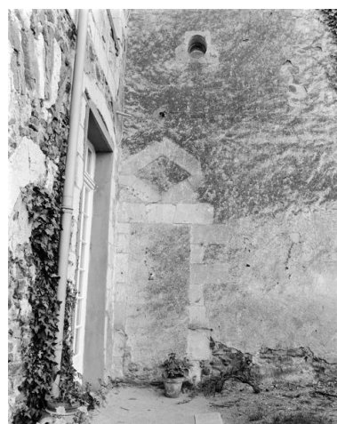
Aile en retour d'équerre, façade nord, détail d'une ouverture murée. Phot. Bruno Rousseau IVR52_19854901791X
