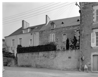
Vue d'ensemble, façades antérieures sur rue. Phot. Bruno Rousseau IVR52_19854901816V
