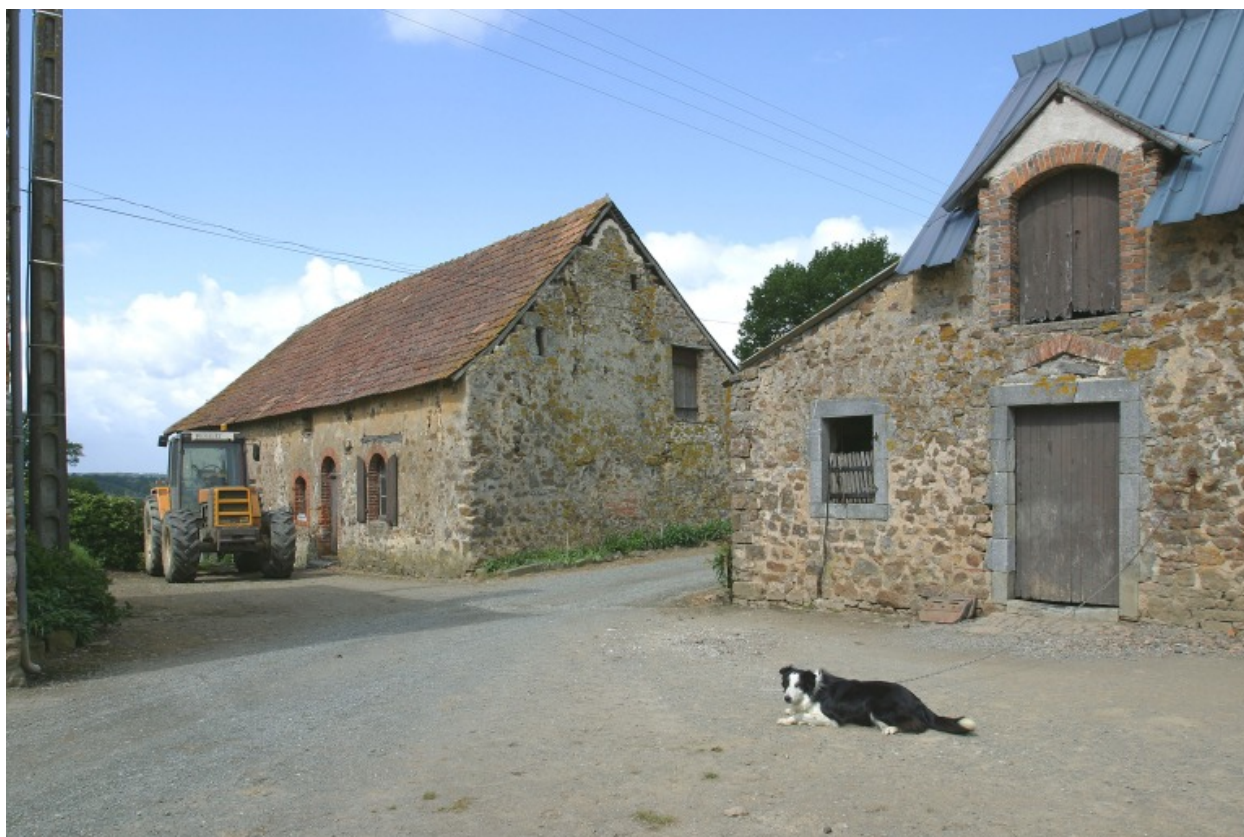
Le logis-étable et l'étable à chevaux-fournil vus depuis la cour à l'est.
