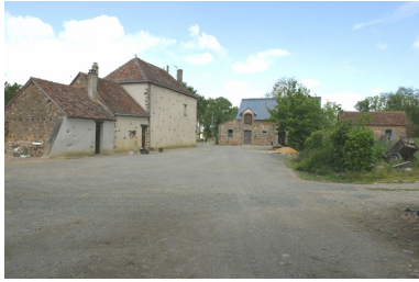
Vue d'ensemble depuis le sud-est : la maison de maître, l'étable à chevaux-fournil, la porcherie. Phot. François Lasa IVR52_20035301718NUCA
