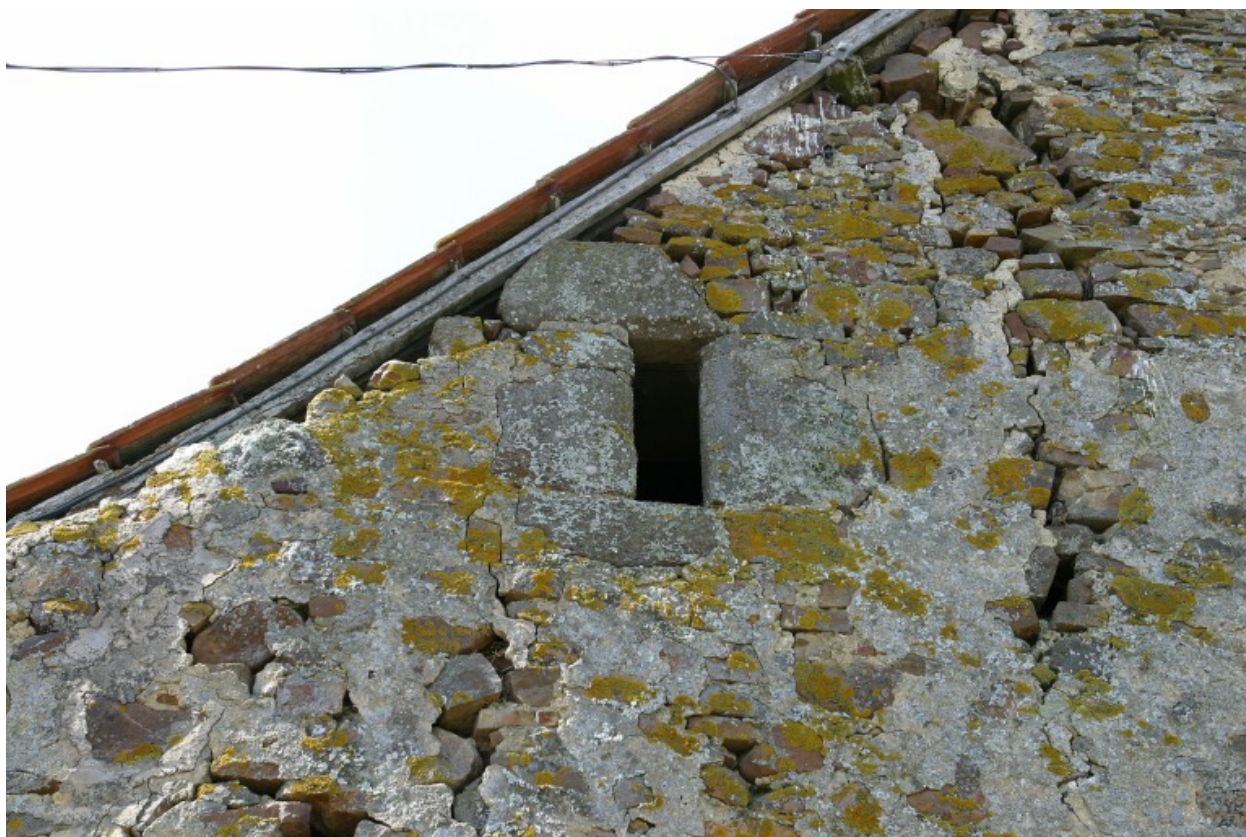
Détail du pignon nord-est du logis-étable.
