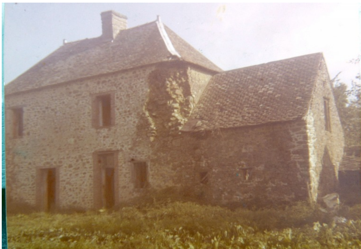
Photographie, années 1980. La maison de maître : façade principale vue depuis le sud avant les transformations.
