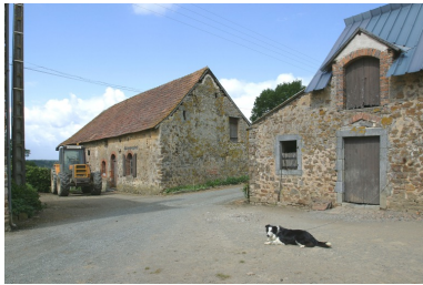
Le logis-étable et l'étable à chevaux-fournil vus depuis la cour à l'est. Phot. François Lasa IVR52_20035301715NUCA
