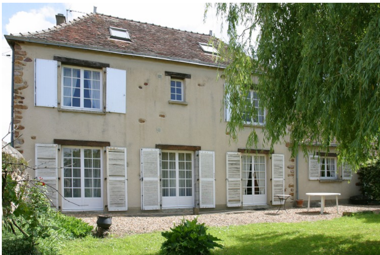
La maison de maître : façade principale vue depuis le sud-ouest.
