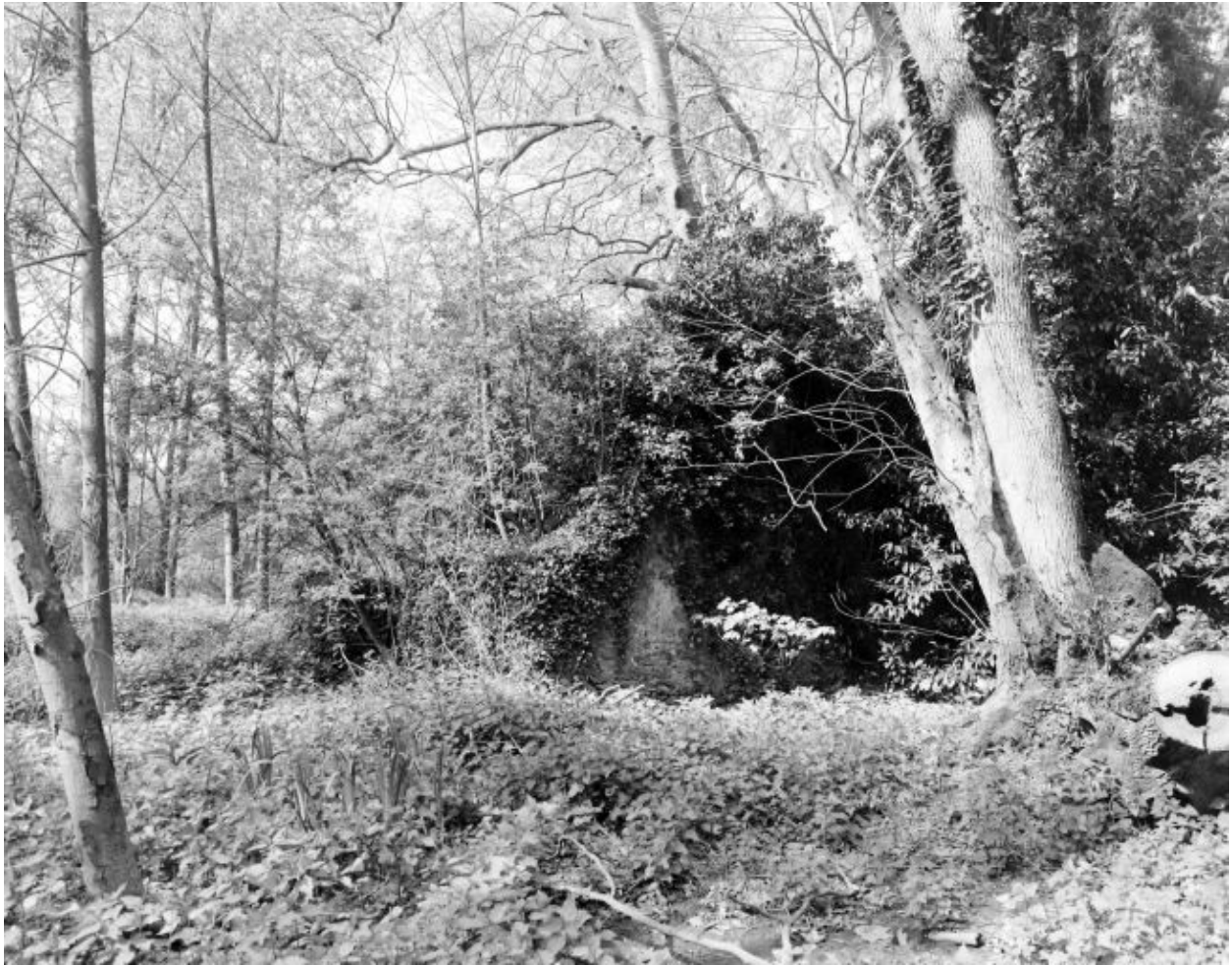
Les ruines du moulin : murs sud-est et nord-est.
