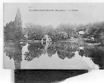
Vue depuis la rive droite, en aval, de l'ancien moulin à foulon de la Valette, alors qu'il servait de remise à bateau pour les propriétaires du château. Repro. François Lasa IVR52_20015300392X
