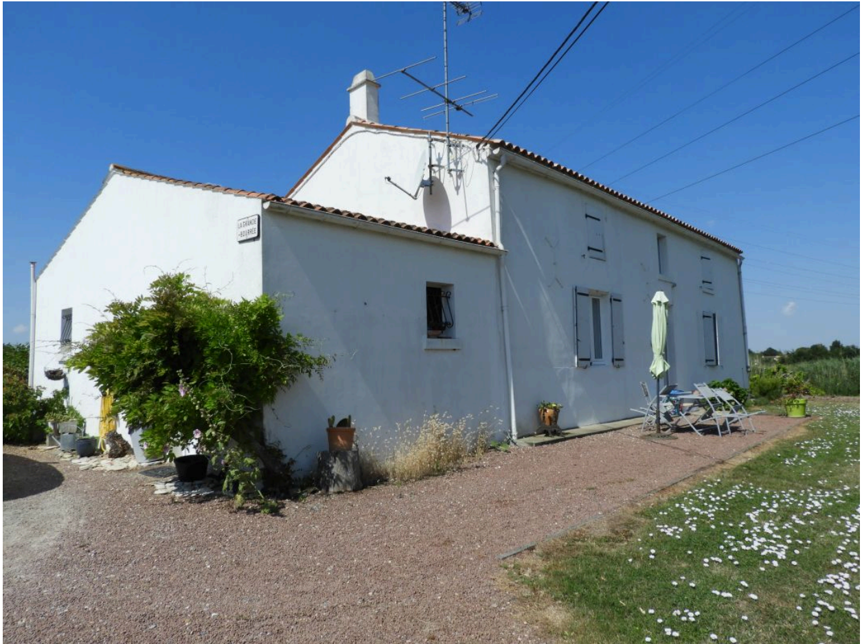
Le logis vu depuis l'est.
