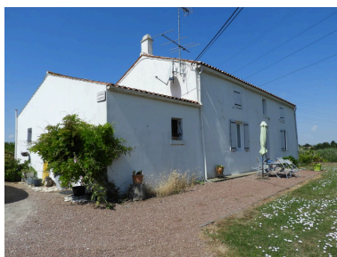
Le logis vu depuis l'est. Phot. Yannis Suire IVR52_20188501231NUCA
