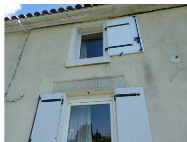
Détail de la façade sud-ouest : corniche et linteau de porte moulurés. Phot. Yannis Suire
