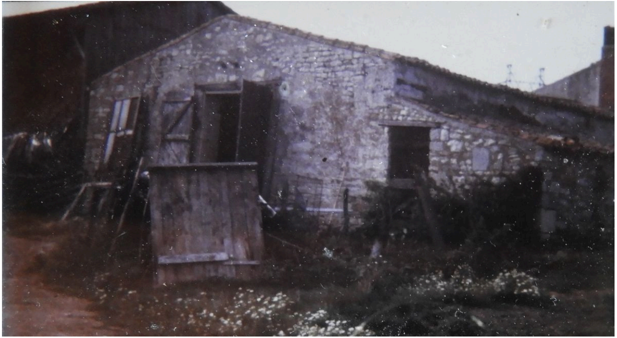
La grange-étable à façade en pignon qui prolongeait le logis au sud-est, vue depuis le sud-est vers 1980.
