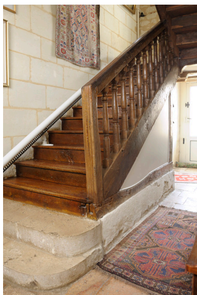
Escalier : détail des balustres. Phot. Bruno Rousseau IVR52_20124901089NUCA
