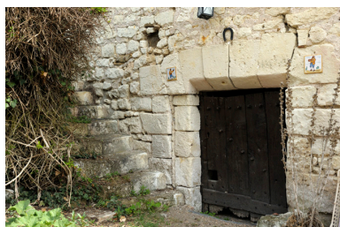
Communs : détail de la porte à clous en bois. Phot. Bruno Rousseau IVR52_20124901087NUCA
