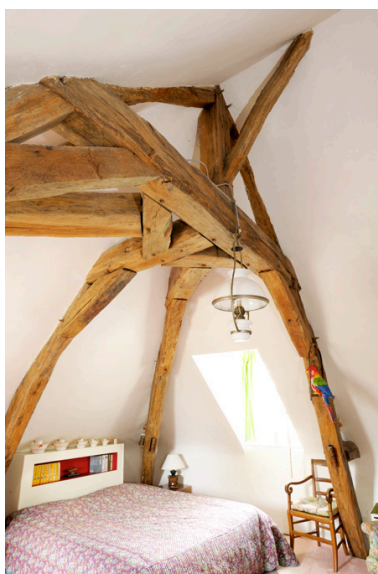
Charpente : détail de l'enrayure de la croupe est. Phot. Bruno Rousseau IVR52_20124901092NUCA
