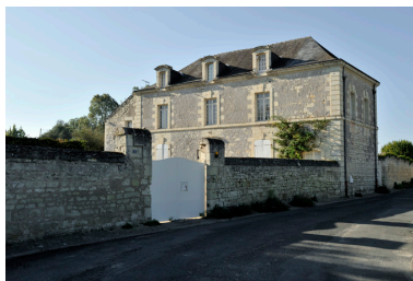
Vue d'ensemble depuis la rue. Phot. Bruno Rousseau, Phot. Youenn Communeau IVR52_20114902710NUCA
