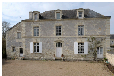
Façade sur cour. Phot. Bruno Rousseau IVR52_20124901086NUCA
