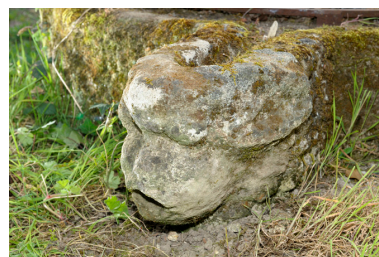
Ancien puits : détail de la gargouille (1). Phot. Bruno Rousseau IVR52_20124901083NUCA
