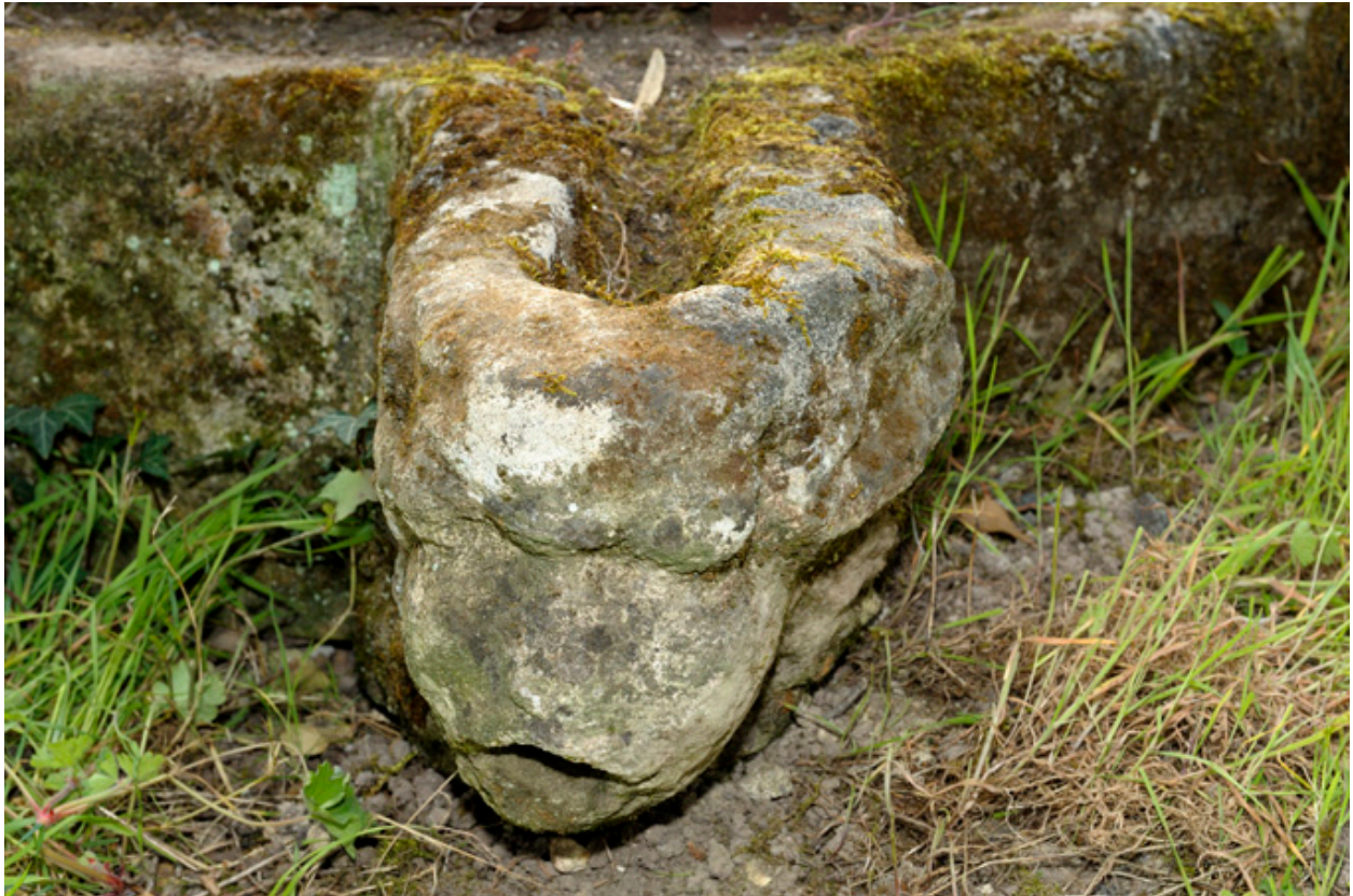
Ancien puits : détail de la gargouille (3).
