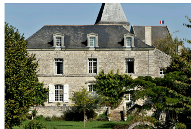
Façade postérieure. Phot. Bruno Rousseau, Phot. Youenn Communeau IVR52_20114902654NUCA
