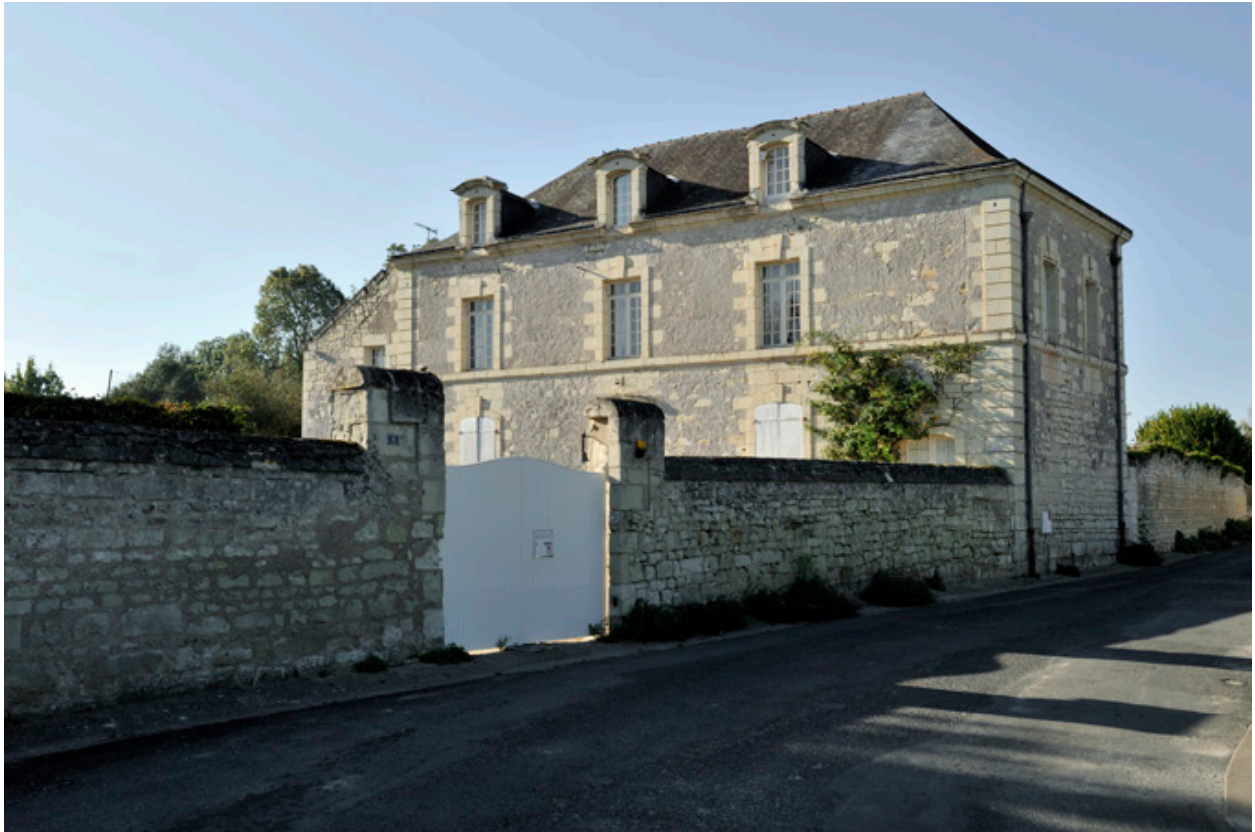
Vue d'ensemble depuis la rue.
