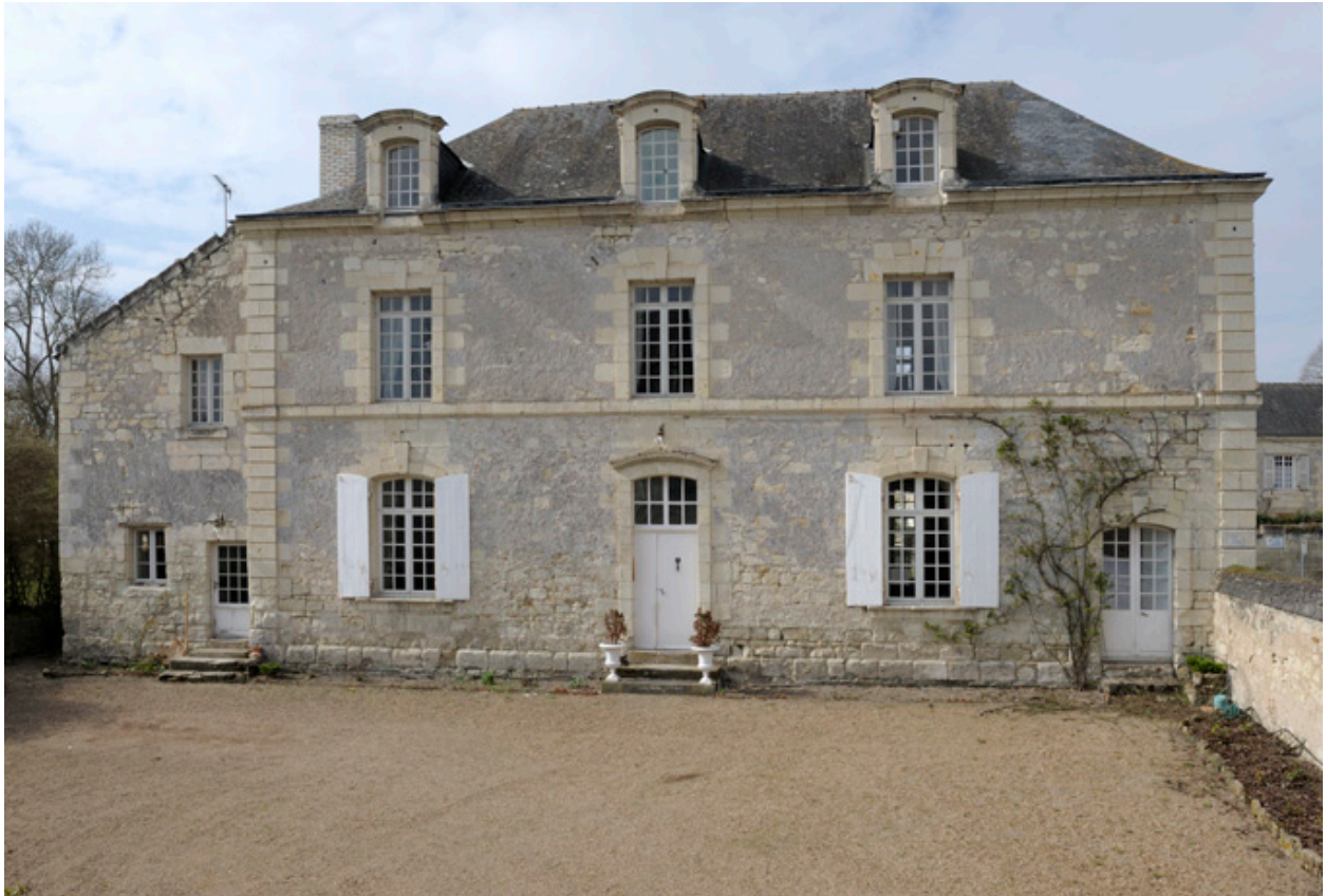
Façade sur cour.
