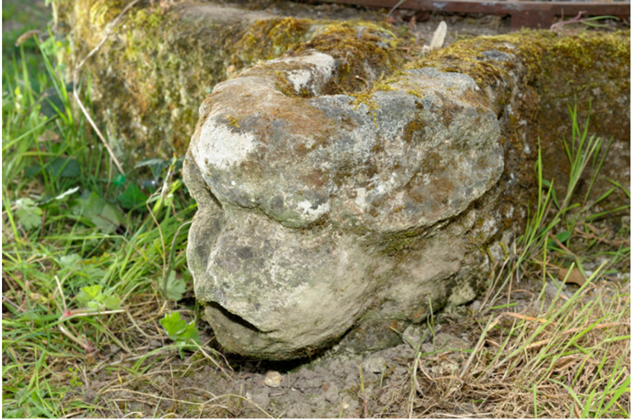
Ancien puits : détail de la gargouille (1).
