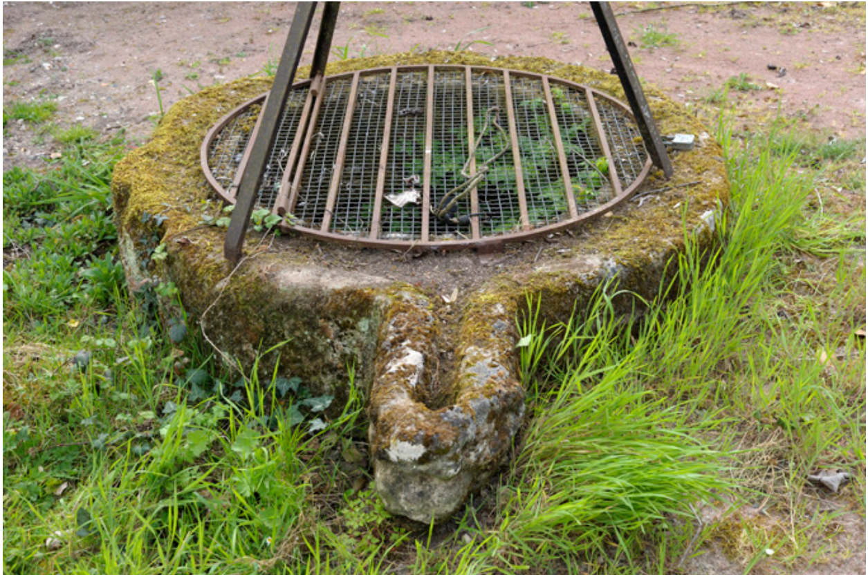
Ancien puits (XVe siècle ?), avec margelle monolithique ornée d'une gargouille.
