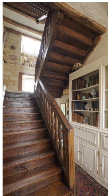
Escalier intérieur en charpente, tournant, sans jour, rampe sur rampe. Phot. Bruno Rousseau IVR52_20124901090NUCA
