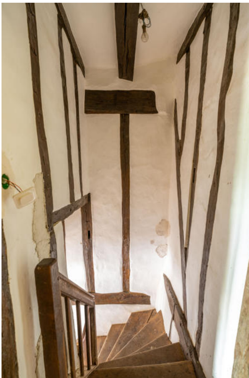
Intérieur du logis : pan de bois dans l'escalier.
