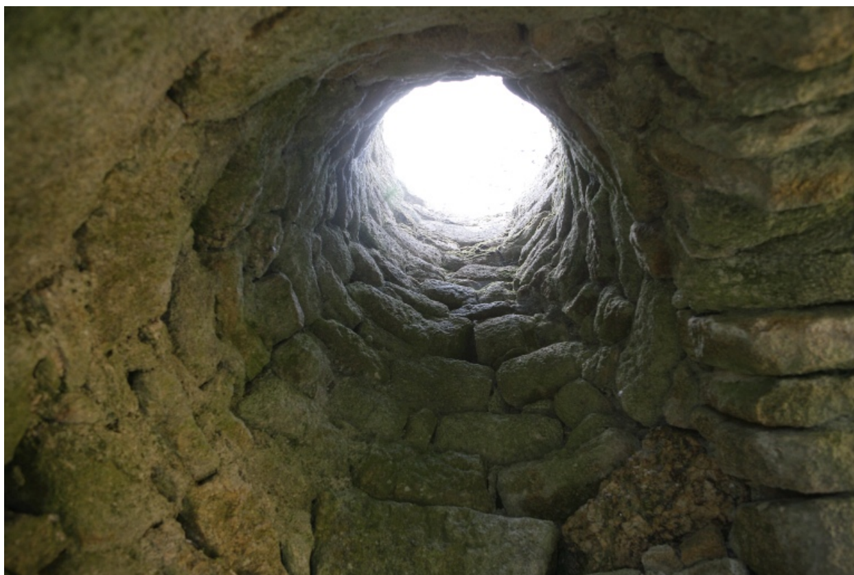
Intérieur de la tour : conduit central vertical qui contenait le pivot tournant portant la cage du moulin. Vue verticale de bas en haut.
