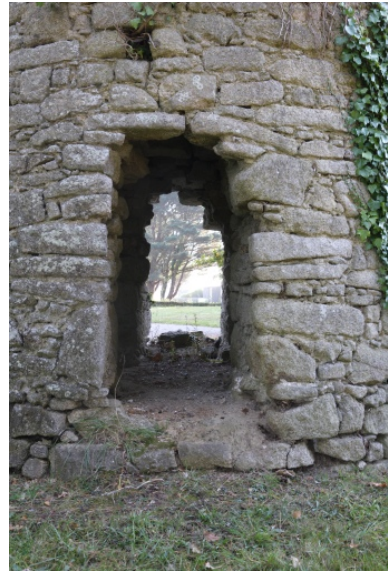
Le couloir diamétral d'axe sud-ouest nord-est traversant le pied de la tour qui contenait autrefois la poutre et la crapaudine où venait s'appuyer le pivot portant la cage.
