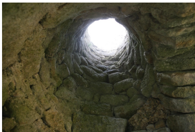
Intérieur de la tour : conduit central vertical qui contenait le pivot tournant portant la cage du moulin.
