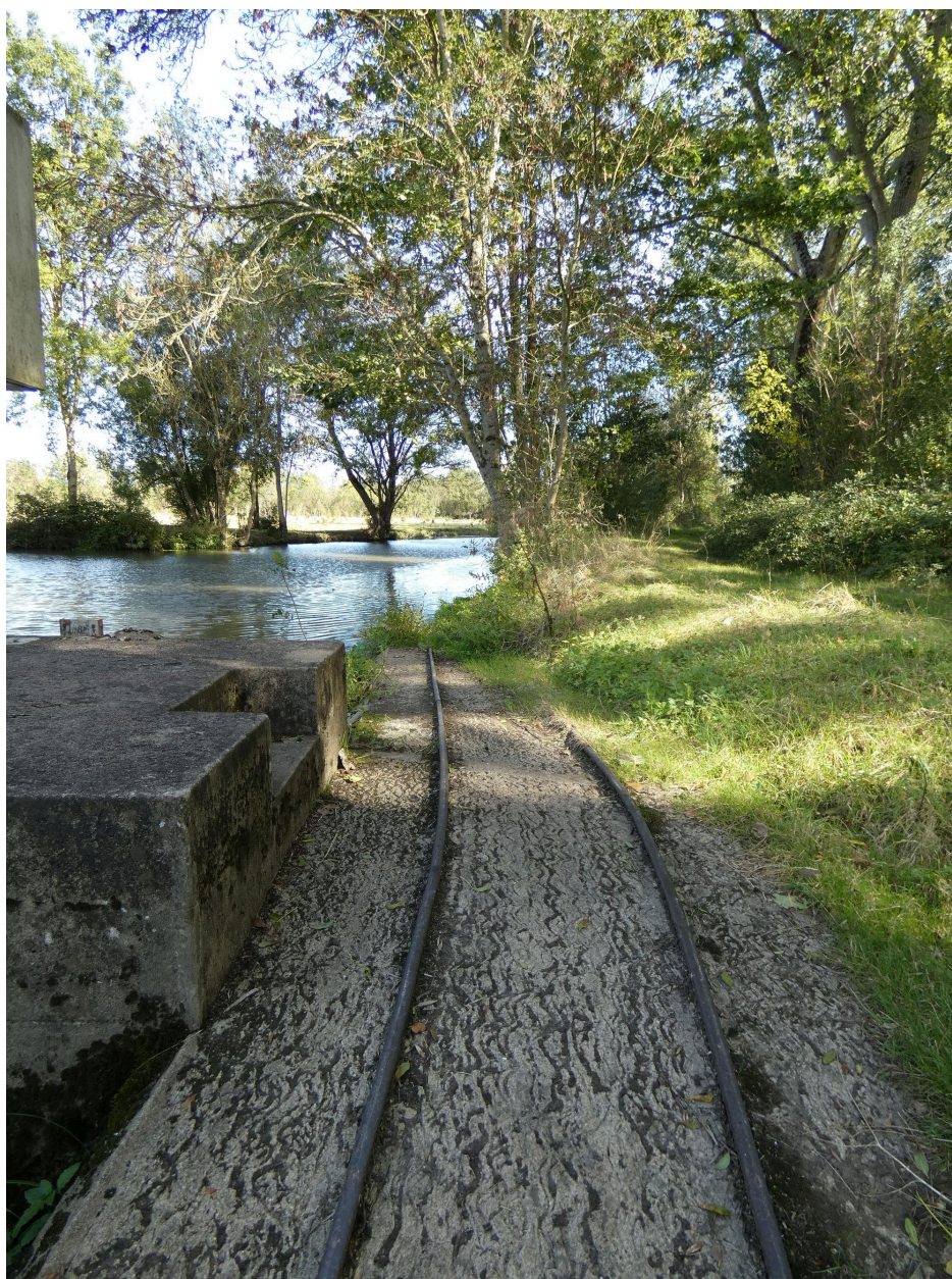
Le passage à bateau sur la rive gauche du barrage, vu depuis l'aval.
