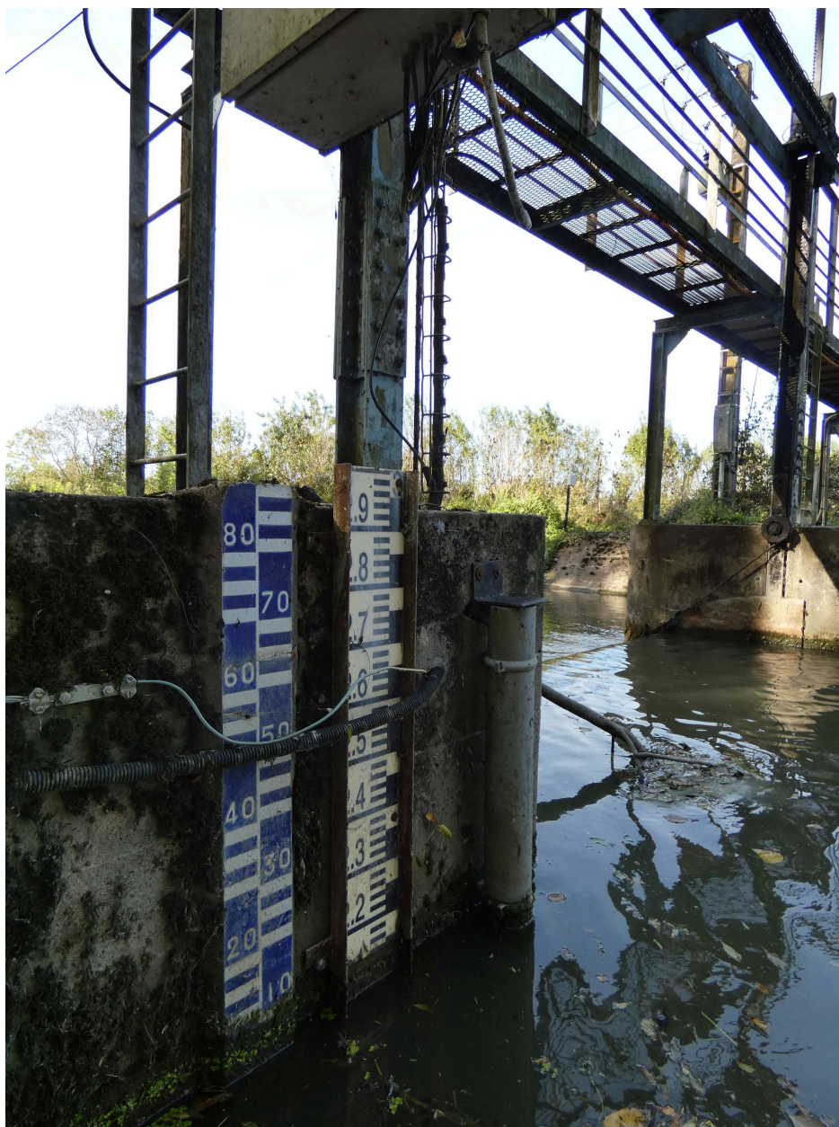
Règles de mesure du niveau d'eau sur la culée gauche du barrage, côté amont.
