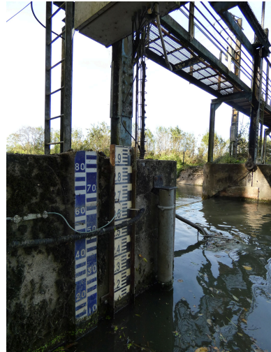
Règles de mesure du niveau d'eau sur la culée gauche du barrage, côté amont. Phot. Yannis Suire IVR52_20228501134NUCA
