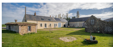
Vue d'ensemble. Phot. Jeanne Minier IVR52_20267200360NUCA
