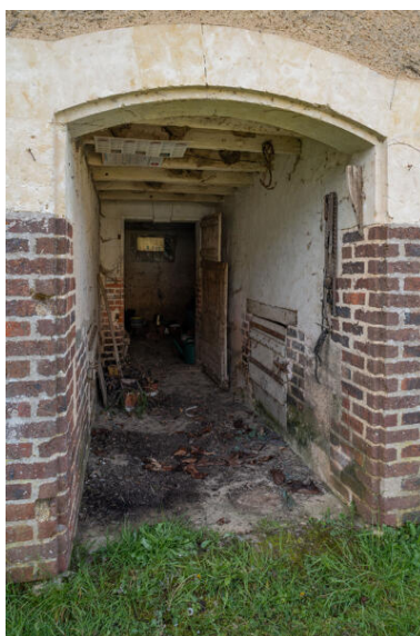
Porcherie : couloir de distribution avec trappes à nourriture. Phot. Jeanne Minier IVR52_20267200359NUCA
