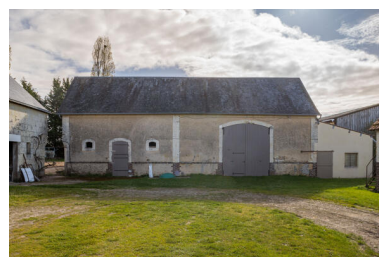
Grange-étable. Phot. Jeanne Minier IVR52_20267200361NUCA
