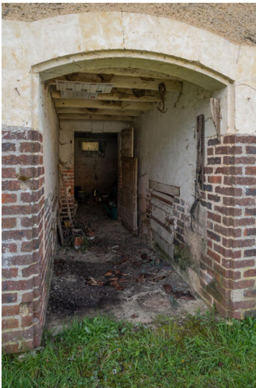
Porcherie : couloir de distribution avec trappes à nourriture.
