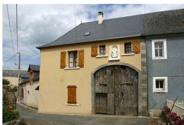
L'extrémité nord de l'aile est vue depuis la rue à l'ouest. Phot. François Lasa IVR52_20035302424NUCA
