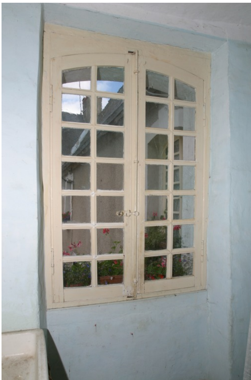
L'aile ouest, premier étage : vue depuis l'intérieur de la fenêtre donnant sur la cour au sud.
