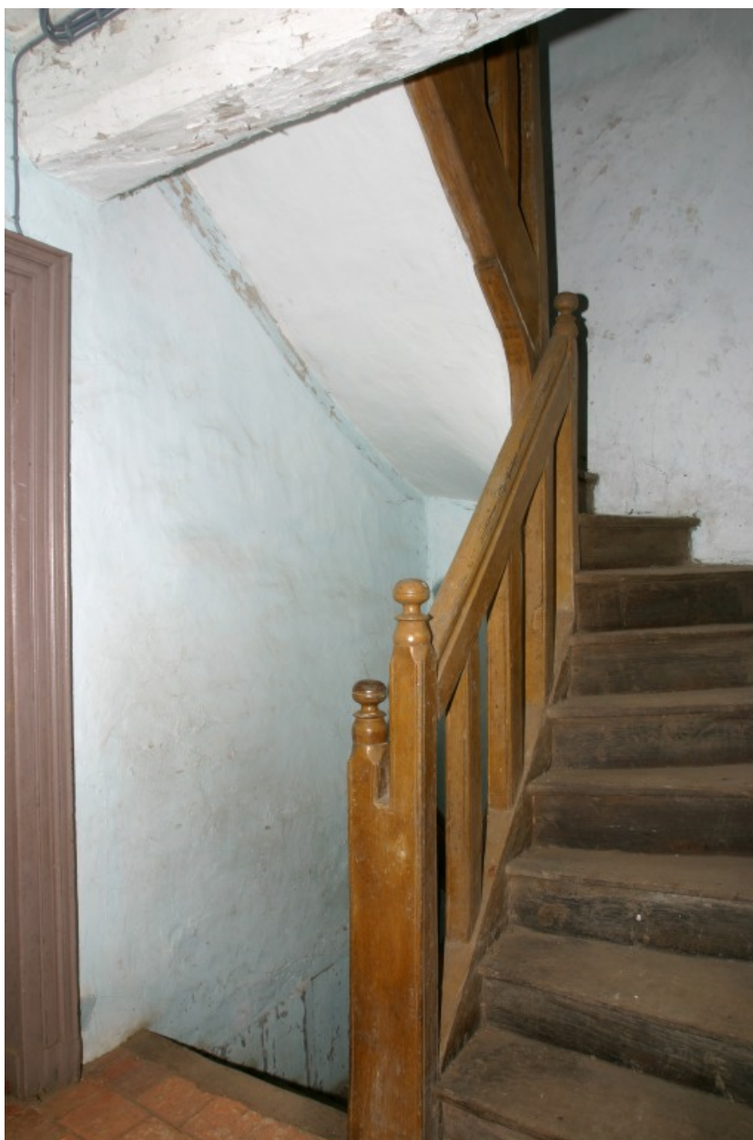
Le corps central, rez-de-chaussée : l'escalier.
