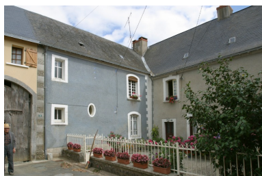
L'aile est et une partie du corps central vus depuis la rue au nord-ouest. Phot. François Lasa
