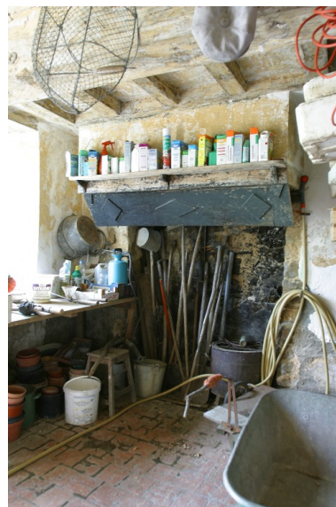
L'aile ouest, rez-de-chaussée : la cheminée de la pièce située à l'extrémité sud. Phot. François Lasa IVR52_20035302413NUCA
