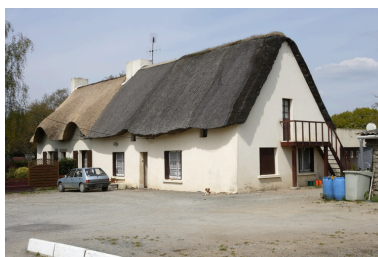
Vue d'ensemble depuis le sud-est. Phot. Denis Pillet IVR52_20084401486NUCA
