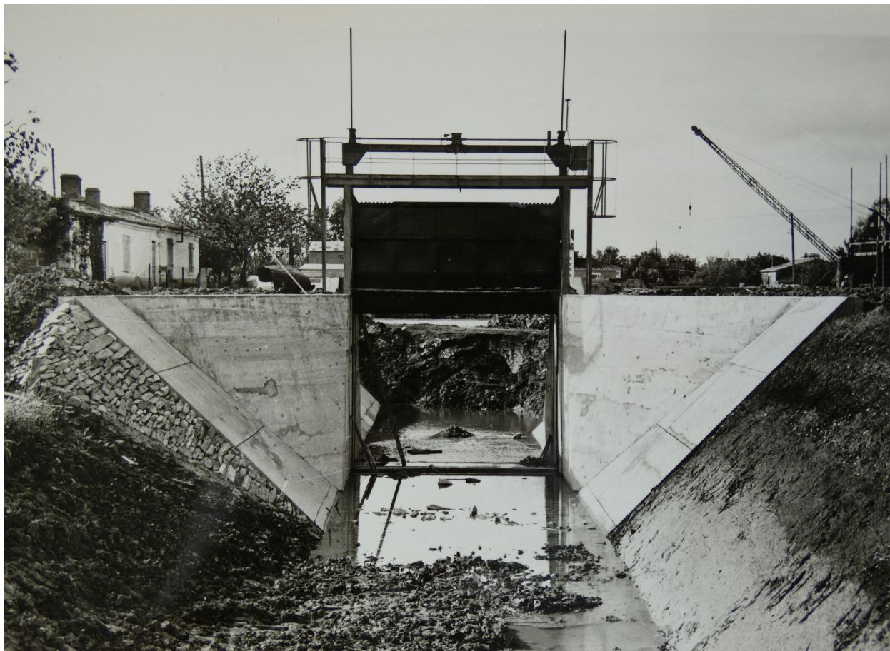
Le barrage achevé, vu depuis l'amont, mai 1961.
