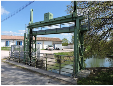
Le portique côté aval. Phot. Yannis Suire IVR75_20211703509NUCA
