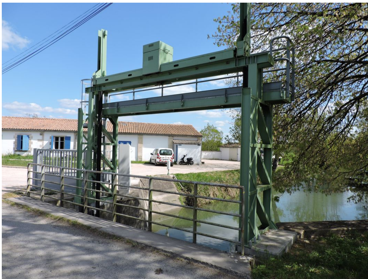
Le portique côté aval.
