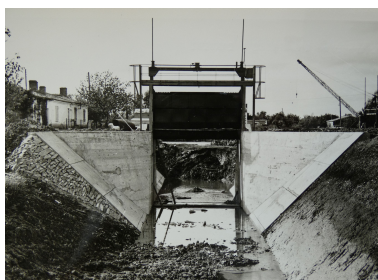
Le barrage achevé, vu depuis l'amont, mai 1961. Phot. Yannis (reproduction) Suire IVR52_20218501965NUCA
