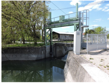
Le barrage côté amont, vu depuis le sud-est. Phot. Yannis Suire IVR75_20211703511NUCA
