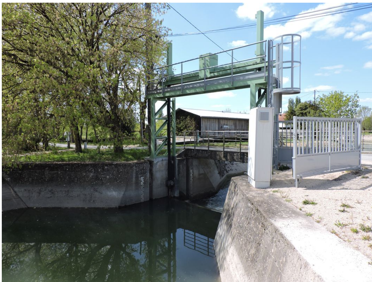
Le barrage côté amont, vu depuis le sud-est.
