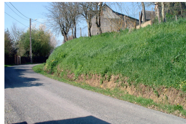
Vestiges de fossés. Phot. Ronan Durandière IVR52_20064903460NUCA
