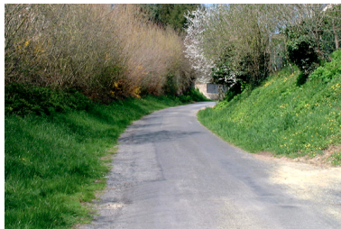
Vestiges de fossés. Phot. Ronan Durandière IVR52_20064903461NUCA
