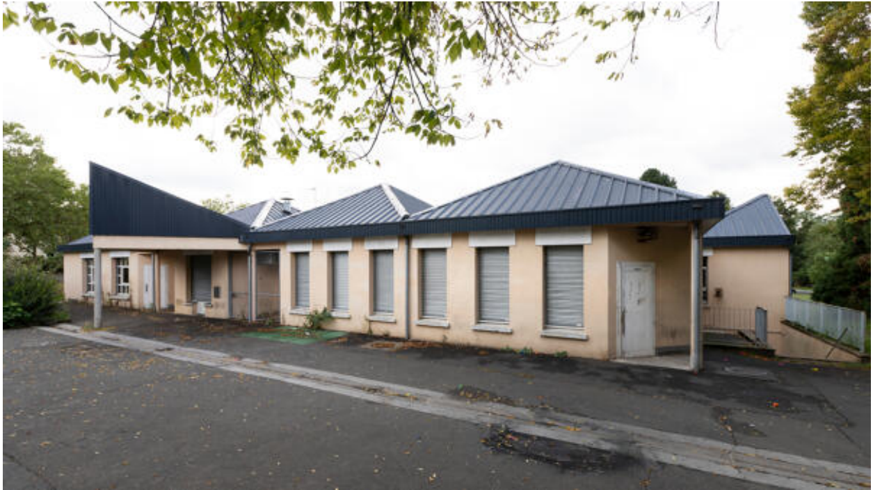
Vue du bâtiment depuis le nord.
