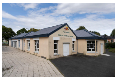
Vue du bâtiment depuis l'ouest. Phot. Thierry Seldubuisson IVR52_20237201946NUCA
