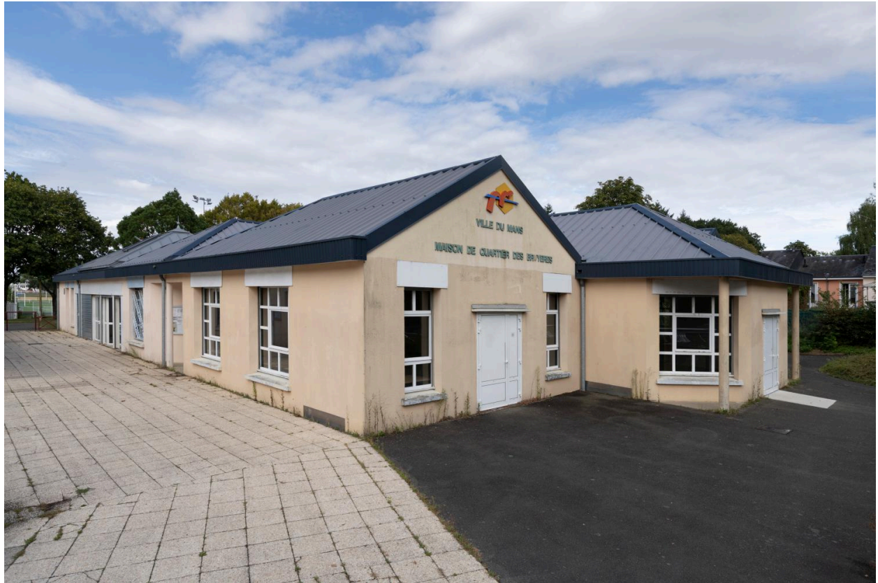
Vue du bâtiment depuis l'ouest.
