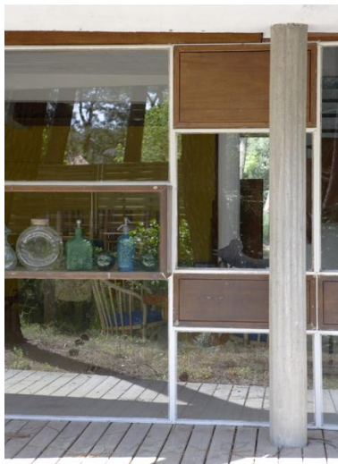
Détail de la façade vitrée, avec casiers de rangement en bois. Phot. Denis Pillet IVR52_20124400317NUCA
