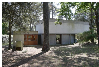
Elévation postérieure. Phot. Denis Pillet IVR52_20124400315NUCA
