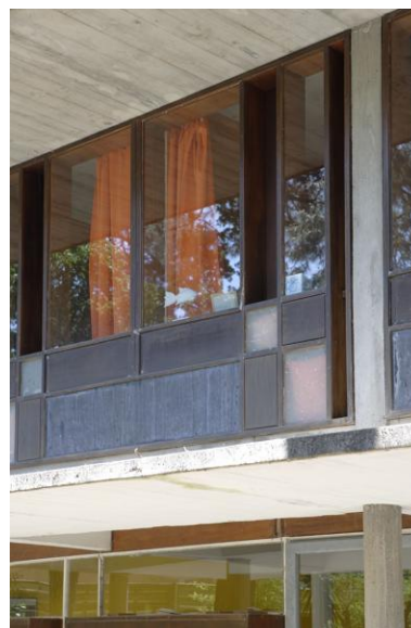
Détail de l'étage de la façade antérieure. Phot. Denis Pillet IVR52_20124400319NUCA
