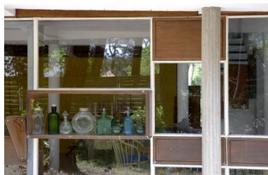
Détail de la façade vitrée, avec casiers de rangement en bois. Phot. Denis Pillet IVR52_20124400318NUCA
