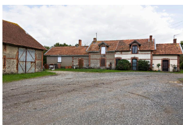
Cour intérieure. Phot. Denis Pillet IVR52_20154400543NUCA
