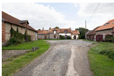
Cour intérieure. Phot. Denis Pillet IVR52_20154400545NUCA
