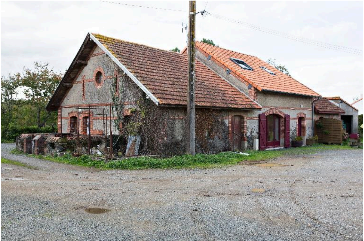
Dépendances, aile ouest, AD01-20-21-22-23-24, cadastre 2018. Dépendance transformée en habitation.
