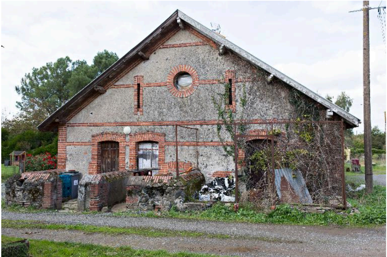
Dépendances, aile ouest, AD01-22-23-24, cadastre 2018. Mur pignon avec soues à cochons.
