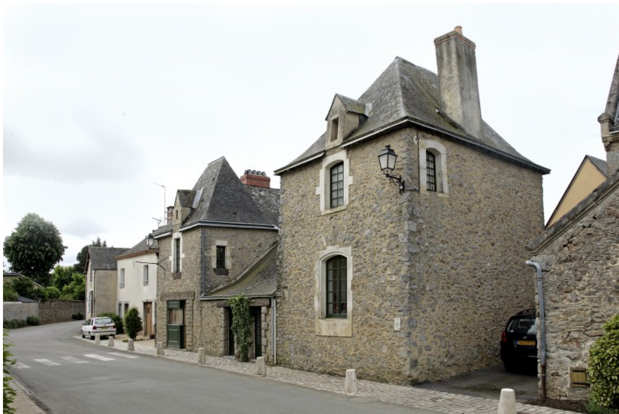
Vue depuis la rue au nord.
