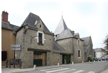
Vue depuis la rue à l'est. Phot. François Lasa IVR52_20075302187NUCA
