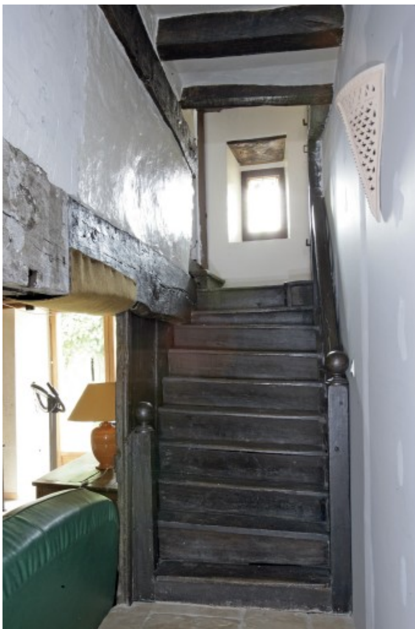
L'escalier situé dans le corps principal vu depuis l'est.
