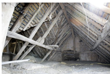
La charpente de la partie sud du corps principal vue depuis le nord. A gauche, le comble du pavillon sud. Phot. François Lasa IVR52_20075302230NUCA
