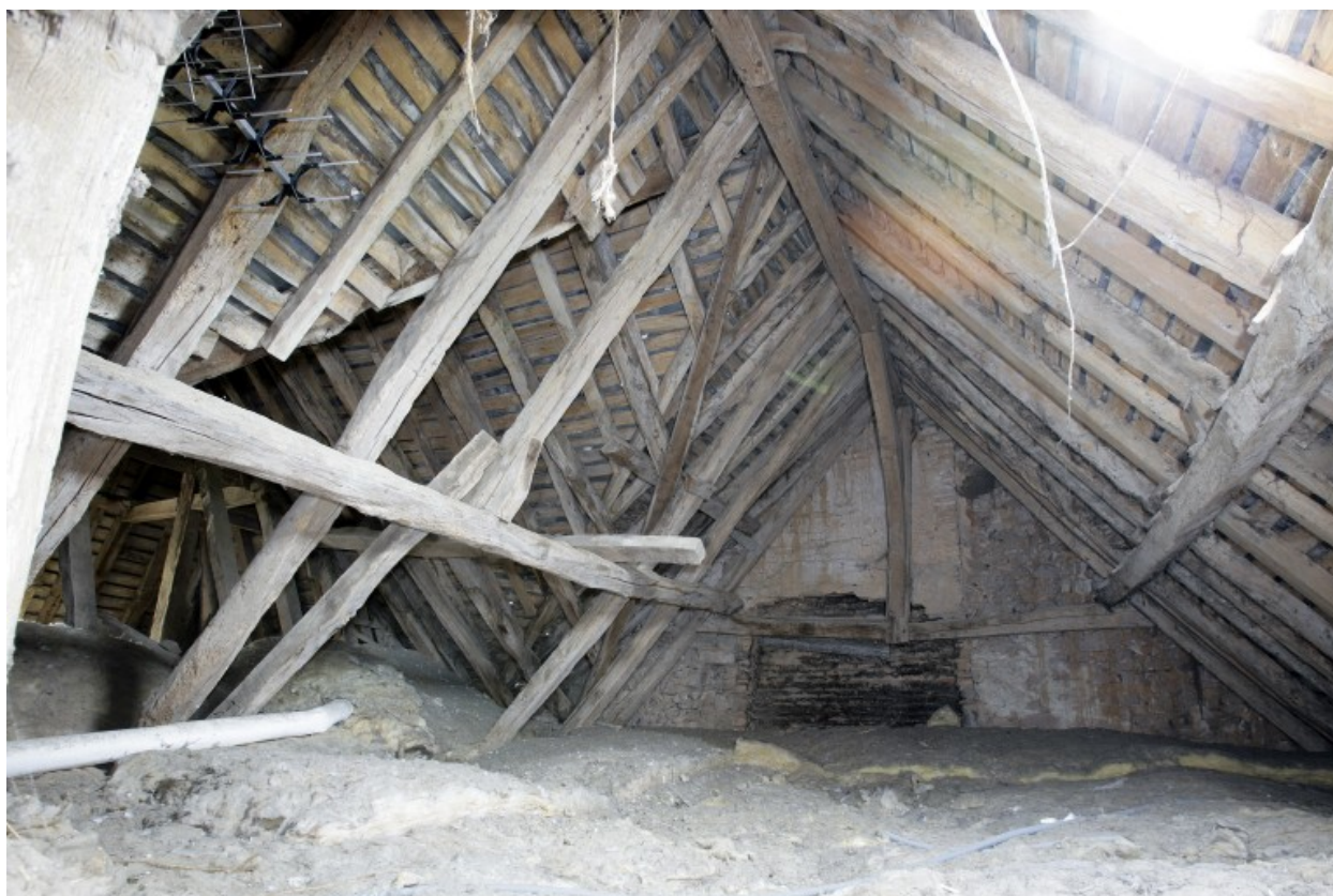
La charpente de la partie sud du corps principal vue depuis le nord. A gauche, le comble du pavillon sud.
