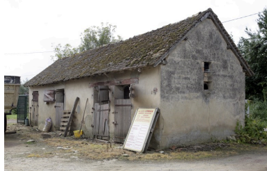
Porcheries vues depuis la cour. Phot. François Lasa IVR52_20077200729NUCA
