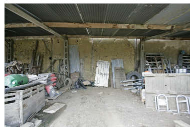
Grange : élévation postérieure en bauge. Phot. François Lasa IVR52_20077200728NUCA
