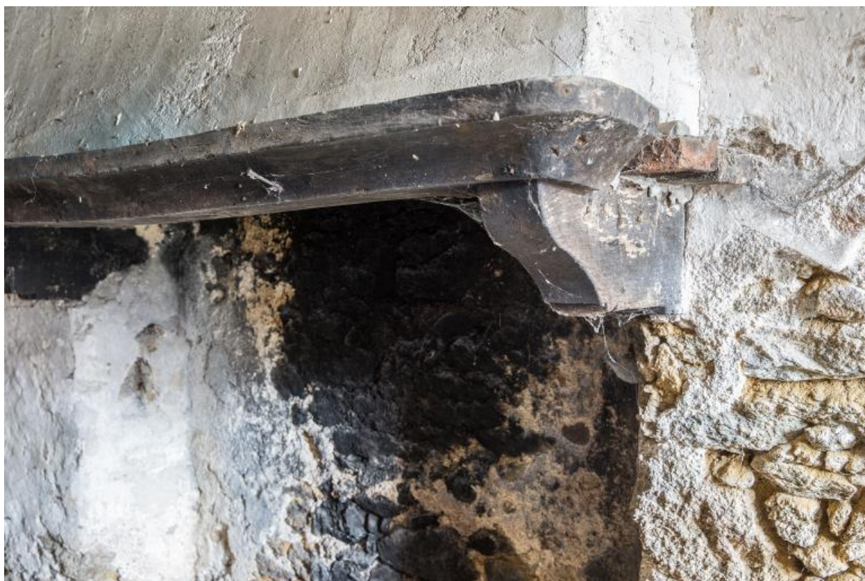
Corbeau et manteau de la cheminée.
