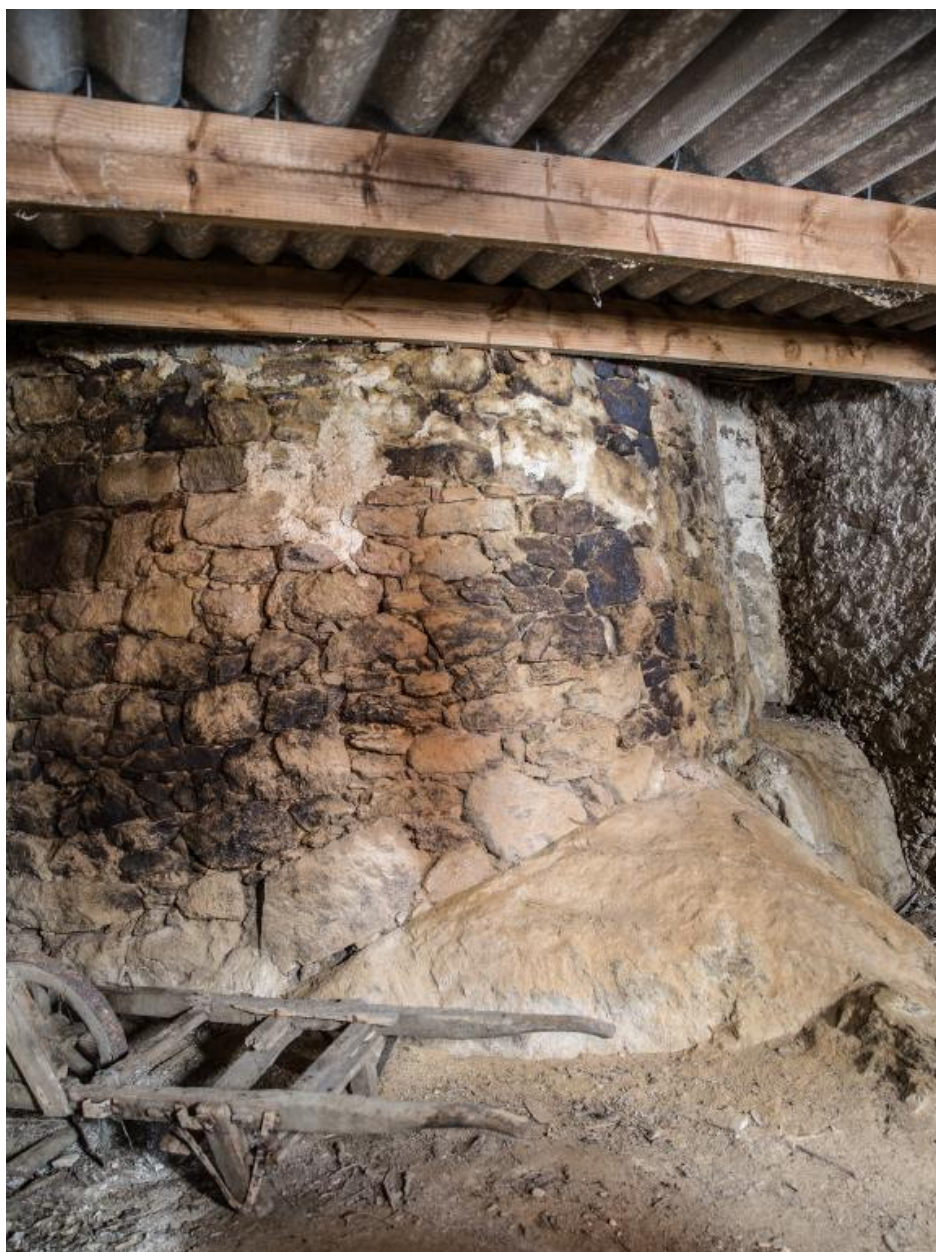
Vue arrière du four commun de plan semi-circulaire. La dépendance prend appui sur la toiture du four.
