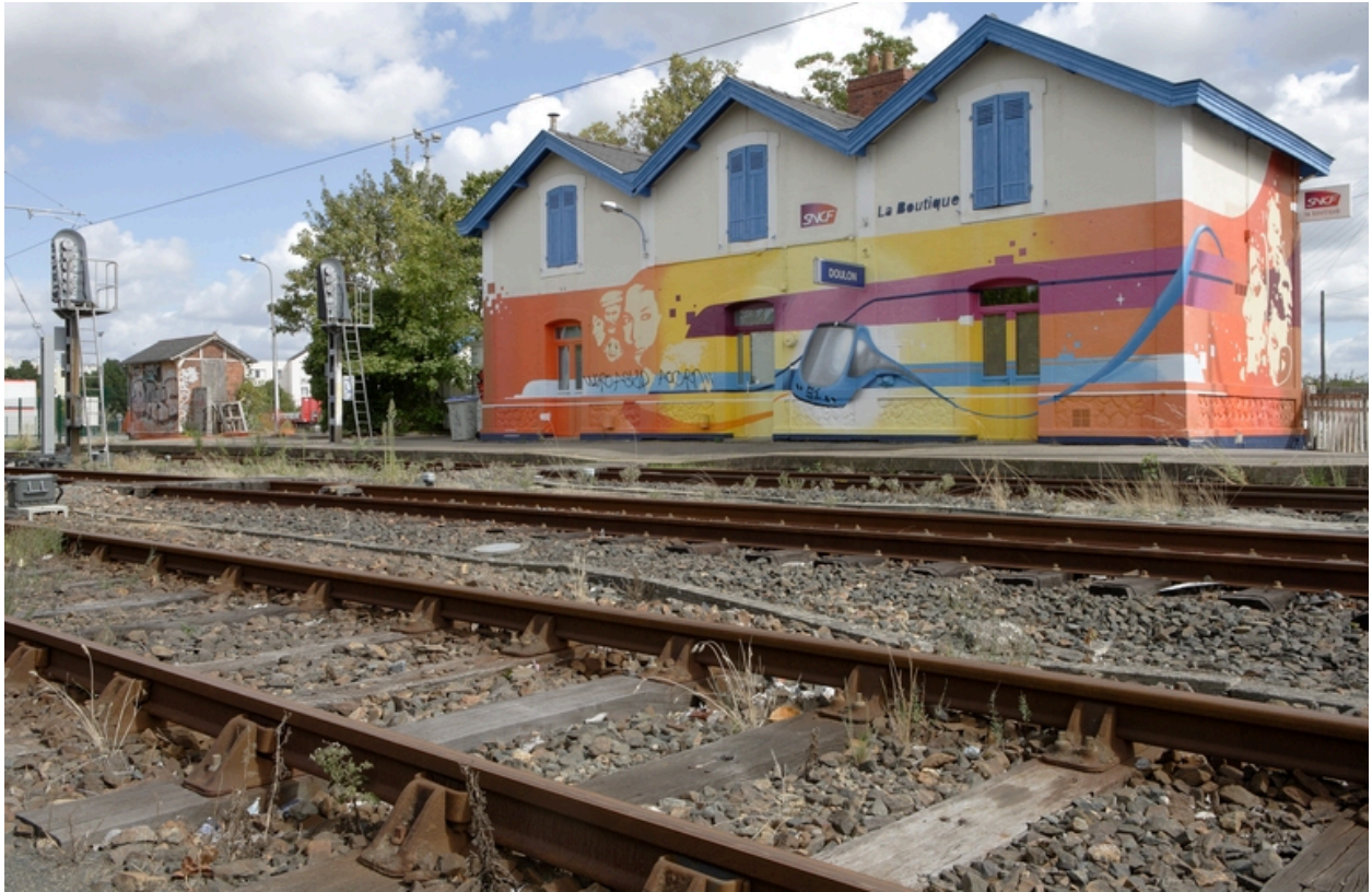
Façade côté voie.
