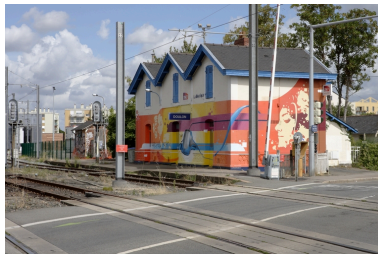
Façade côté rue. Phot. Denis Pillet IVR52_20104402053NUCA
