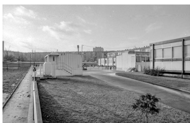
Vue de l'école maternelle des Glonnières avec les classes SCAN. IVR52_20217200014NUCA
