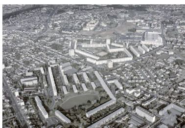
Vue aérienne des deux cités du Ronceray et des Glonnières. IVR52_20217200023NUCA
