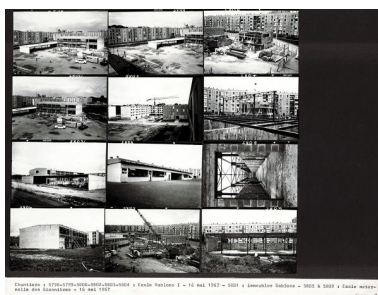
Vue du chantier de l'école maternelle des Glonnières IVR52_20217200012NUCA
