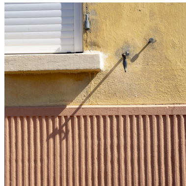
Détail du soubassement strié d'un pavillon. Phot. Pierre-Bernard Fourny IVR52_20217200634NUCA
