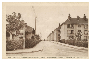
Vue ancienne des immeubles le long de la rue Lazare Weiller. IVR52_20217200107NUCA
