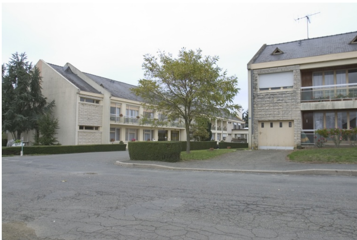
Vue depuis la rue des sports au sud-est des deux bâtiments construits en 1974.
