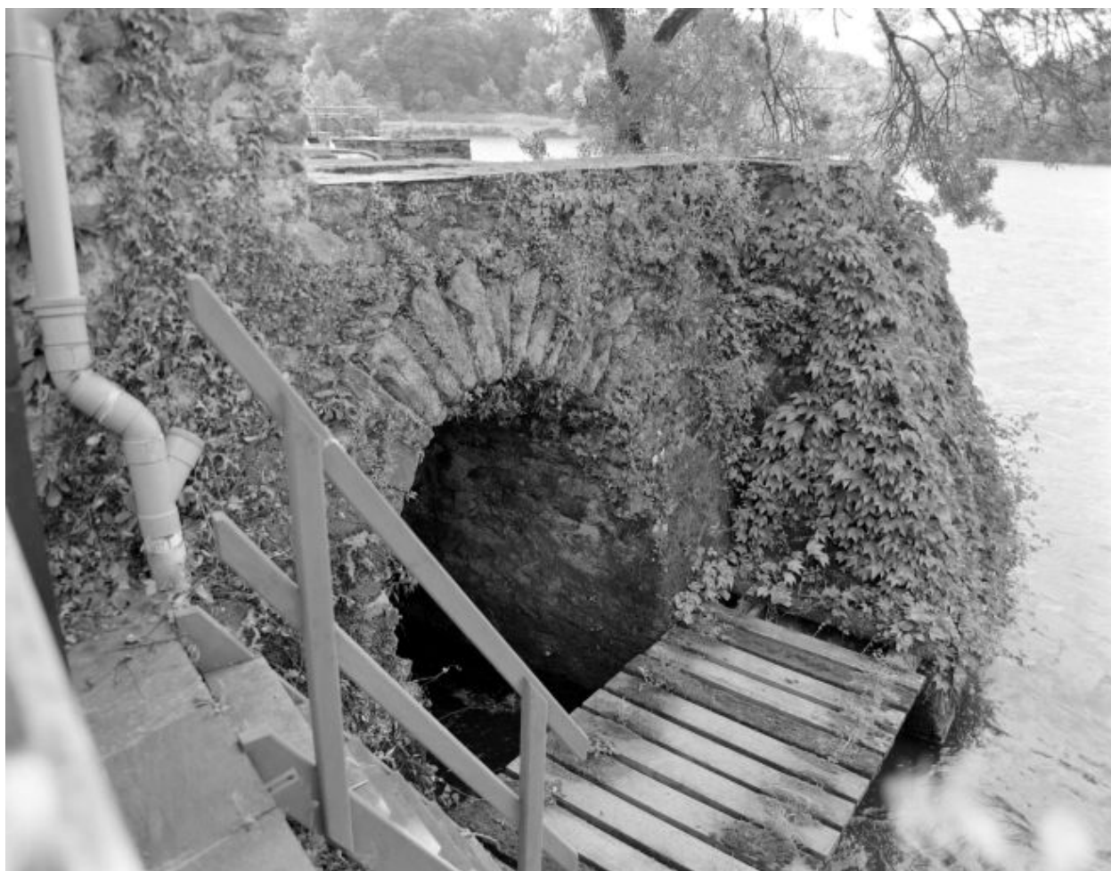
La sortie du coursier, vue d'aval.
