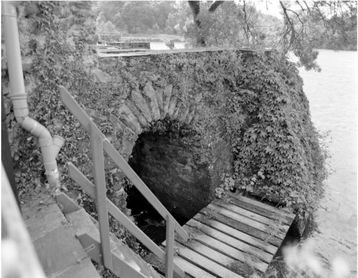
La sortie du coursier, vue d'aval.
