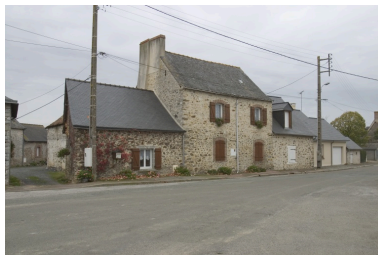
Vue depuis la rue. La maison est constituée des corps de bâtiment bas situés à droite. Phot. François Lasa IVR52_20045303310NUCA
