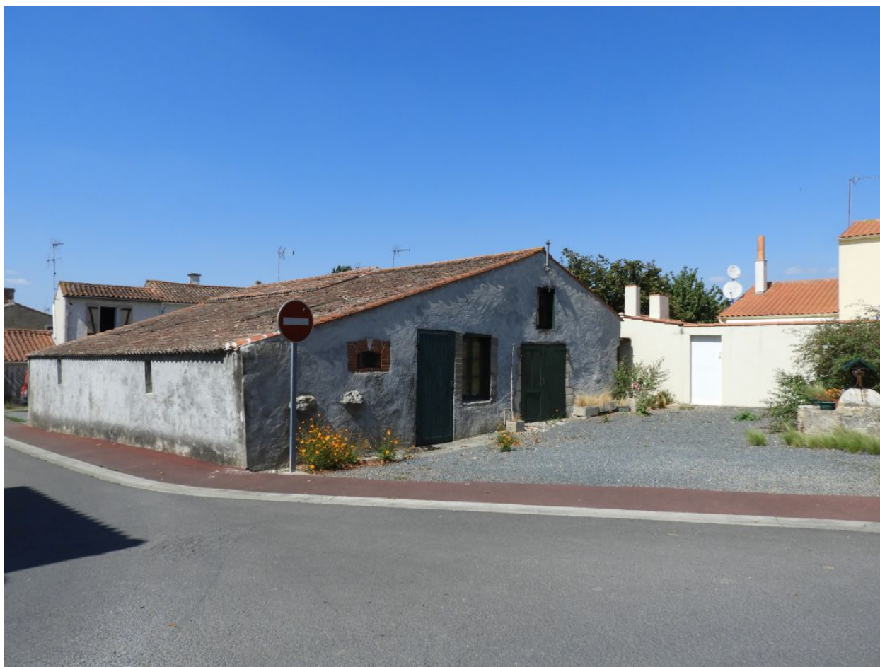
L'ancien chai vu depuis le sud.
