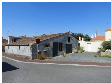
L'ancien chai vu depuis le sud. Phot. Yannis Suire IVR52_20198500004NUCA
