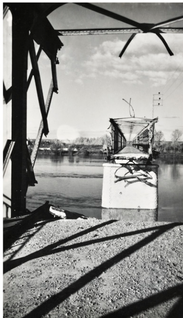
La 6ème travée (depuis la rive gauche) du pont de Montsoreau, après sa destruction par l'armée française le 19 juin 1940. Phot. Bruno Rousseau, Phot. Youenn (reproduction) Communeau IVR52_20114902794NUCA
