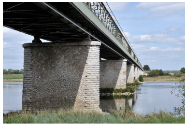
Piles et longerons du pont Phot. Bruno Rousseau IVR52_20114902443NUCA
