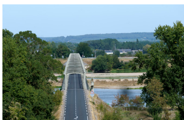
Vue générale depuis le coteau.
