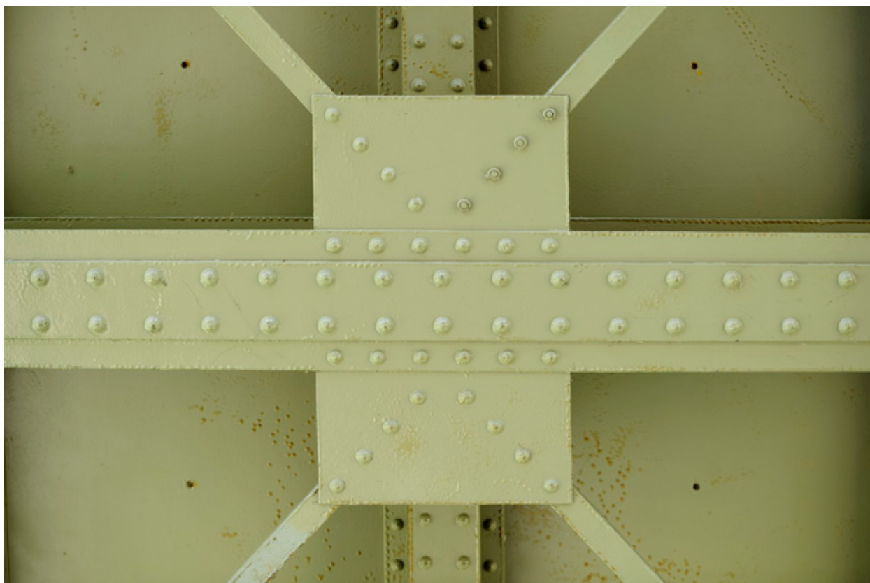
Charpente métallique soutenant le tablier (détail)
