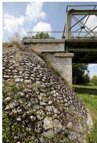
Culée sud Phot. Bruno Rousseau IVR52_20114902451NUCA
