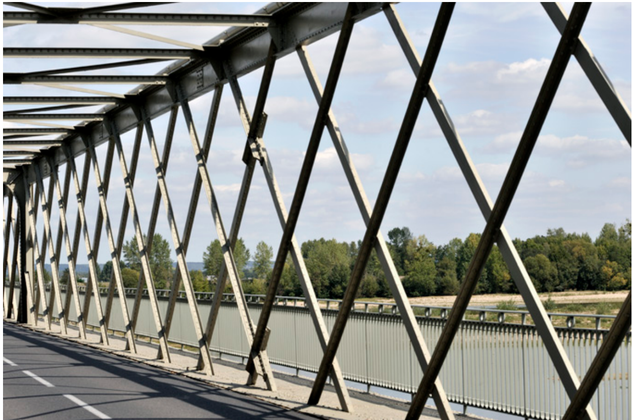
Charpente métallique (détail)
