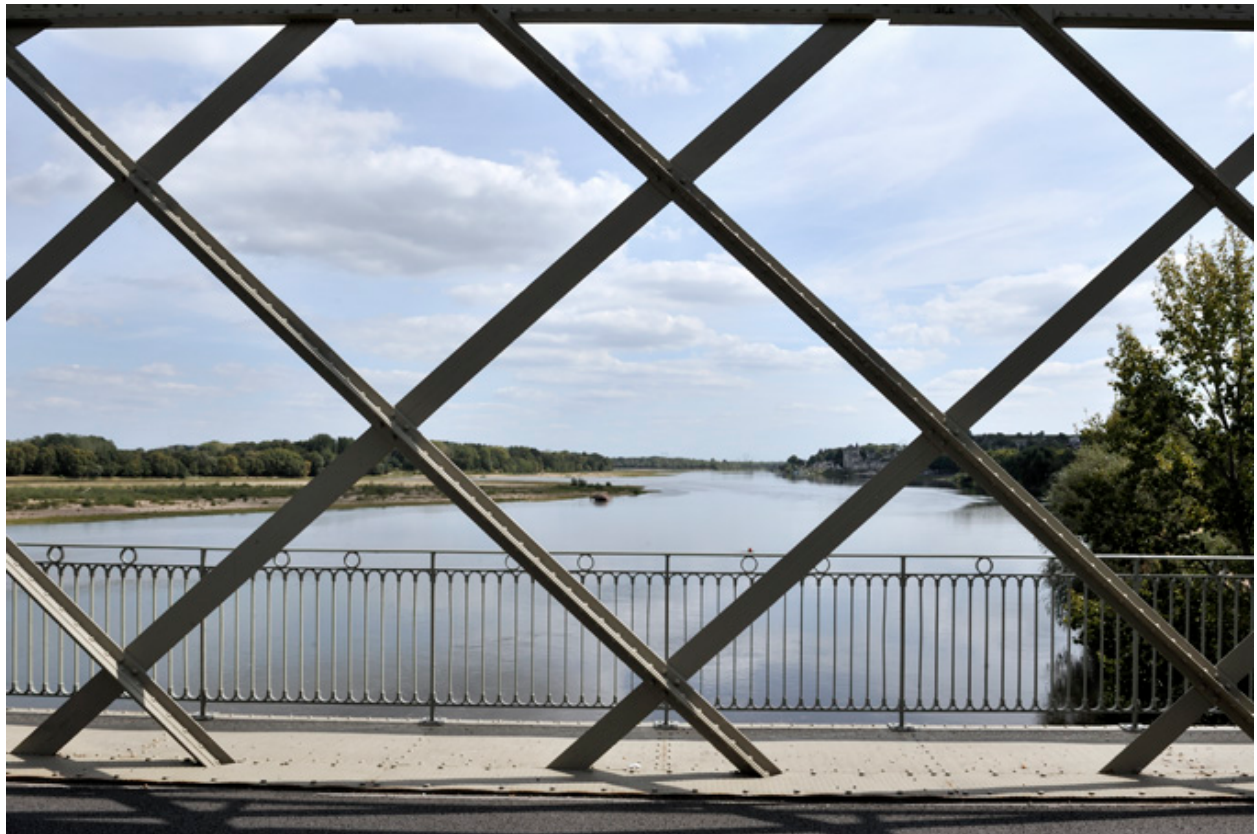
Treillis double de la charpente métallique (détail)
