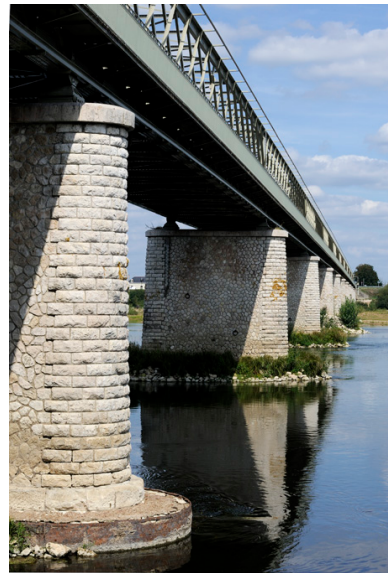
Piles et cage Phot. Bruno Rousseau IVR52_20114902445NUCA
