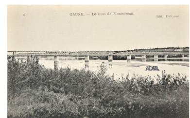
Vue générale du pont, vers 1920. Phot. Bruno Rousseau, Phot. Youenn (reproduction) Communeau IVR52_20114902789NUCA
