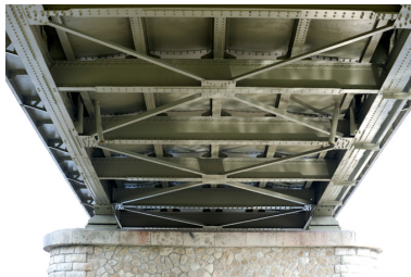
Charpente métallique soutenant le tablier (détail) Phot. Bruno Rousseau IVR52_20114902447NUCA
