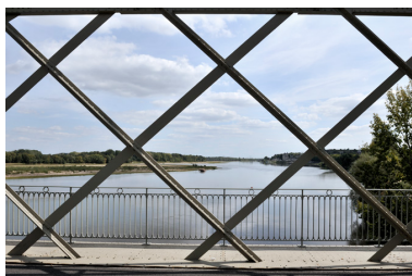
Treillis double de la charpente métallique (détail) Phot. Bruno Rousseau IVR52_20114902441NUCA
