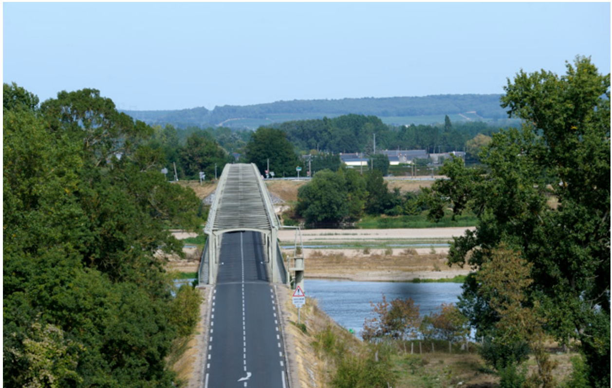
Vue générale depuis le coteau.
