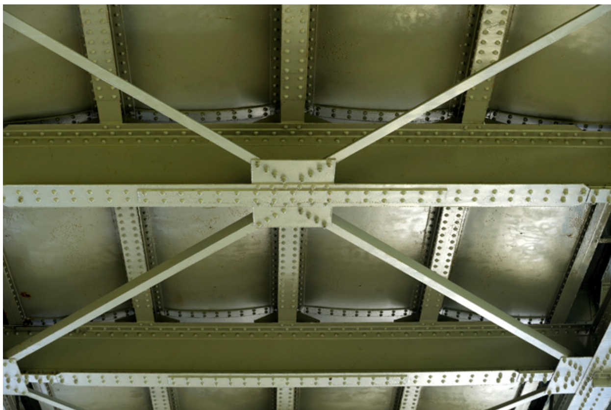
Charpente métallique soutenant le tablier (détail)
