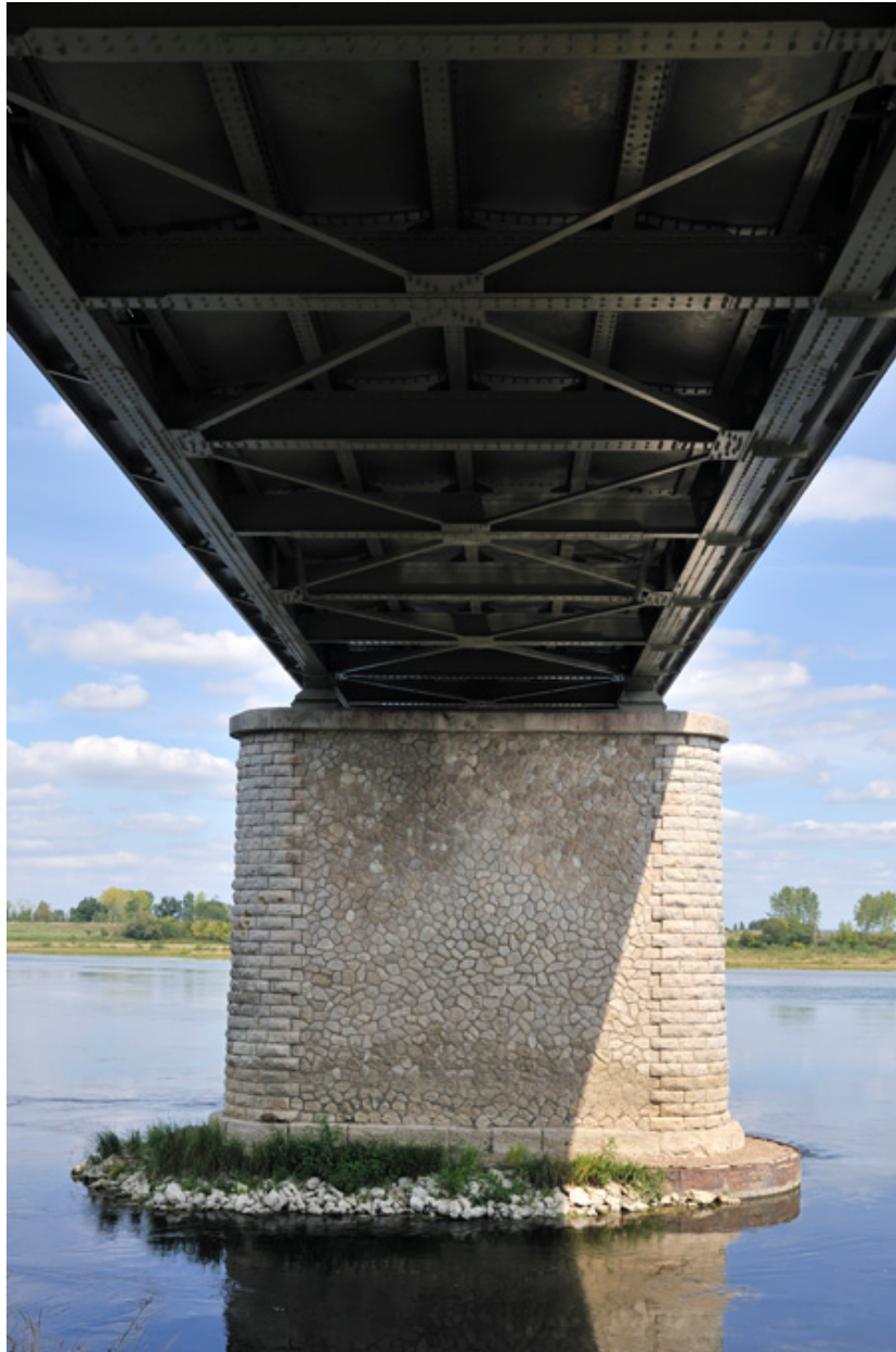
Radier, pile, longerons et sous-longerons du pont
