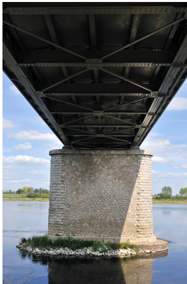
Radier, pile, longerons et sous-longerons du pont Phot. Bruno Rousseau IVR52_20114902444NUCA
