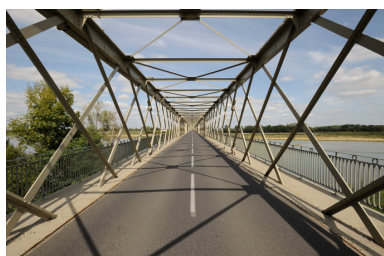
Vue du tablier et de la cage.
