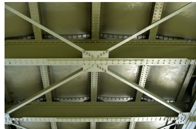
Charpente métallique soutenant le tablier (détail) Phot. Bruno Rousseau IVR52_20114902448NUCA
