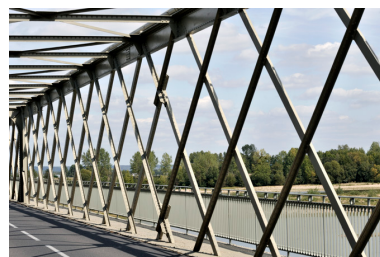
Charpente métallique (détail) Phot. Bruno Rousseau IVR52_20114902436NUCA
