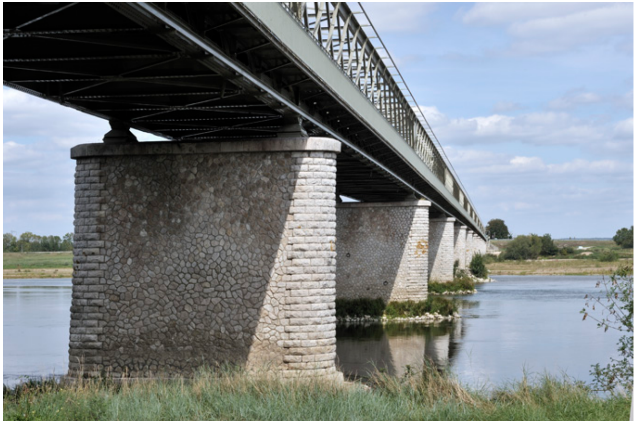
Piles et longerons du pont
