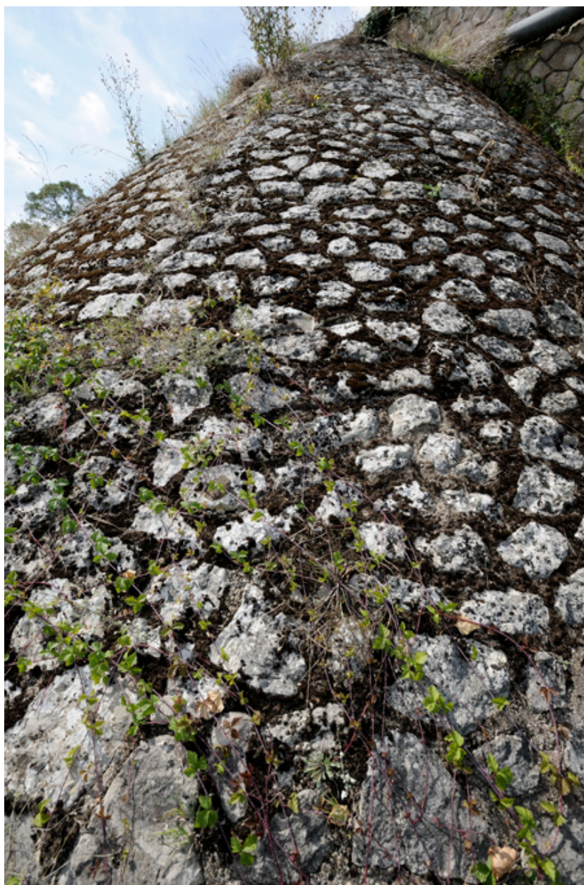
Levée d'accès à l'entrée sud du pont
