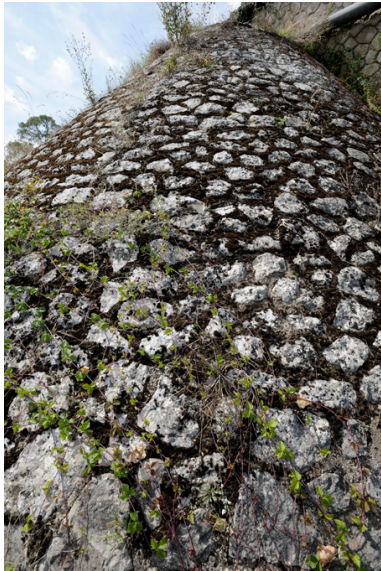
Levée d'accès à l'entrée sud du pont Phot. Bruno Rousseau IVR52_20114902452NUCA
