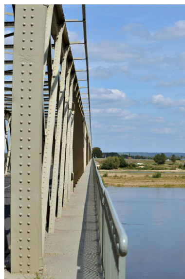
Voie piétonne, entre cage et garde-corps (est) Phot. Bruno Rousseau IVR52_20114902433NUCA
