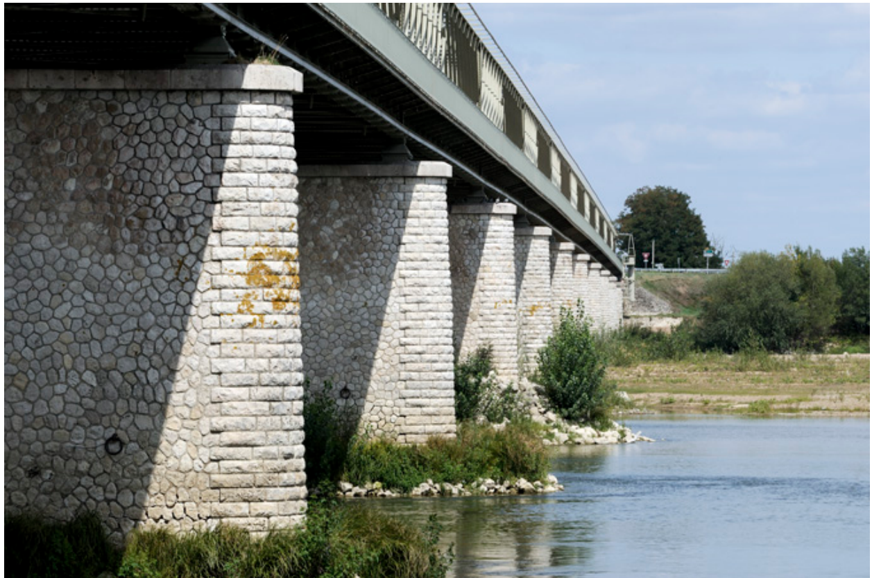
Face est du pont, depuis la berge
