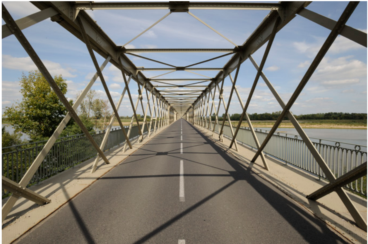
Vue du tablier et de la cage.
