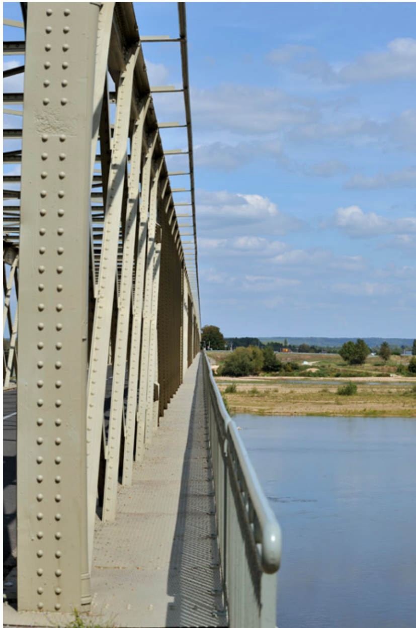
Voie piétonne, entre cage et garde-corps (est)
