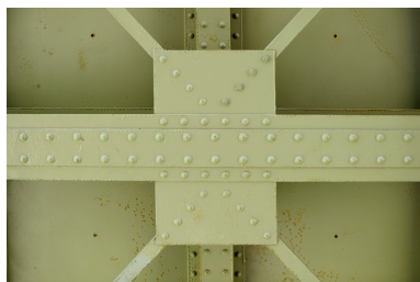
Charpente métallique soutenant le tablier (détail) Phot. Bruno Rousseau IVR52_20114902449NUCA
