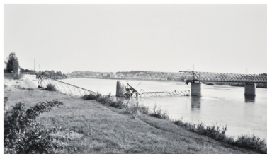
Le pont de Montsoreau, vu de la rive droite de la Loire, après sa destruction par l'armée allemande le 10 août 1944. Phot. Bruno Rousseau, Phot. Youenn (reproduction) Communeau IVR52_20114902796NUCA
