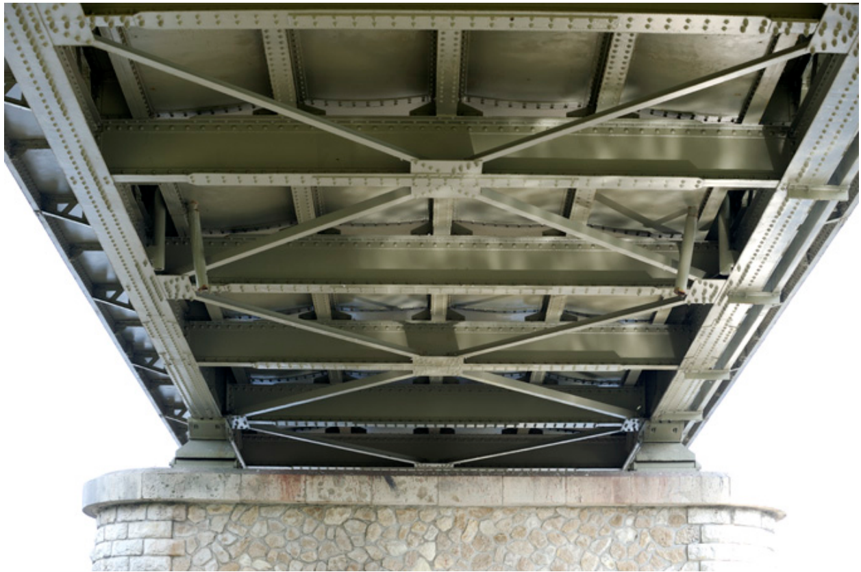
Charpente métallique soutenant le tablier (détail)
