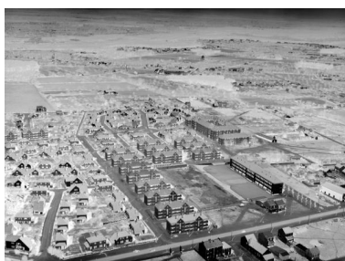
Vue de la partie nord de la cité des Pins en négatif. IVR52_20217200119NUCA
