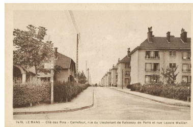
Vue en perspective sur la rue Lazare-Weiller. IVR52_20217200107NUCA
