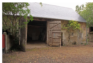
Grange-étable. Phot. Jean-Baptiste Darrasse IVR52_20107201141NUCA
