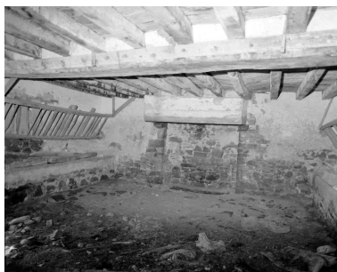
Vue intérieure de l'ancienne pièce d'habitation du moulin (?), actuelle étable à vaches.
