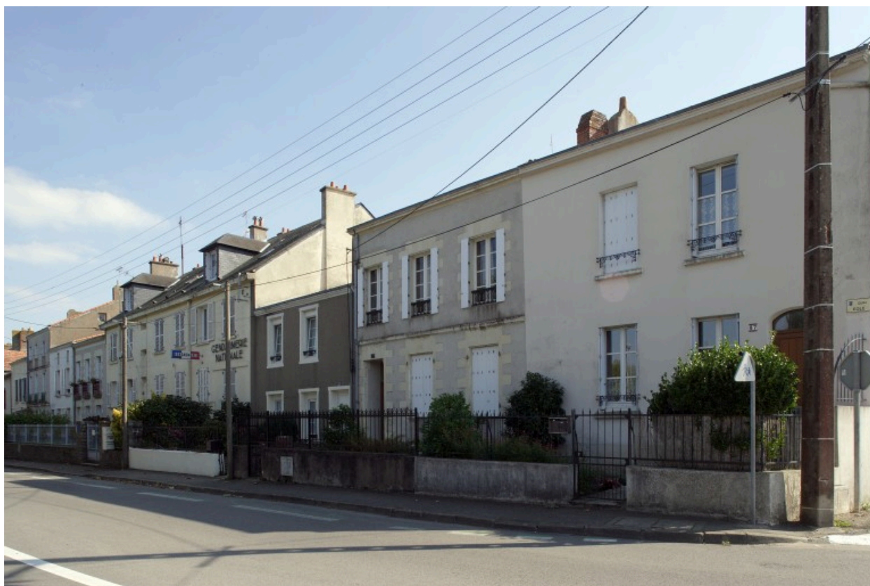
Vue partielle du quai.
