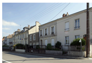
Vue partielle du quai. Phot. Denis Pillet IVR52_20054401434NUCA
