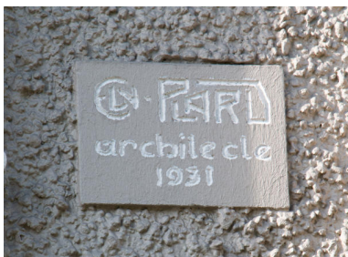
Vue de la plaque d'architecte sur la maison. Phot. Pierre-Bernard Fourny
