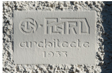
Vue de la plaque d'architecte en façade de la maison. Phot. Thierry Seldubuisson IVR52_20237200308NUCA
