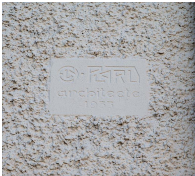
Plaque de l'architecte. Phot. Pierre-Bernard Fourny IVR52_20197200462NUCA
