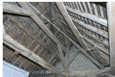
La charpente du logis vue depuis l'est. Phot. François Lasa IVR52_20045302496NUCA
