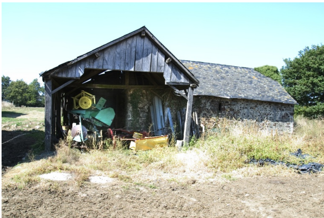
La remise vue depuis l'est.
