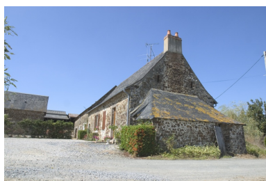
Le logis-étable vu depuis le sud-est. A gauche, l'étable-grange. Phot. François Lasa IVR52_20045302498NUCA
