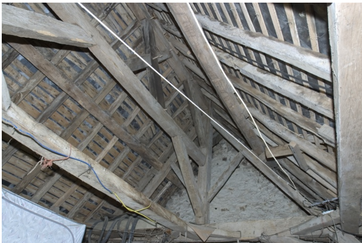
La charpente du logis vue depuis l'est.
