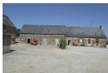
Le logis-étable vu depuis le sud. Phot. François Lasa IVR52_20045302490NUCA
