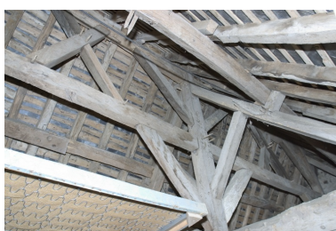
La charpente du logis : les pannes sous-faîtières. Phot. François Lasa IVR52_20045302497NUCA
