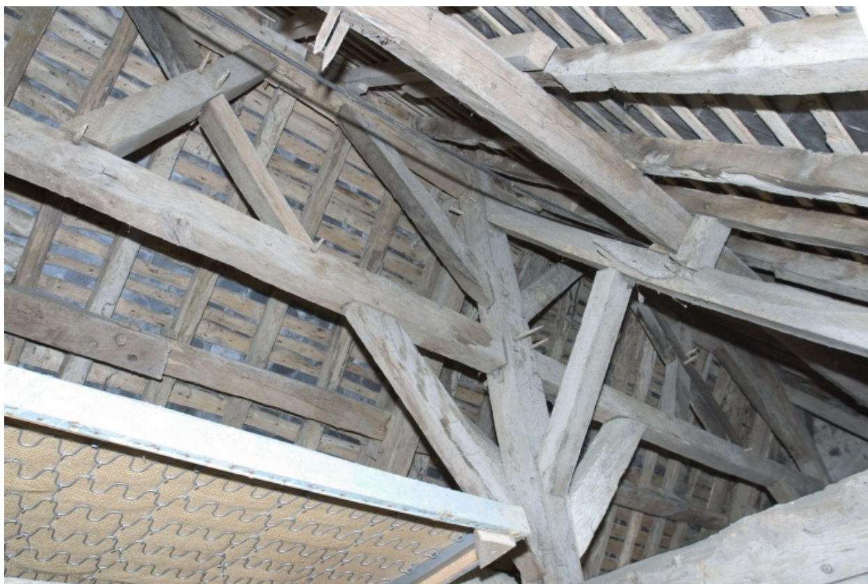
La charpente du logis : les pannes sous-faîtières.
