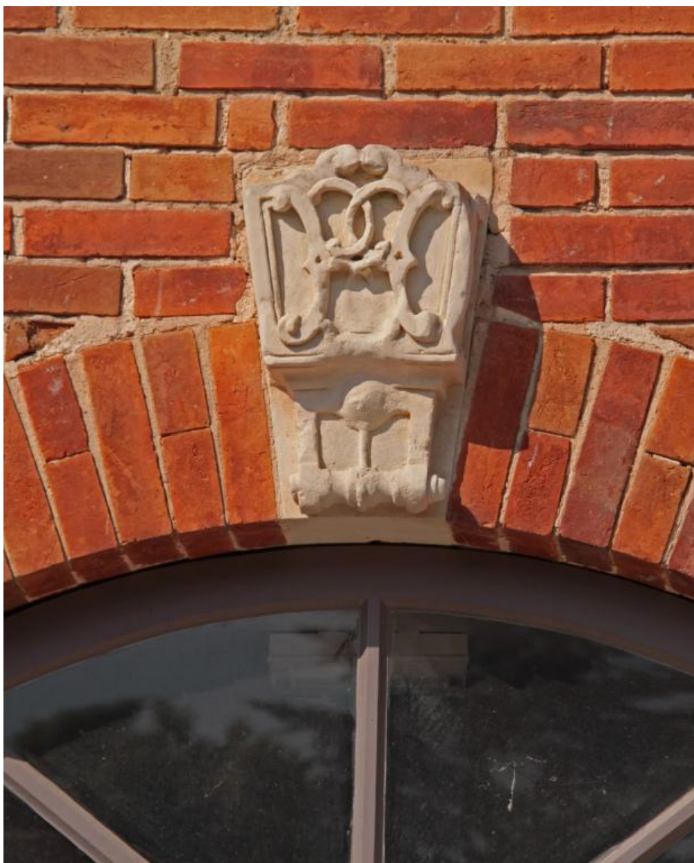
Rez-de-chaussée, travée 4 : clé du linteau.
