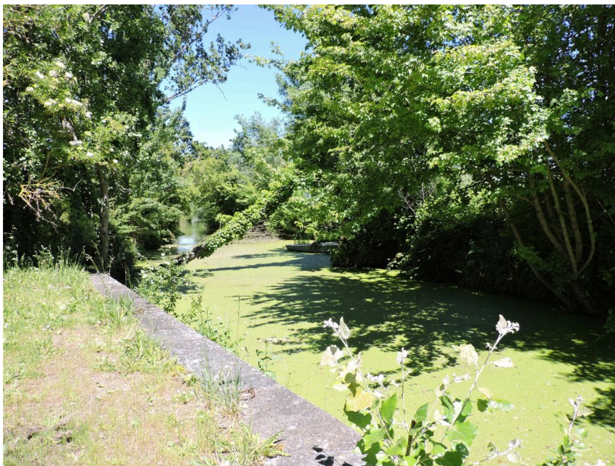
Le quai et la route d'eau vus en direction du nord.
