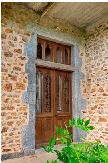
La porte principale. Phot. Pierre-Bernard Fourny IVR52_20235301005NUCA
