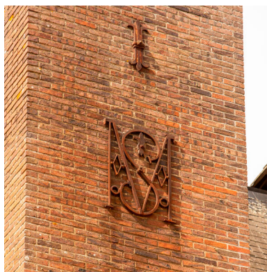
Un tirant au monogramme SM sur une souche de cheminée. Phot. Pierre-Bernard Fourny IVR52_20235300994NUCA
