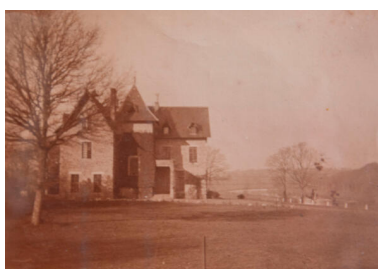
Une photographie du château du début du XXe siècle. Repro. Pierre-Bernard Fourny IVR52_20235301032NUCA
