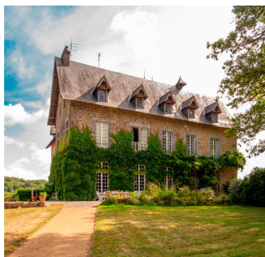
L'élévation vers le jardin et les communs. Phot. Pierre-Bernard Fourny IVR52_20235301011NUCA
