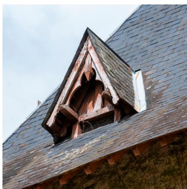
Une lucarne. Phot. Pierre-Bernard Fourny IVR52_20235300997NUCA
