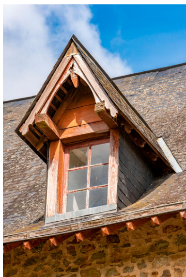
Une lucarne. Phot. Pierre-Bernard Fourny IVR52_20235300995NUCA
