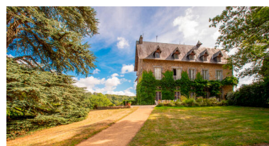
L'élévation vers le jardin et les communs. Phot. Pierre-Bernard Fourny IVR52_20235301012NUCA
