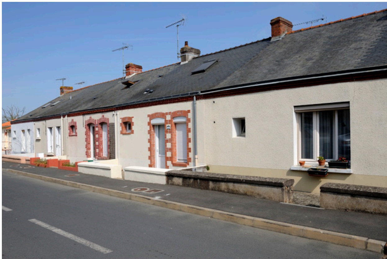
Première génération de logements ouvriers : maisons ouvrières de la Société Anonyme de Chaussures, rue Victor Hugo, Saint-Macaire-en-Mauges.
