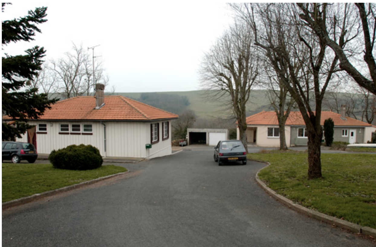
Trois maisons de porions de type Fillod ou architecture semi-Métallique, Saint-Crespin-sur-Moine.
