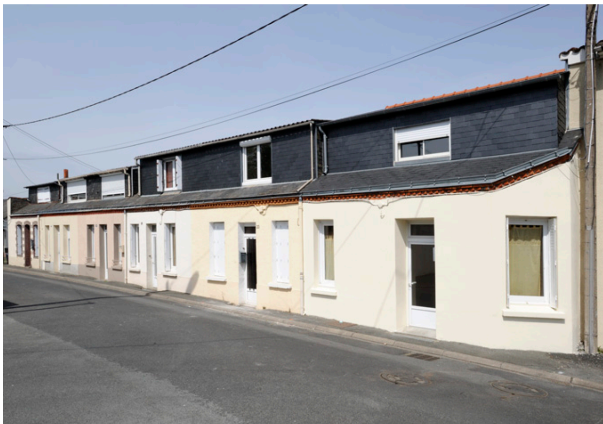
Première génération de logements ouvriers : maisons ouvrières de la Macairoise, rue des Dames, Saint-Macaire-en-Mauges.
