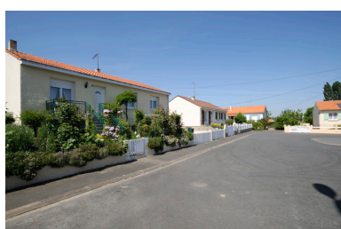
Troisième génération des logements ouvriers : lotissement Gambetta de 57 lots, commandité par Coiffard-Pasquier et la SA Pasquier frères, en 1958, Saint-Macaire-en-Mauges. Phot. Bruno Rousseau, Phot. Youenn Communeau IVR52_20114901456NUCA
