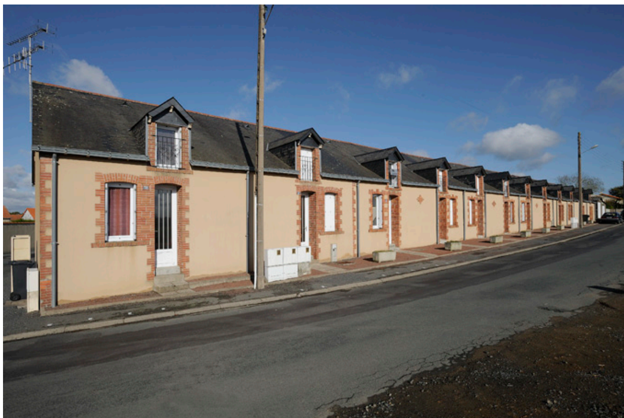
Première génération de logements ouvriers : maisons ouvrières de la Société Ripoche, rue Jeanne d'Arc, Saint-André-de-la-Marche.
