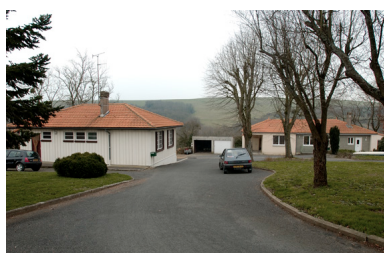
Trois maisons de porions de type Fillod ou architecture semi-Métallique, Saint-Crespin-sur-Moine. Phot. Bruno Rousseau IVR52_20074900313NUCA
