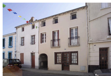
La façade antérieure des maisons n° 87 et n° 89 rue du Général-De-Gaulle.
