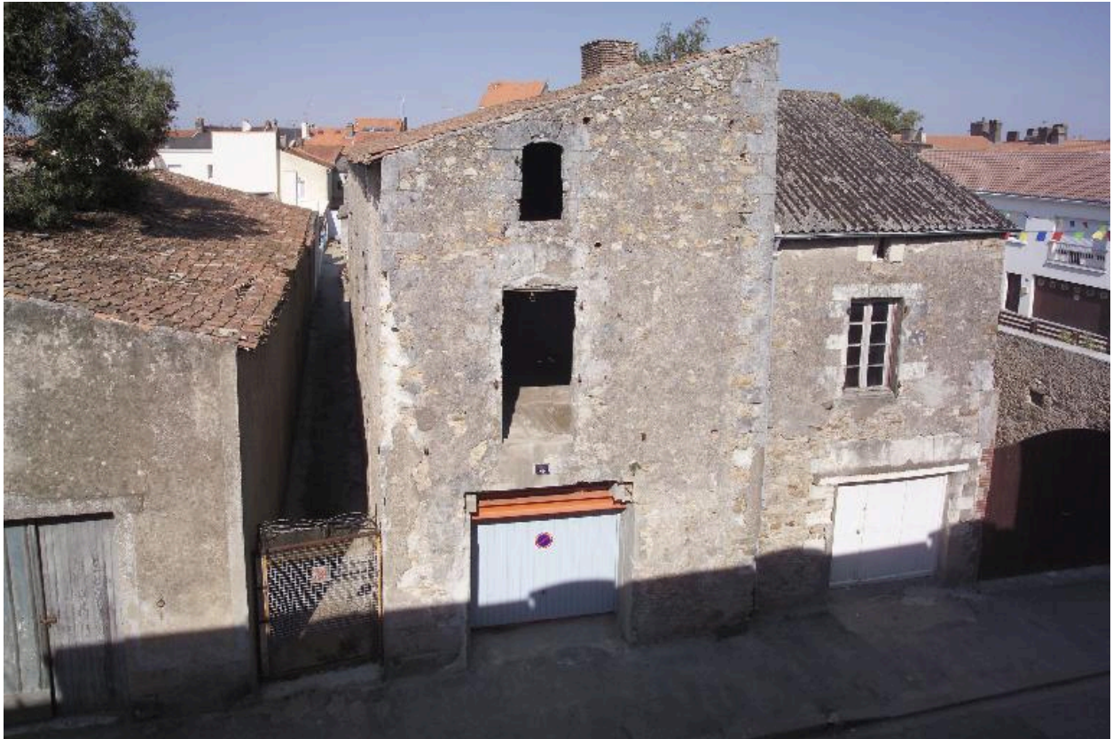
Les façade antérieures des maisons et dépendances n° 6, n° 8, n° 10 rue du Faisan.
