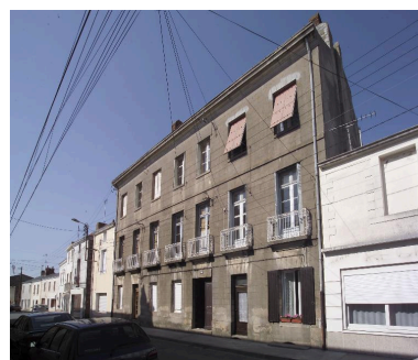
La façade antérieure de la maison n° 26 rue du Faisan. Phot. Denis Pillet IVR52_20034401220NUCA
