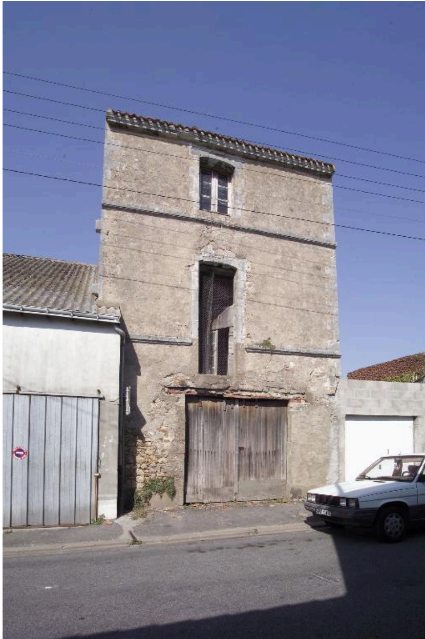
Façade antérieure, n° 46 rue du Faisan.
