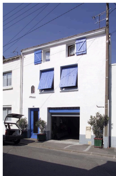
La façade antérieure de la maison n° 18 rue du Faisan. Phot. Denis Pillet IVR52_20034401217NUCA
