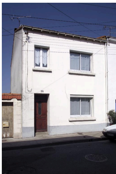
La façade antérieure de la maison n° 20 rue du Faisan. Phot. Denis Pillet IVR52_20034401218NUCA
