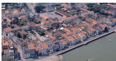
Vue aérienne depuis la Loire, 1998. Autr. Christophe Yvernogeu, Phot. François Lasa IVR52_20054401350NUCA
