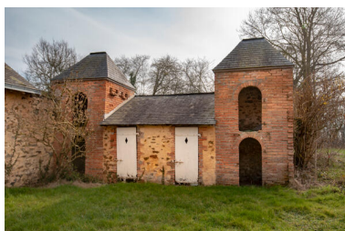
La volaillerie. Phot. Pierre-Bernard Fourny IVR52_20235300127NUCA
