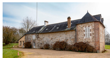
Le corps d'habitation, élévation postérieure. Phot. Pierre-Bernard Fourny IVR52_20235300121NUCA
