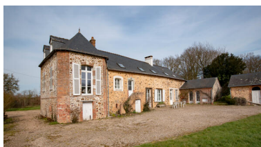
Le corps d'habitation, élévation antérieure. Phot. Pierre-Bernard Fourny IVR52_20235300123NUCA
