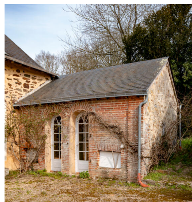
Le toit à porcs. Phot. Pierre-Bernard Fourny IVR52_20235300126NUCA
