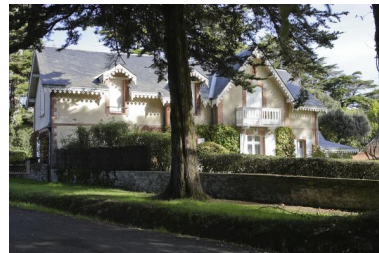
Vue d'ensemble de la villa Les Pâquerettes. Phot. Denis Pillet IVR52_20094401306NUCA
