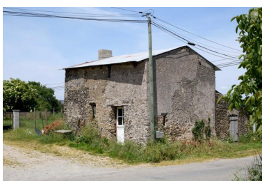
La Jolivetière. Vue de la ferme n° 2 depuis l'ouest. Phot. Armelle Maugin IVR52_20254900762NUCA
