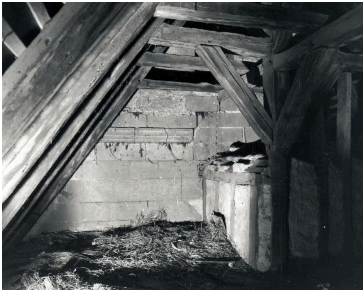
Corps d'entrée : vestiges de l'élévation postérieure vus depuis les combles du bâtiment des écuries.
