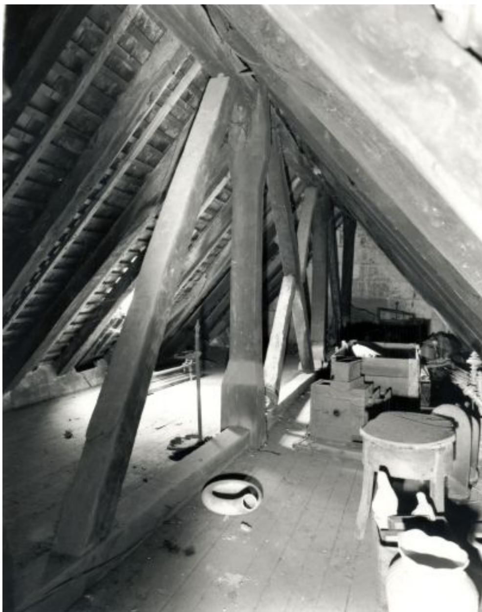
Corps de logis principal : partie supérieure du comble, en axe longitudinal, de la droite vers la gauche.
