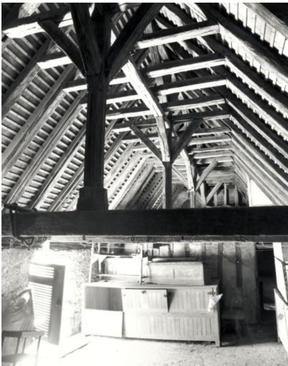
Bâtiment des écuries : comble, avec en fond le pignon sur rue.
