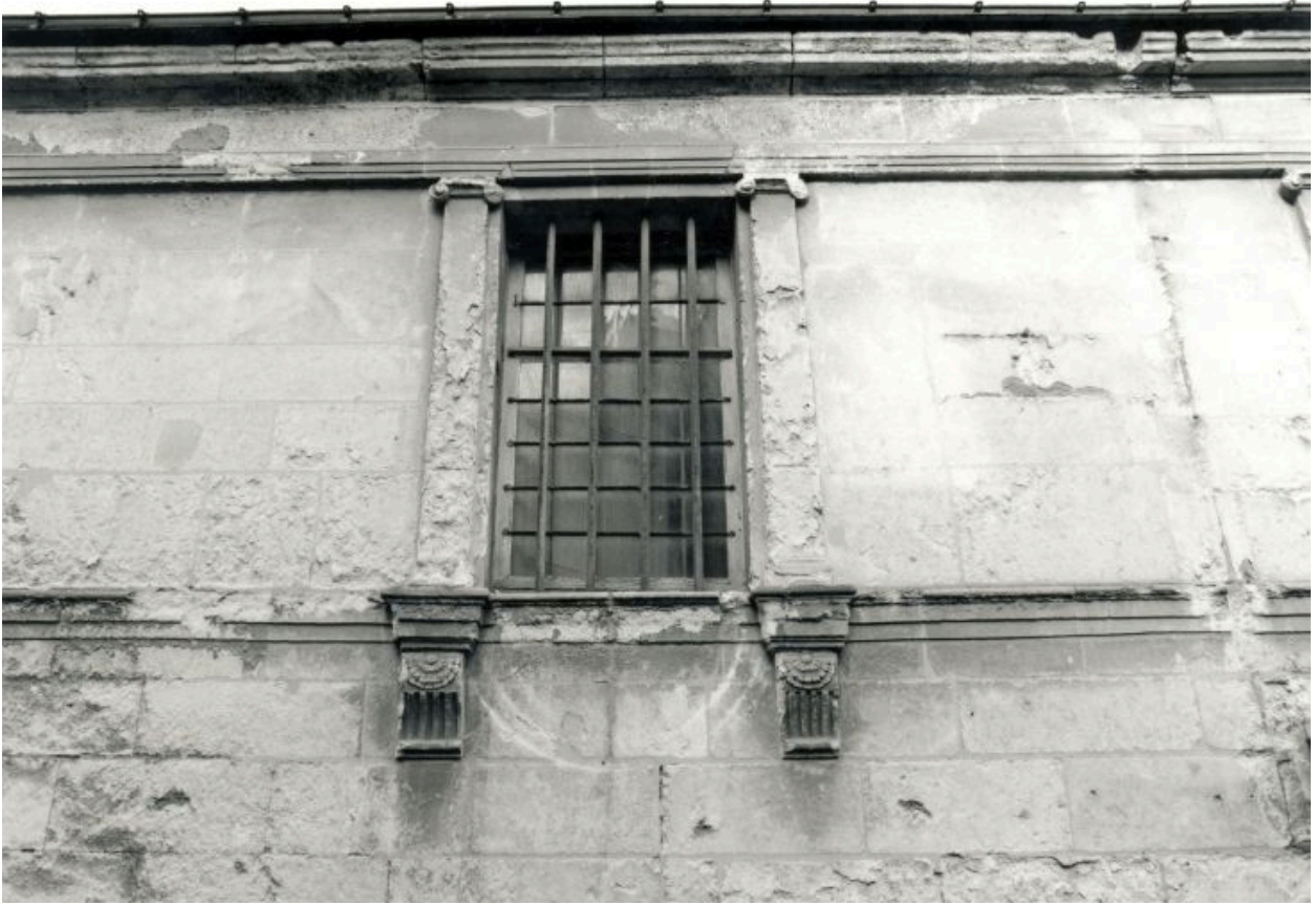
Corps d'entrée, élévation sur rue : 2e baie d'étage.
