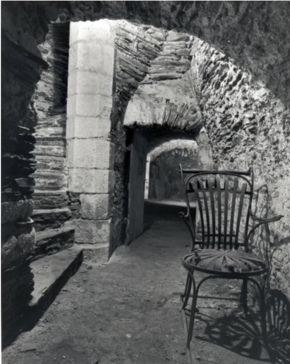
Sous-sol : base de l'escalier en vis. Au fond, cave située sous la cour.
