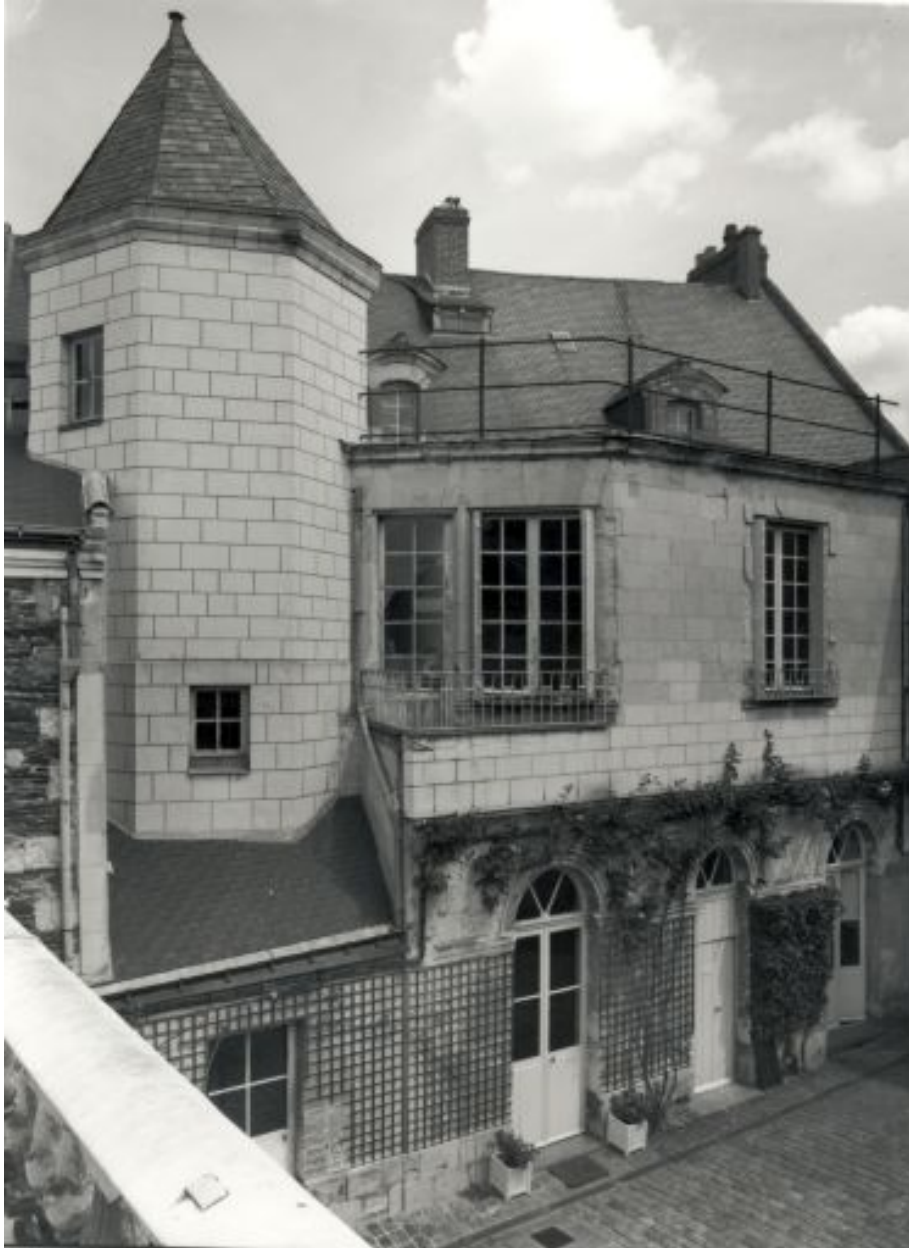
Corps de logis principal : élévation antérieure.
