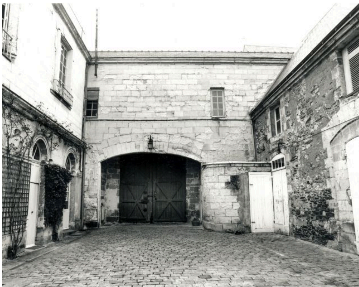
Corps d'entrée : élévation postérieure, sur la cour. A gauche, le logis. A droite, les écuries.
