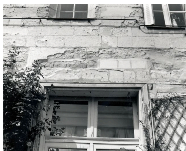
Corps de logis principal, élévation postérieure sur jardin, rez-de- chaussée : vestiges de la plate- bande de l'ancienne baie droite. Phot. François Lasa IVR52_19944900414X
