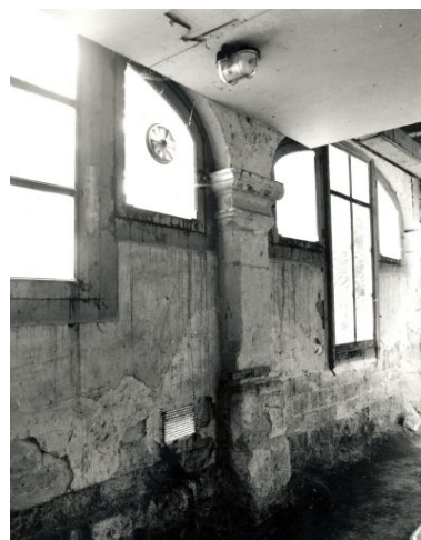
Galerie : corps principal, premier niveau : élévation intérieure d'une arcade. Phot. François Lasa IVR52_19934900326X
