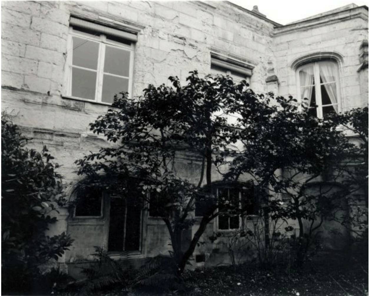
Galerie : corps principal, élévation sur le jardin : partie gauche.
