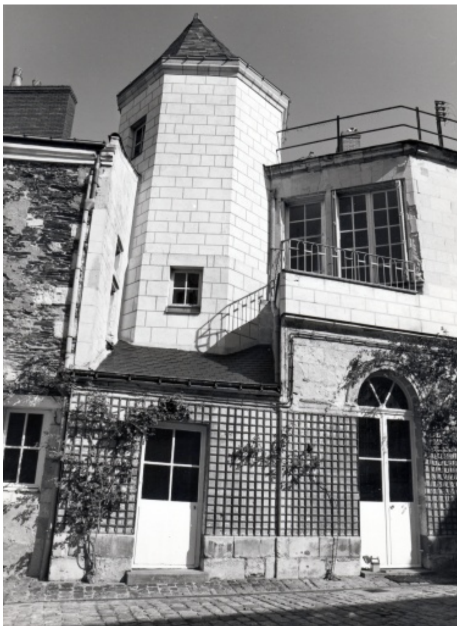
Tour d'escalier, à l'angle des deux corps de logis.
