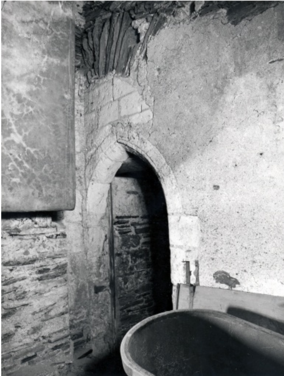
Corps de logis gauche, cave gauche, angle postérieur droit : porte communiquant avec la cave droite de ce même corps.
