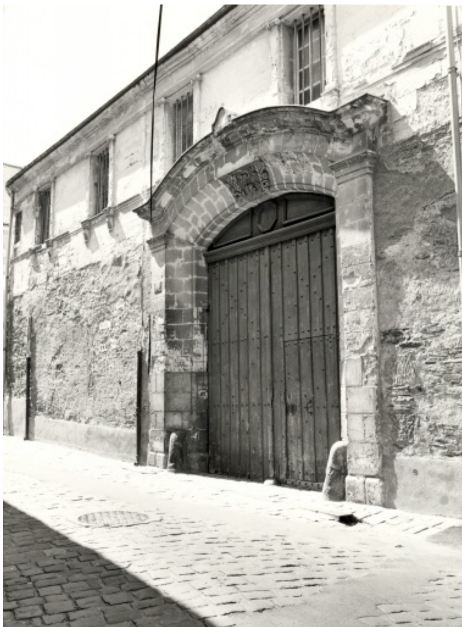
Corps d'entrée, élévation sur rue, vue d'ensemble.
