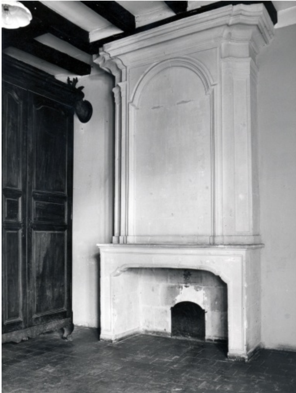
Bâtiment des écuries, rez-de-chaussée, pièce d'habitation gauche, mur latéral droit : cheminée.
