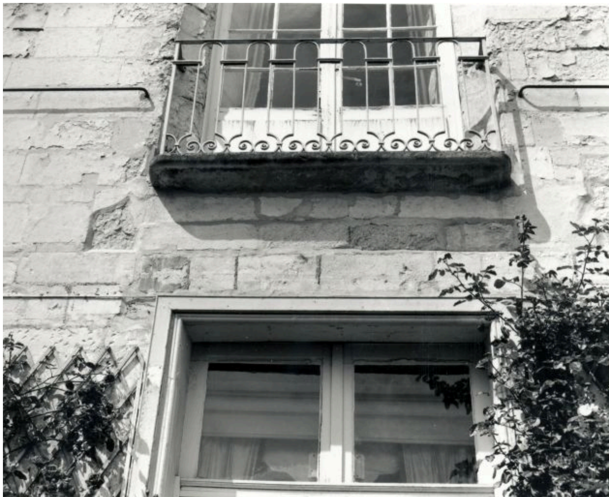
Corps de logis principal, élévation postérieure sur jardin, rez-de-chaussée : vestiges de la plate-bande de l'ancienne baie centrale.
