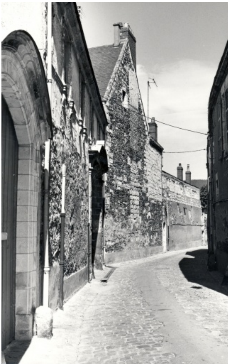
Elévations sur rue : corps d'entrée avec le portail, mur-pignon droit du corps de logis principal, et élévations postérieures du cabinet adjacent et de la galerie sur jardin.
