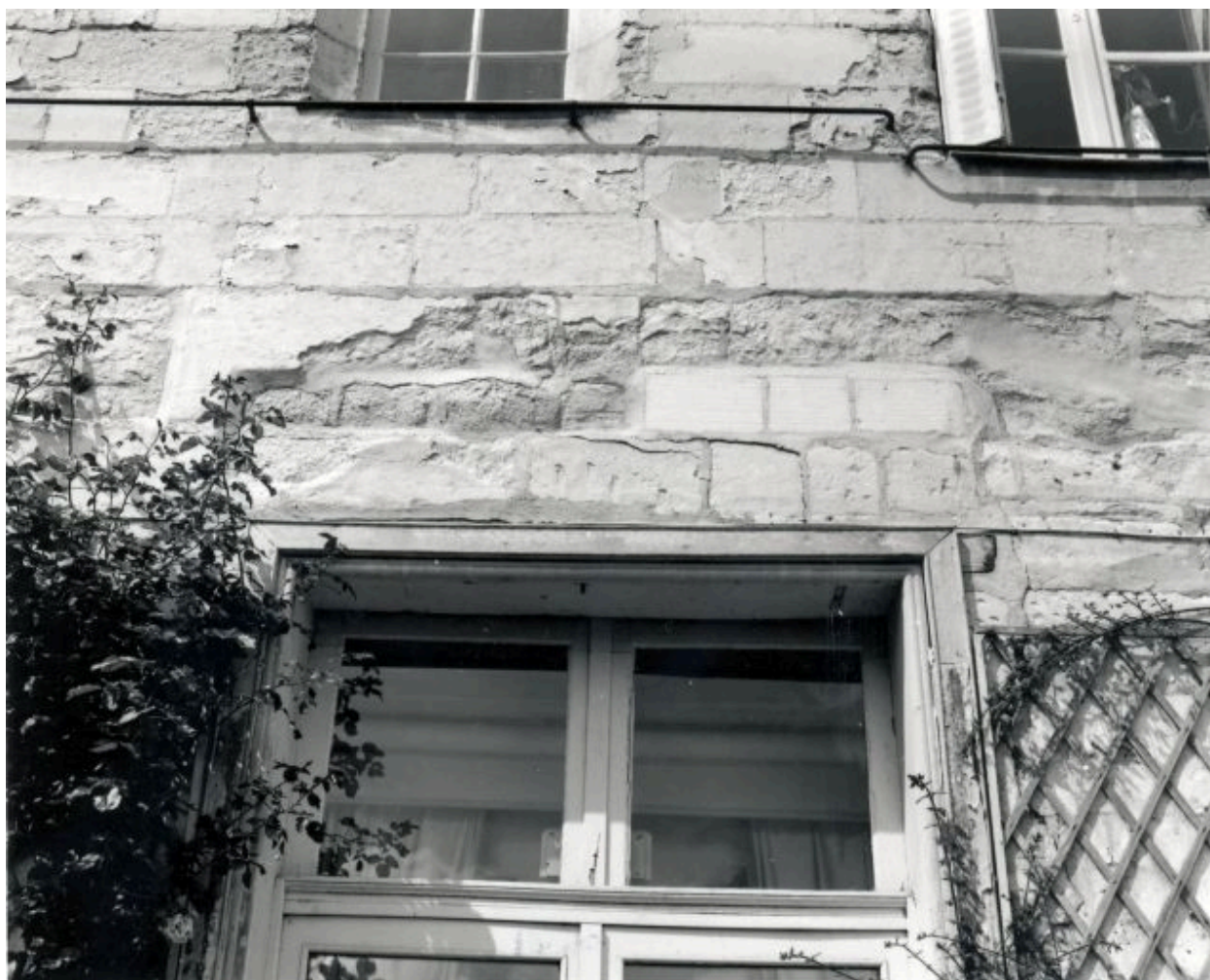
Corps de logis principal, élévation postérieure sur jardin, rez-de-chaussée : vestiges de la plate-bande de l'ancienne baie droite.
