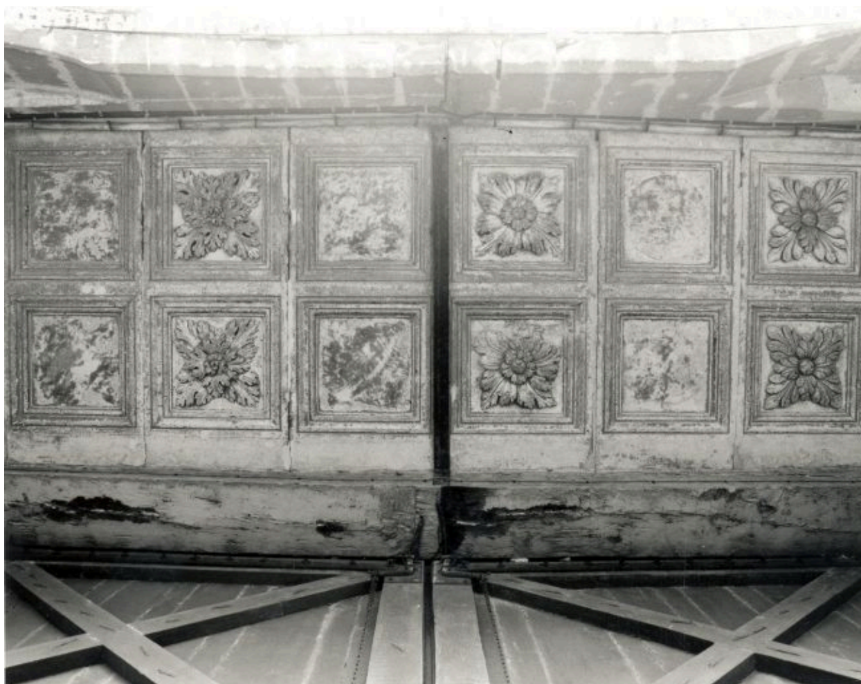
Corps d'entrée : plafond du passage couvert.
