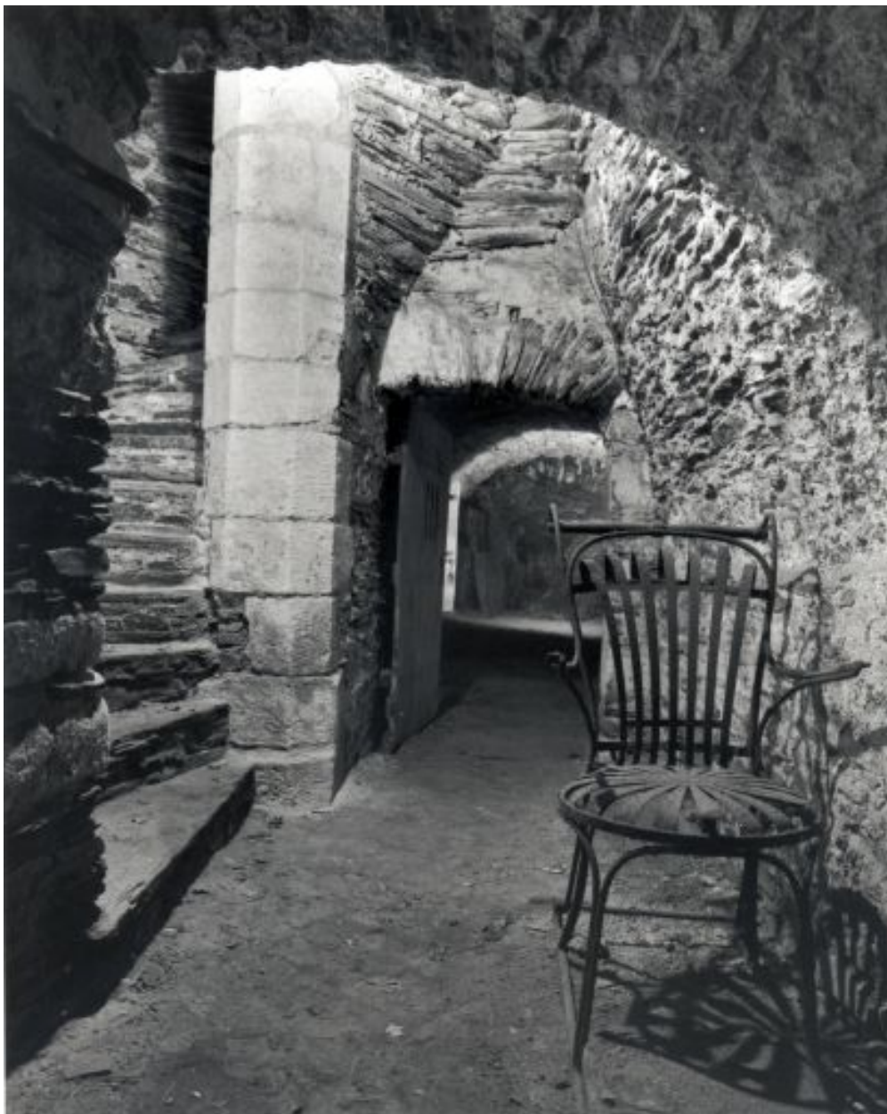
Sous-sol : base de l'escalier en vis. Au fond, cave située sous la cour.
