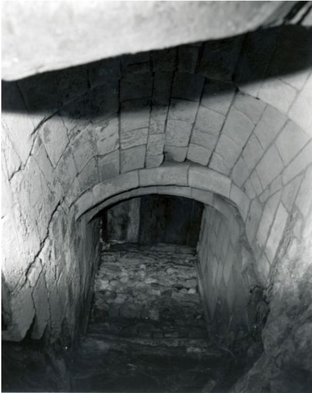
Corps de logis gauche : vestiges d'un escalier voûté menant de la cour à la cave droite.
