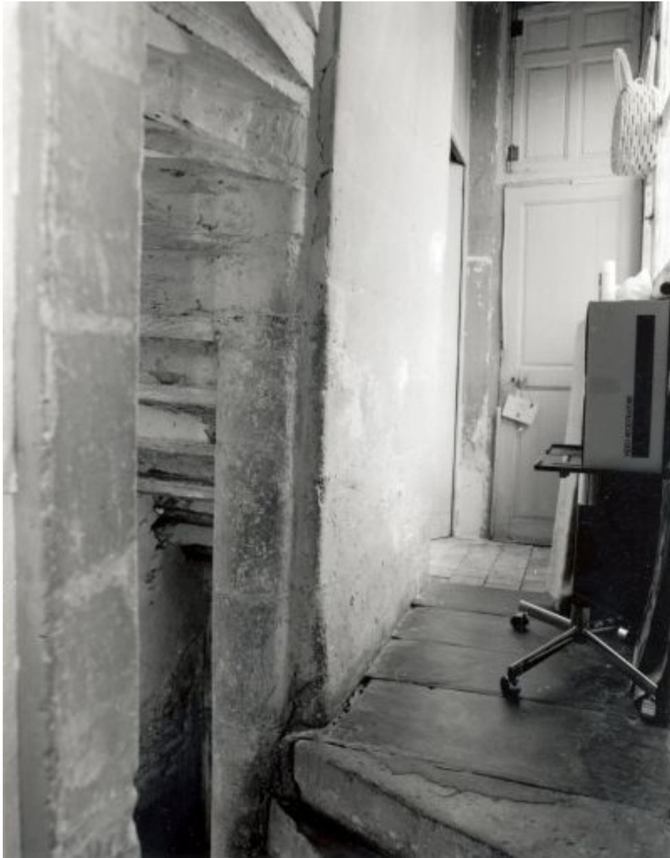
Galerie : corps secondaire : escalier, palier du 1er étage. Au fond, porte vers le corps principal.
