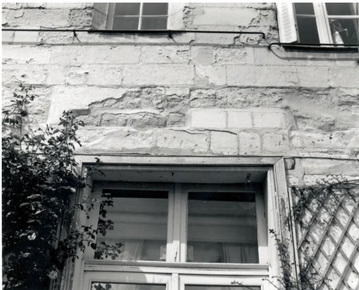
Corps de logis principal, élévation postérieure sur jardin, rez-de-chaussée : vestiges de la plate-bande de l'ancienne baie droite.
