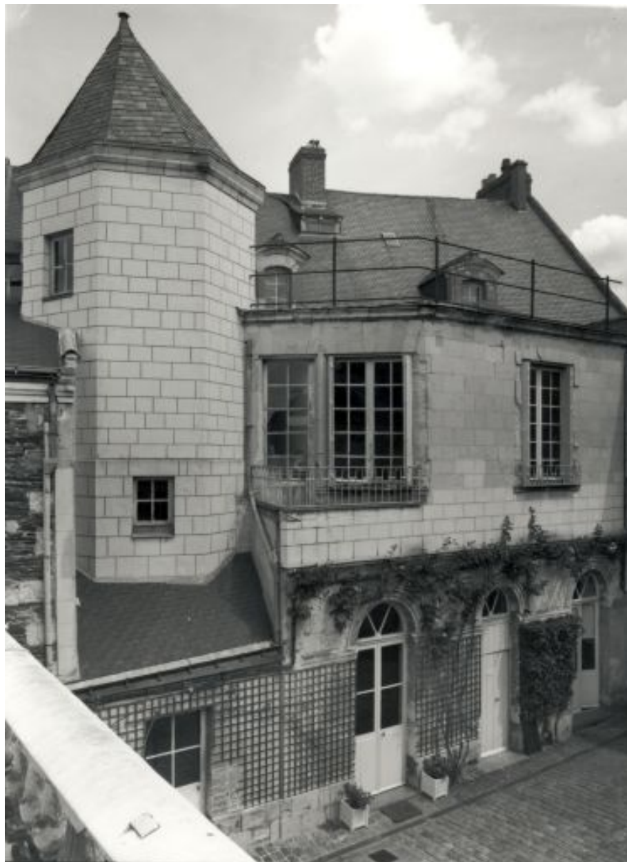
Corps de logis principal : élévation antérieure.
