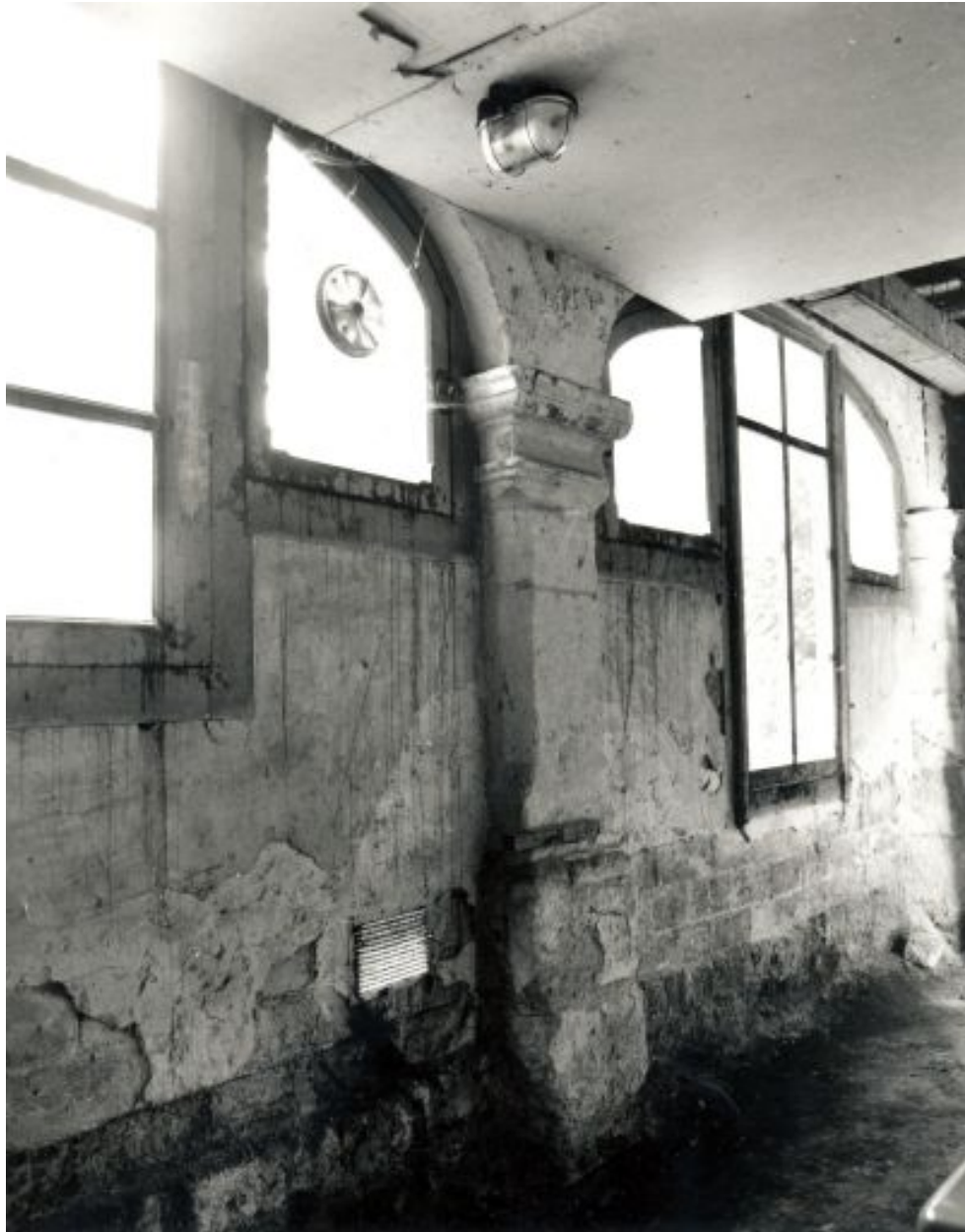
Galerie : corps principal, premier niveau : élévation intérieure d'une arcade.
