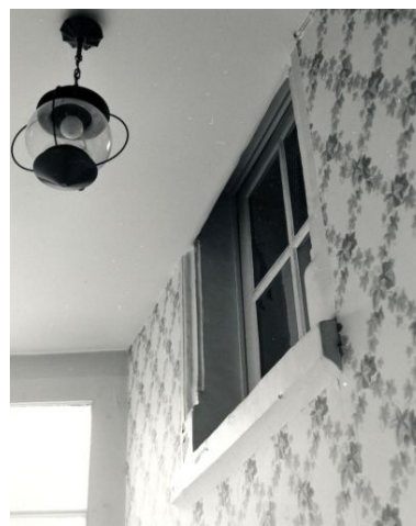
Tour d'escalier : fenêtre sur la face latérale droite à hauteur du 1er étage. Phot. François Lasa IVR52_19944900430X
