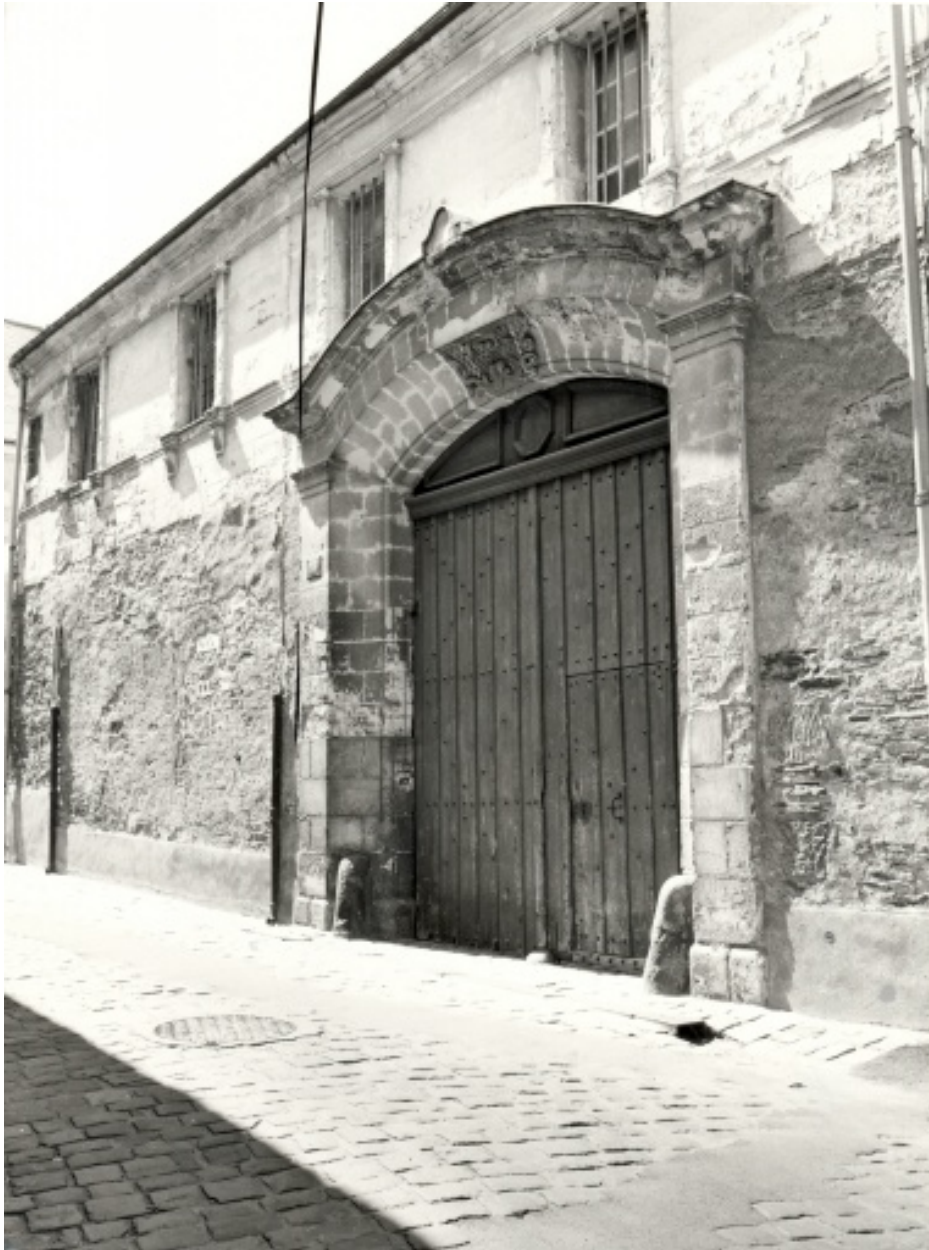
Corps d'entrée, élévation sur rue, vue d'ensemble.
