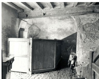
Bâtiment des écuries, rez-de-chaussée, face intérieure vers la rue : arc de liaison avec le corps d'entrée. Phot. François Lasa IVR52_19944900410X
