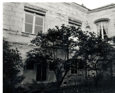
Galerie : corps principal, élévation sur le jardin : partie gauche. Phot. François Lasa IVR52_19934900323X
