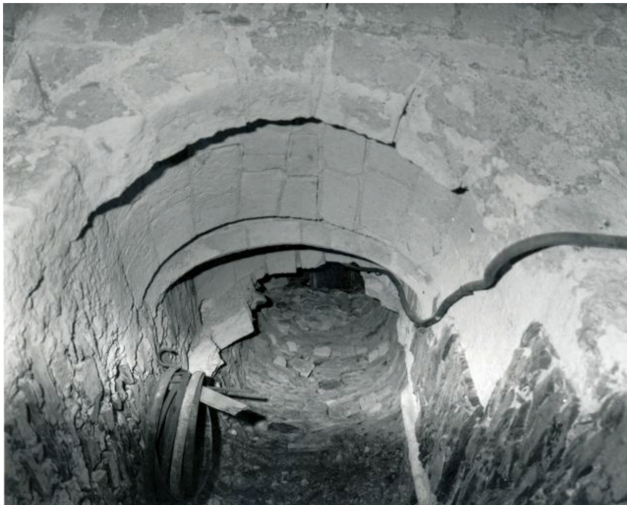
Corps de logis gauche : vestiges d'un puits accessible par un passage voûté depuis la cave droite.
