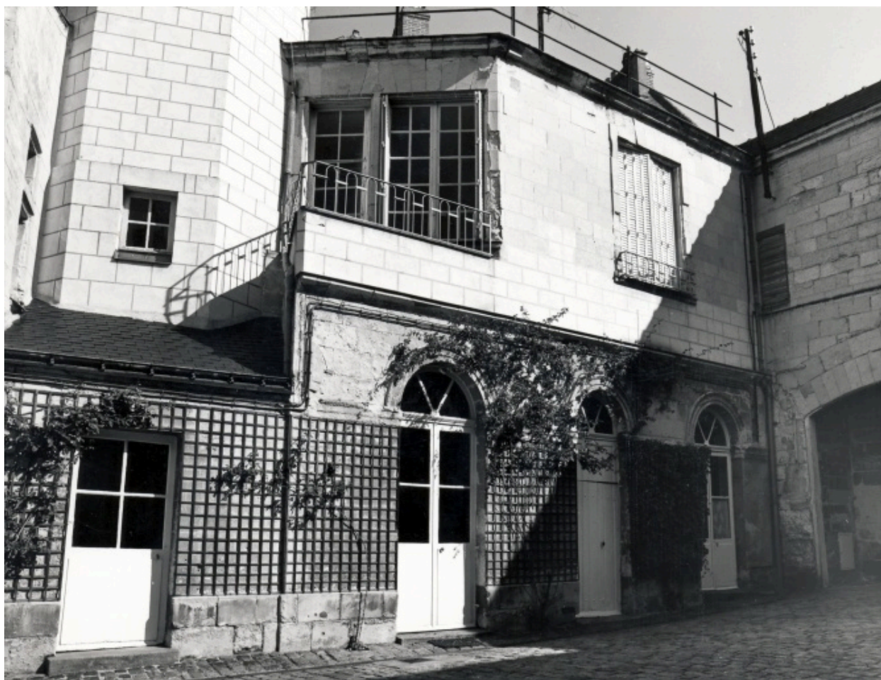
Corps de logis principal : bâtiments adventices masquant l'élévation antérieure d'origine. A gauche, la tour d'escalier.
