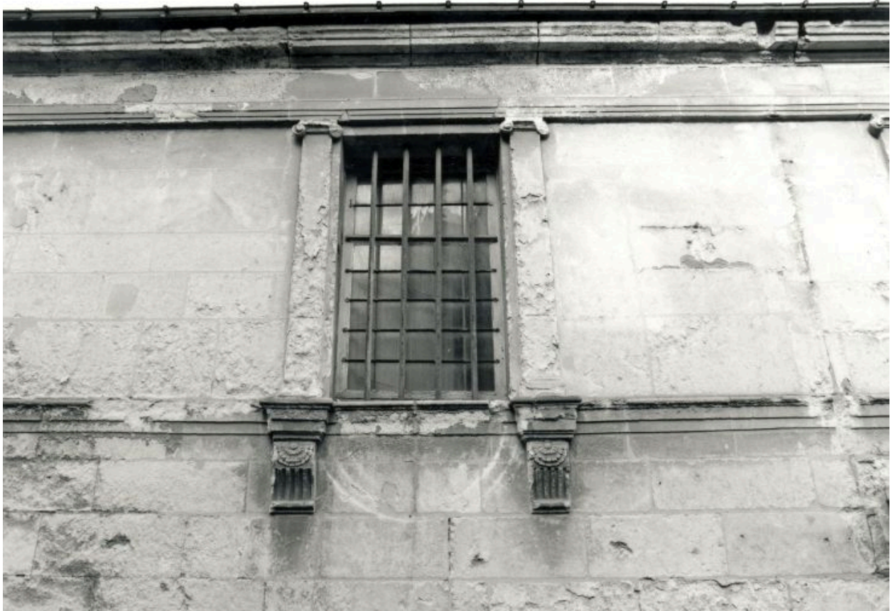
Corps d'entrée, élévation sur rue : 2e baie d'étage.
