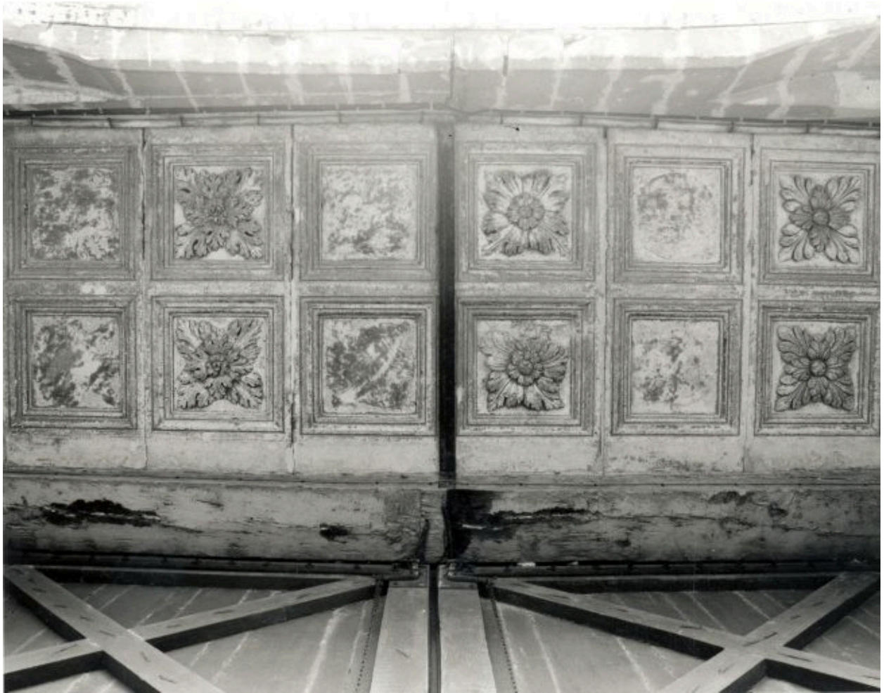
Corps d'entrée : plafond du passage couvert.
