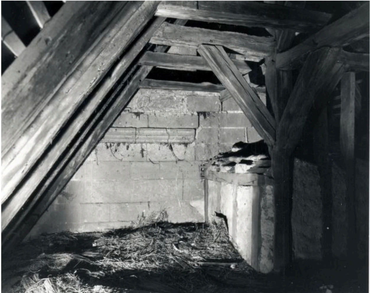
Corps d'entrée : vestiges de l'élévation postérieure vus depuis les combles du bâtiment des écuries.
