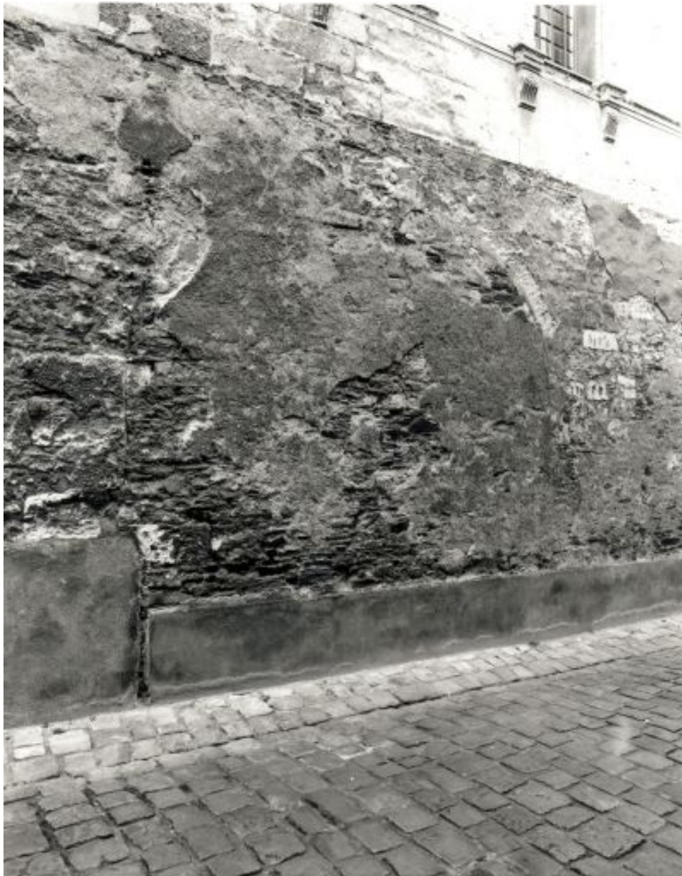
Corps d'entrée, élévation sur rue, partie gauche : porte cochère murée.
