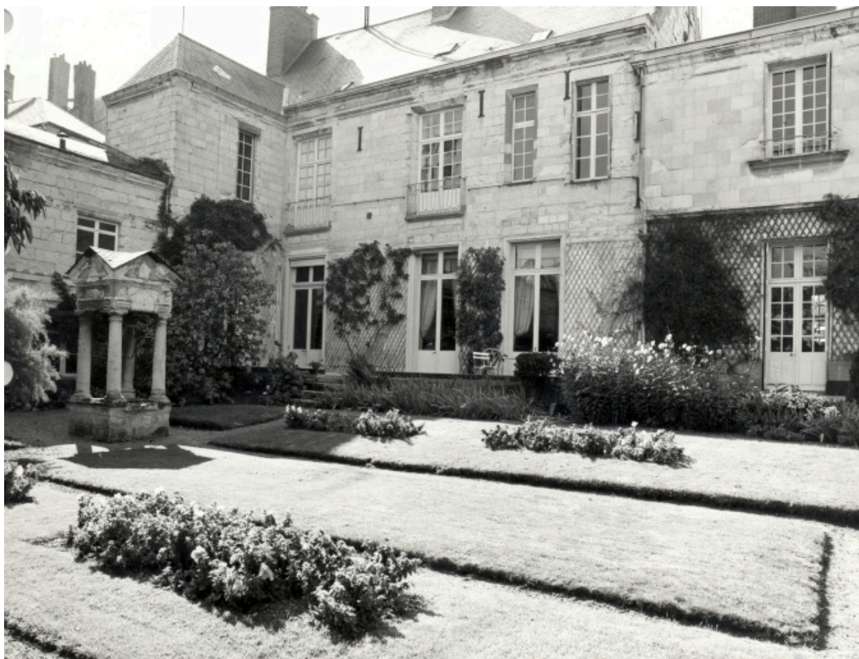
Elévations des logis sur jardin, vue d'ensemble.
