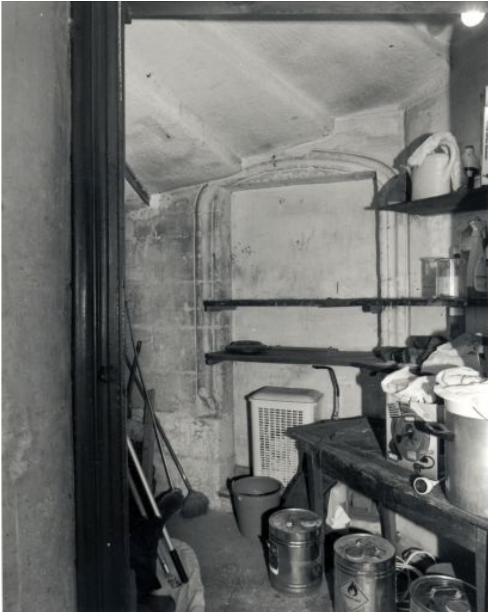
Tour d'escalier : porte d'accès (murée) à la grande salle.
