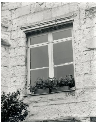
Galerie : corps principal, élévation sur le jardin : 2e niveau : sixième baie. Phot. François Lasa IVR52_19934900322X
