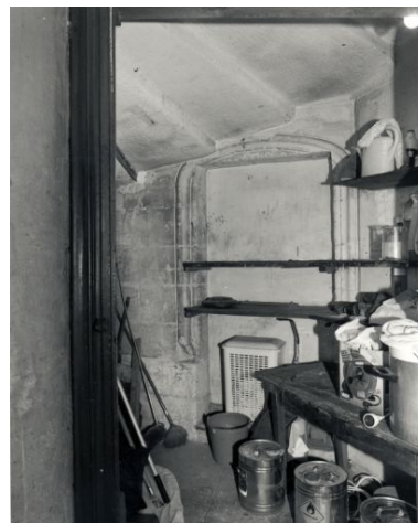
Tour d'escalier : porte d'accès (murée) à la grande salle. Phot. François Lasa IVR52_19944900417X
