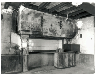
Corps de logis gauche, rez-de-chaussée, pièce antérieure, mur postérieur : cheminée. Phot. Patrice Giraud IVR52_19864901757X
