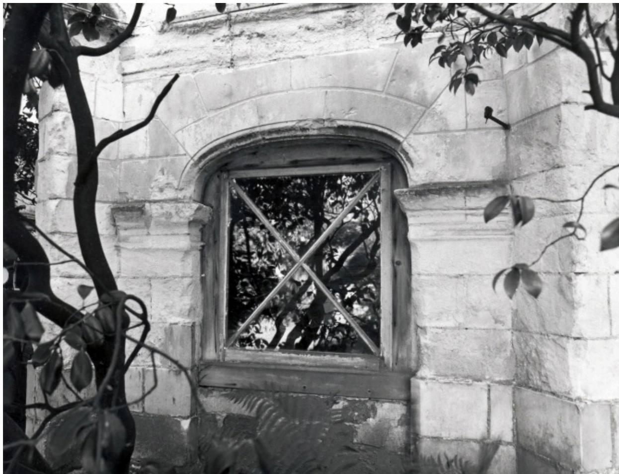
Galerie sur jardin, corps principal : avant-corps central, rez-de-chaussée, partie médiane.
