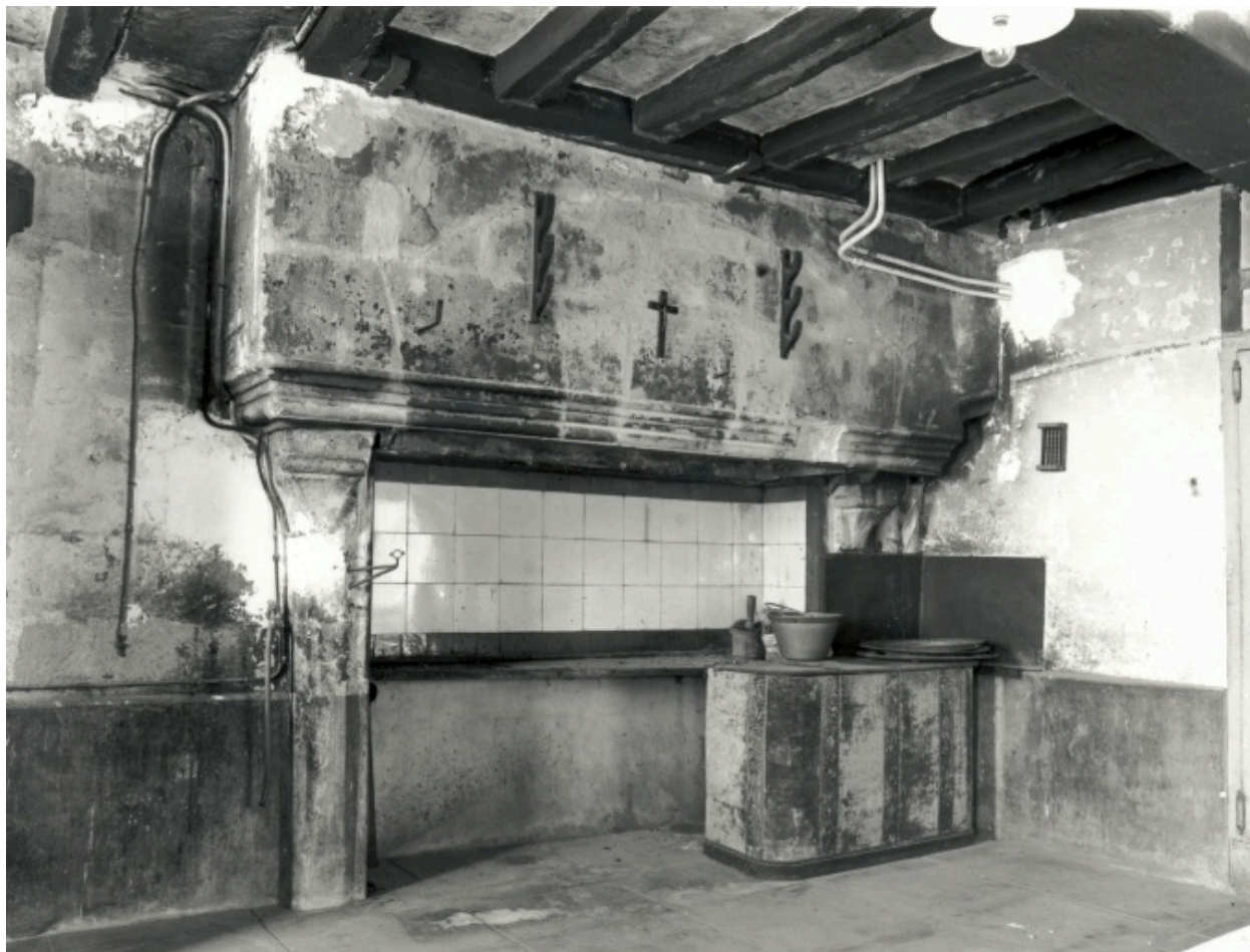
Corps de logis gauche, rez-de-chaussée, pièce antérieure, mur postérieur : cheminée.
