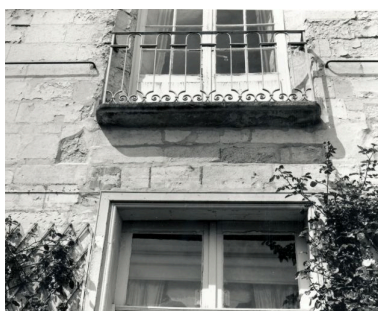
Corps de logis principal, élévation postérieure sur jardin, rez-de- chaussée : vestiges de la plate- bande de l'ancienne baie centrale. Phot. François Lasa IVR52_19944900415X
