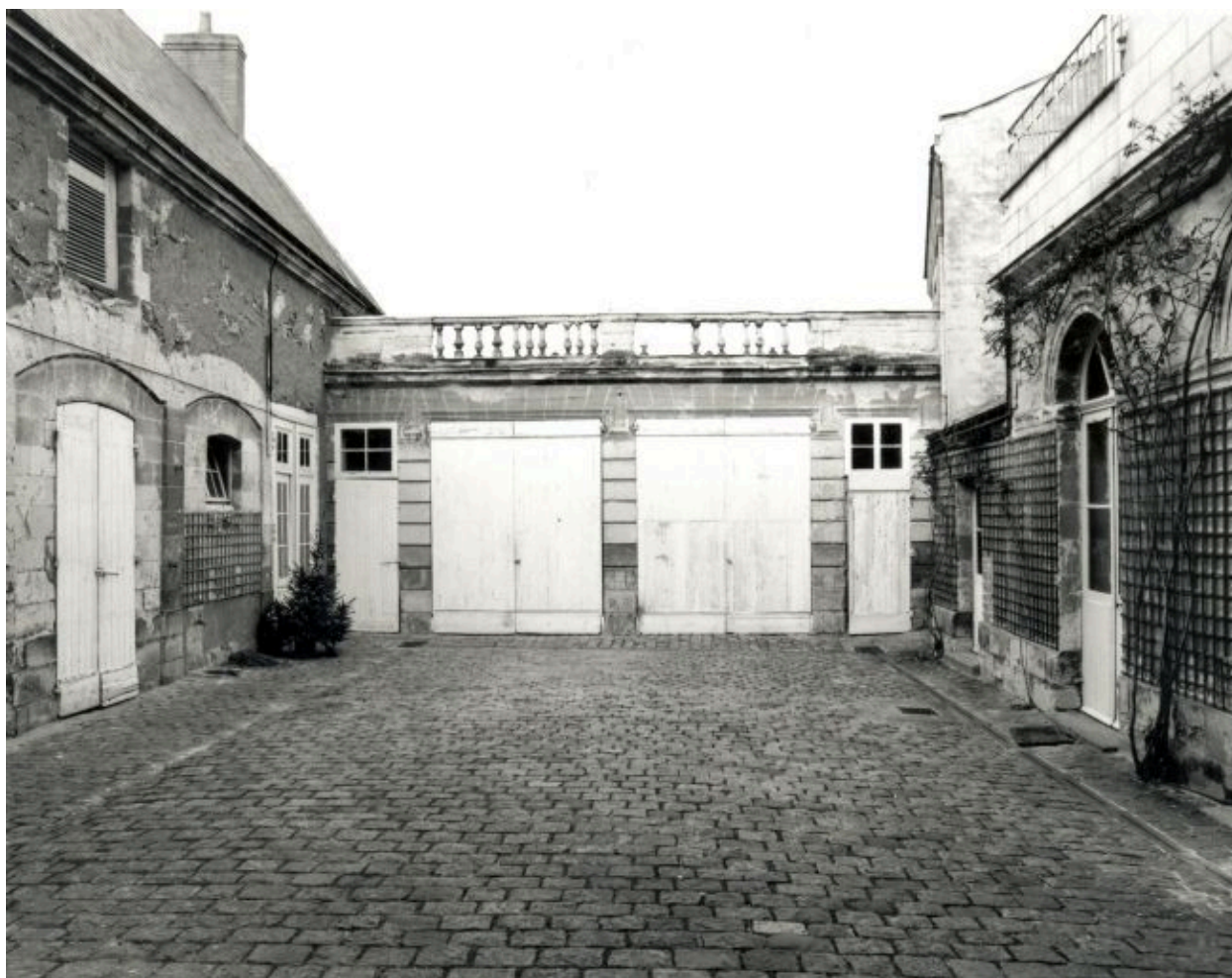
Bâtiment des remises, en fond de cour : élévation antérieure. A gauche, les écuries. A droite, le logis.
