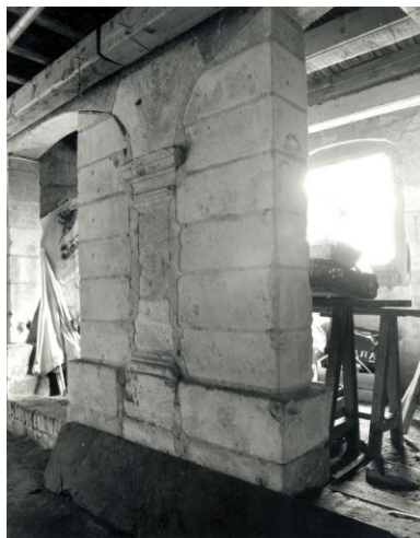
Galerie : corps principal, premier niveau : élévation intérieure des arcades marquées par l'avant-corps. Phot. François Lasa IVR52_19934900327X
