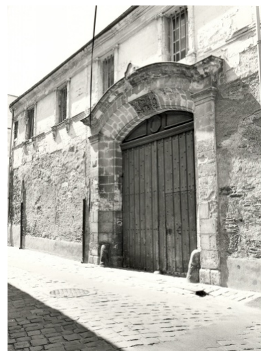
Corps d'entrée, élévation sur rue, vue d'ensemble. Phot. François Lasa
