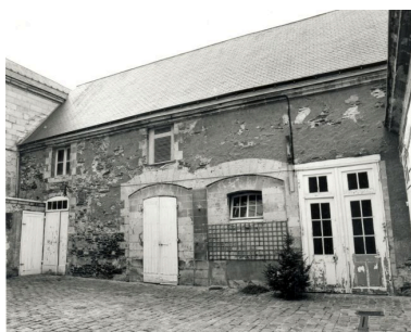
Bâtiment des écuries, sur la cour : élévation antérieure. Phot. François Lasa IVR52_19934900329X
