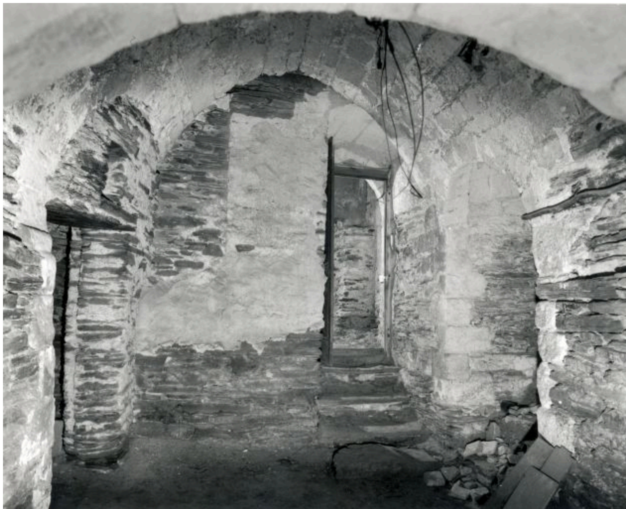
Corps de logis gauche : cave droite en axe longitudinal. A gauche, porte d'accès à un escalier de sortie vers la cour (maintenant condamné). Au fond, porte d'accès à la cave gauche. A droite, passage voûté menant à un puits.
