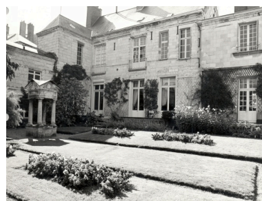
Élévations des logis sur jardin, vue d'ensemble. Phot. Patrice Giraud IVR52_19864901762X
