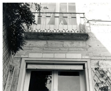
Corps de logis principal, élévation postérieure sur jardin, rez-de- chaussée : vestiges de la plate- bande de l'ancienne baie gauche. Phot. François Lasa IVR52_19944900416X
