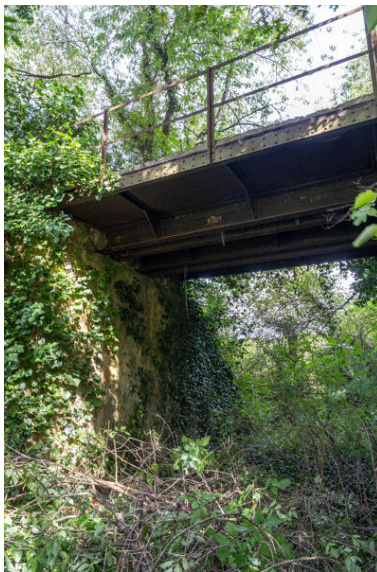
Vue en contre-bas du pont. Phot. Jeanne Minier IVR52_20257200431NUCA
