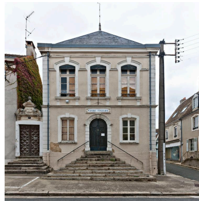
Elévation sur la rue Saint-Nicolas. A noter à gauche la porte donnant anciennement sur la ruelle de la chapelle et aujourd'hui dans la cour de la maison 7, rue Saint-Nicolas. Phot. Yves Guillotin IVR52_20147201944NUCA
