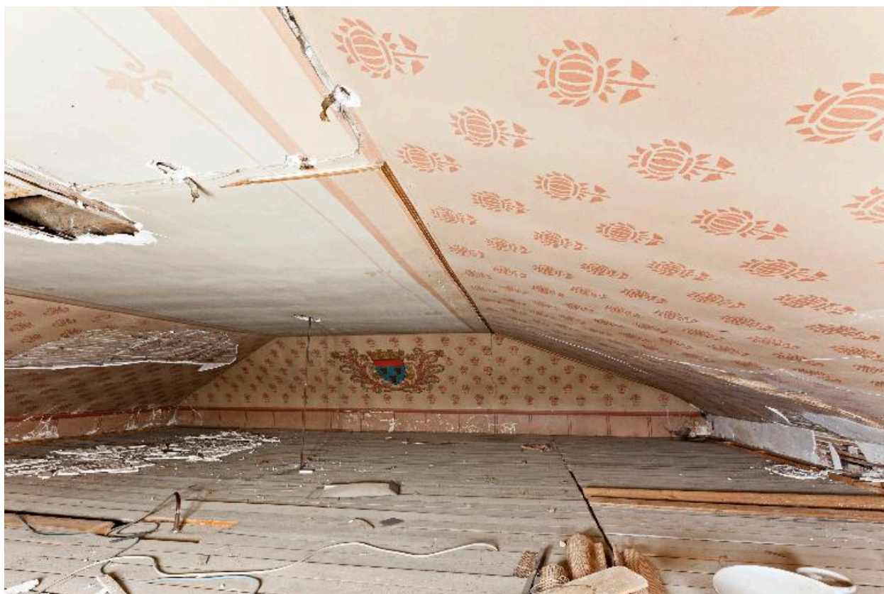
Vestige de la fausse-voûte en plâtre couvrant la salle de l'étage.
