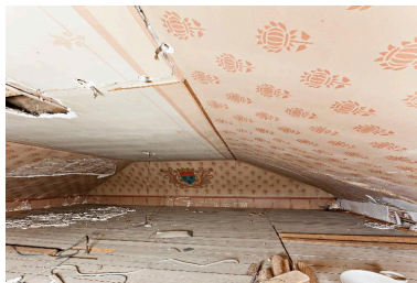
Vestige de la fausse-voûte en plâtre couvrant la salle de l'étage. Phot. Yves Guillotin IVR52_20147202076NUCA
