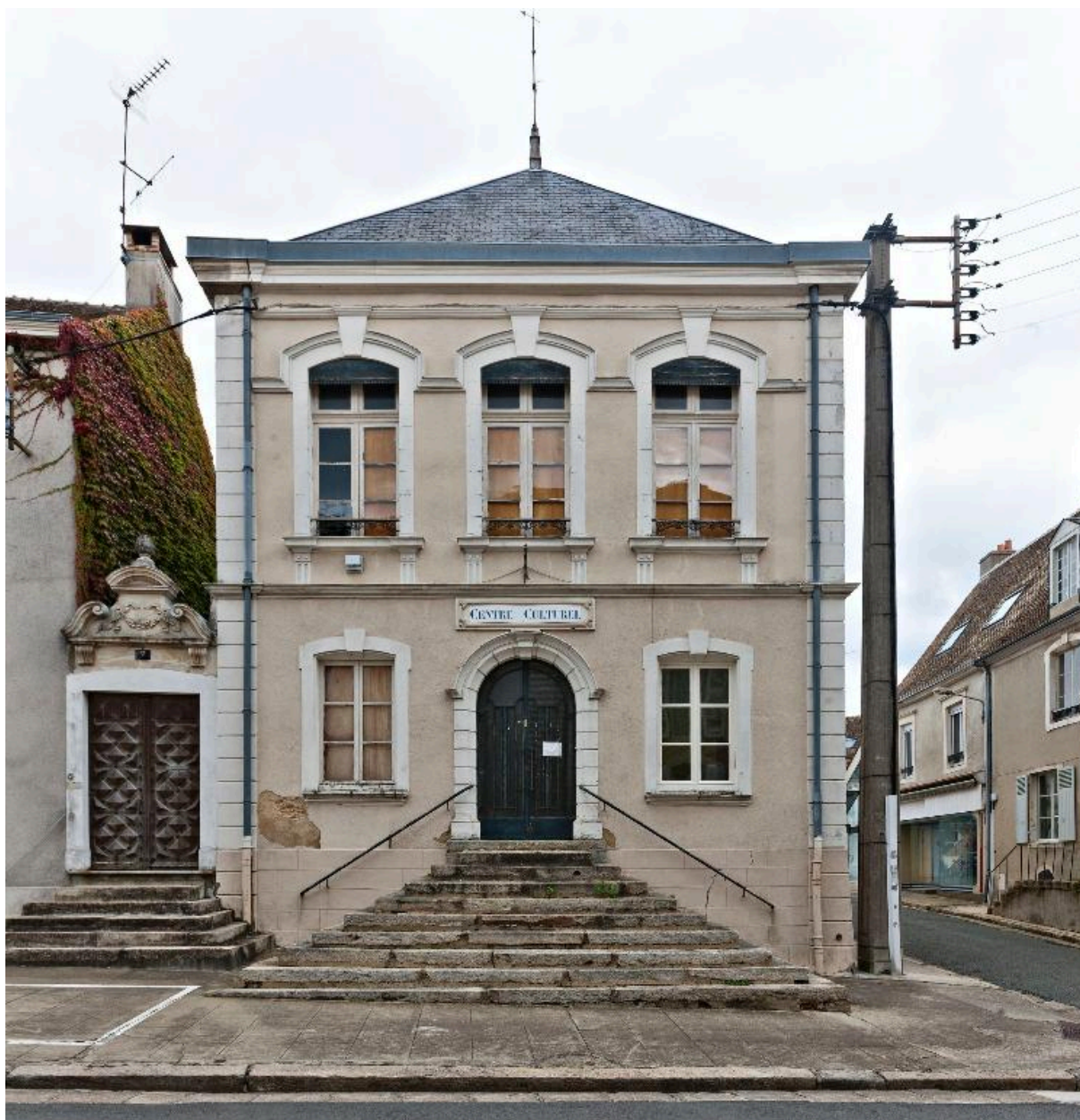
Elévation sur la rue Saint-Nicolas. A noter à gauche la porte donnant anciennement sur la ruelle de la chapelle et aujourd'hui dans la cour de la maison 7, rue Saint-Nicolas.
