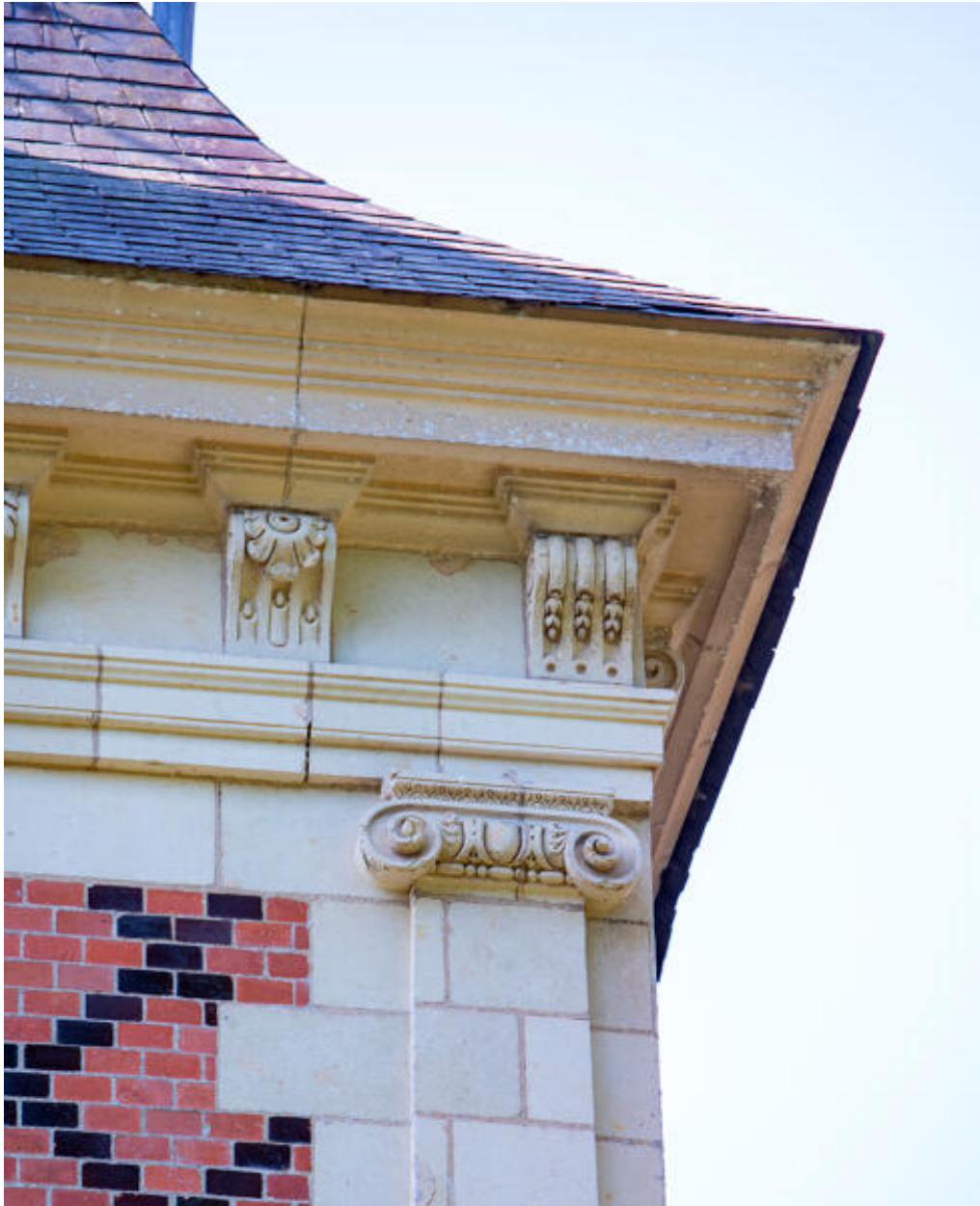
Le pavillon nord-est, détail d'un pilastre d'angle et de la corniche.
