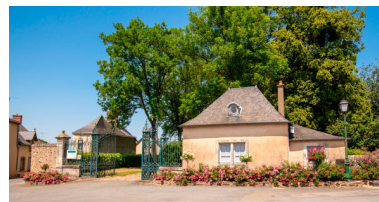
Le portail et le pavillon de gardien. Phot. Pierre-Bernard Fourny IVR52_20235300791NUCA
