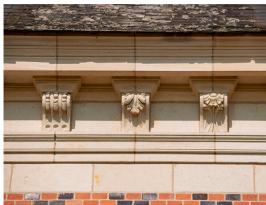
L'aile est, détail de la corniche. Phot. Pierre-Bernard Fourny IVR52_20235300751NUCA
