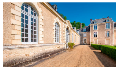
La façade de l'orangerie. Phot. Pierre-Bernard Fourny IVR52_20235300714NUCA
