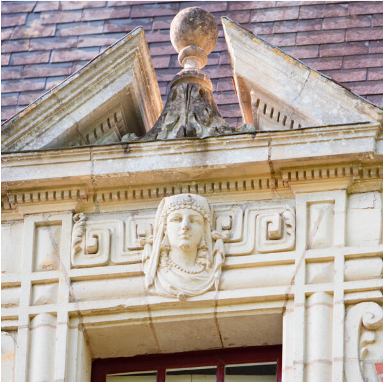
Le pavillon nord-est, détail d'une lucarne sculptée.
