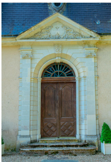
L'aile nord, la porte. Phot. Pierre-Bernard Fourny IVR52_20235300726NUCA
