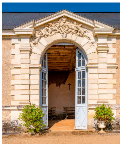
La porte de l'orangerie. Phot. Pierre-Bernard Fourny IVR52_20235300716NUCA
