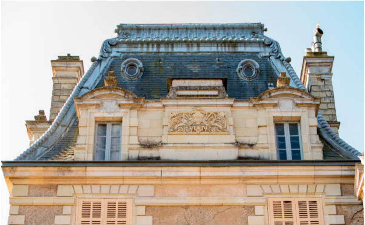
Le pavillon sud-est, détail du comble.
