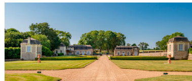
La perspective vers l'entrée, les communs et les pavillons. Phot. Pierre-Bernard Fourny IVR52_20235300675NUCA
