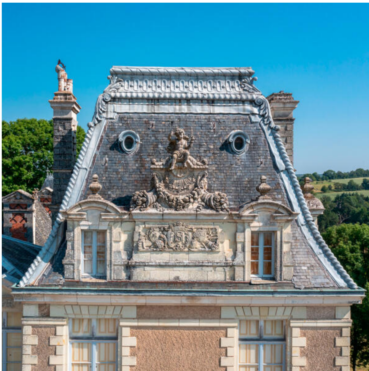
Le pavillon sud-est, étage de comble et couverture.
