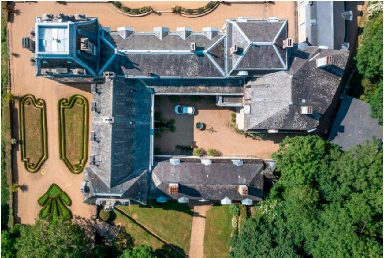
Une vue aérienne des toits du logis.
