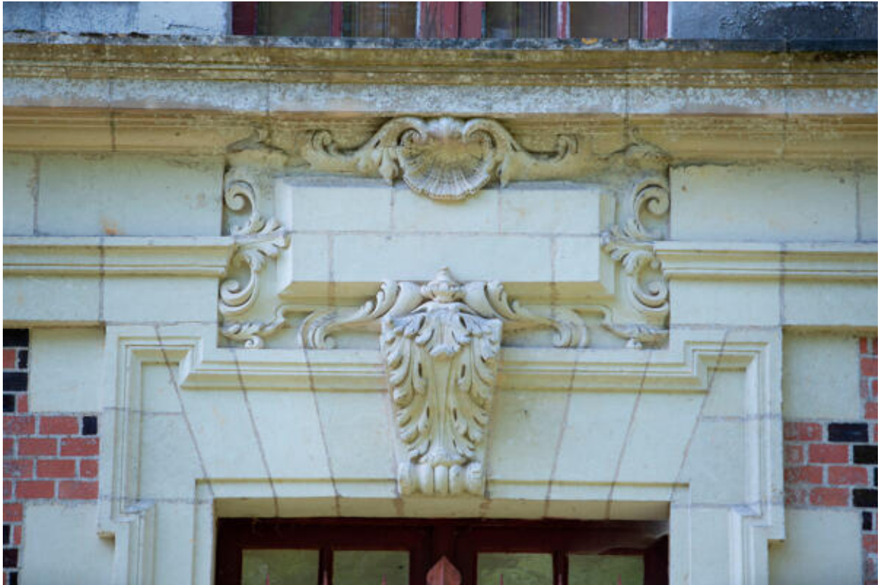
Le pavillon nord-est, détail d'une agrafe et d'un plein-de-travée en table.
