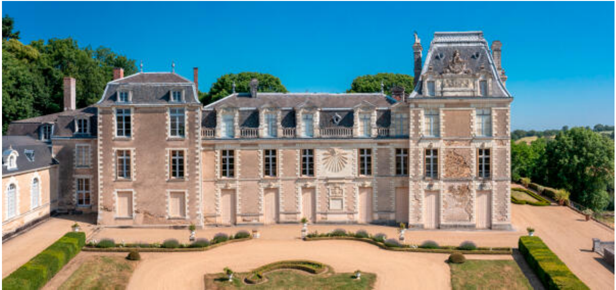
L'aile sud du logis.
