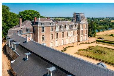
L'aile sud. Phot. Pierre-Bernard Fourny IVR52_20235300642NUCA
