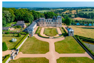
Une vue aérienne du logis et de son parterre. Phot. Pierre-Bernard Fourny IVR52_20235300614NUCA
