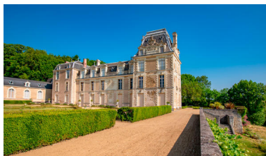
L'aile sud. Phot. Pierre-Bernard Fourny IVR52_20235300694NUCA
