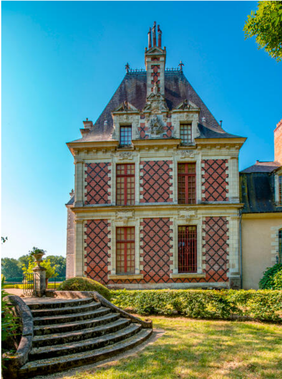
Le pavillon nord-est, élévation latérale.
