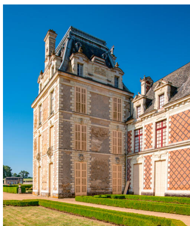
Le pavillon sud-est, élévation postérieure. Phot. Pierre-Bernard Fourny IVR52_20235300722NUCA
