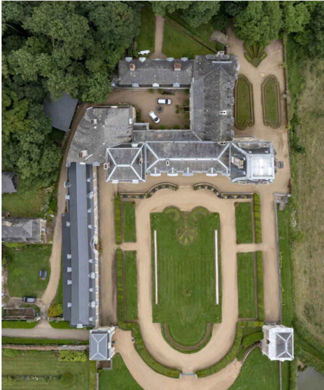
Une vue aérienne des toits du logis.
