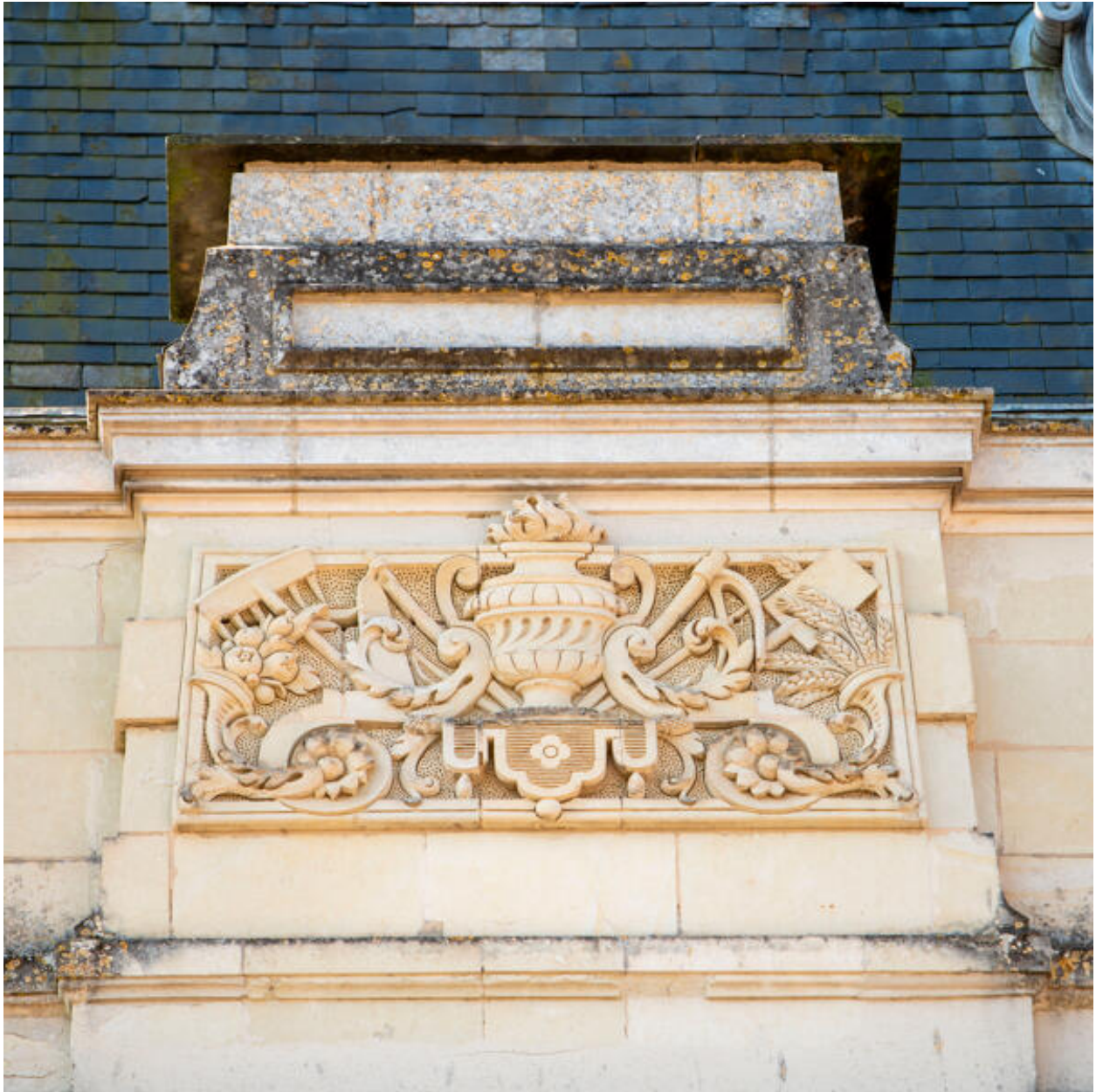
Le pavillon sud-est, détail du motif entre les deux lucarnes postérieures.
