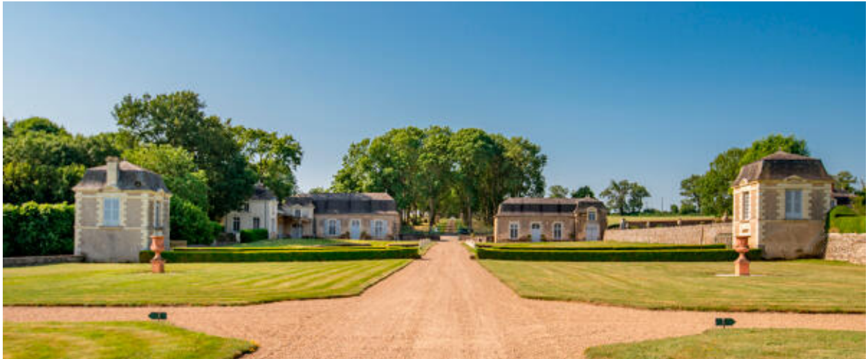
La perspective vers l'entrée, les communs et les pavillons.
