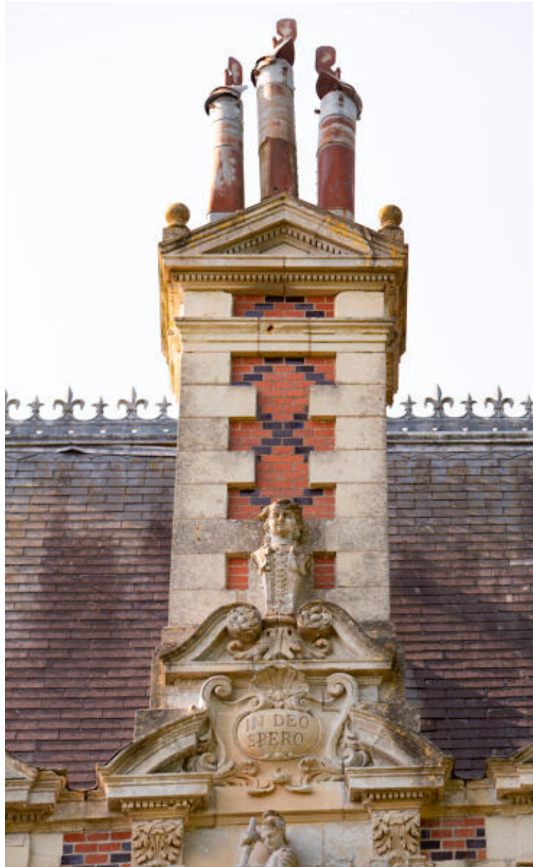
Le pavillon nord-est, souche de cheminée
