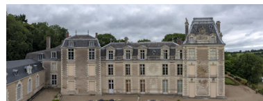
L'aile sud. Phot. Pierre-Bernard Fourny IVR52_20225300589NUCA
