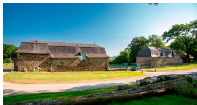
L'entrée et les communs. Phot. Pierre-Bernard Fourny IVR52_20235300666NUCA
