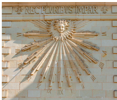
L'aile sud, devise et cadran solaire sculptés. Phot. Pierre-Bernard Fourny IVR52_20235300706NUCA
