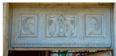
La chapelle, décors de l'imposte de la porte. Phot. Pierre-Bernard Fourny IVR52_20235300698NUCA
