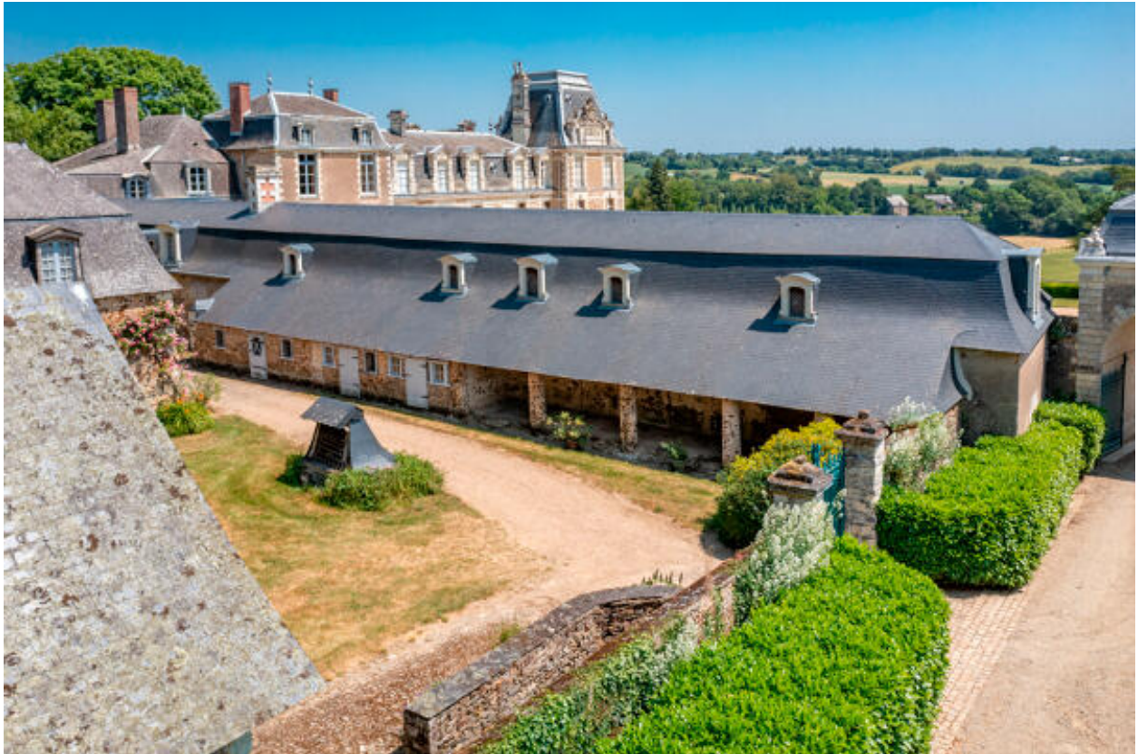
L'appentis à piles circulaires au revers de l'orangerie.
