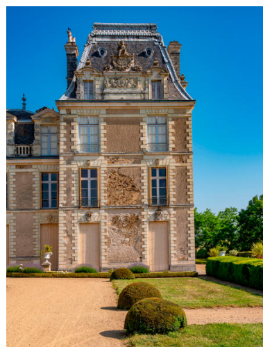
Le pavillon sud-est, élévation antérieure. Phot. Pierre-Bernard Fourny IVR52_20235300692NUCA
