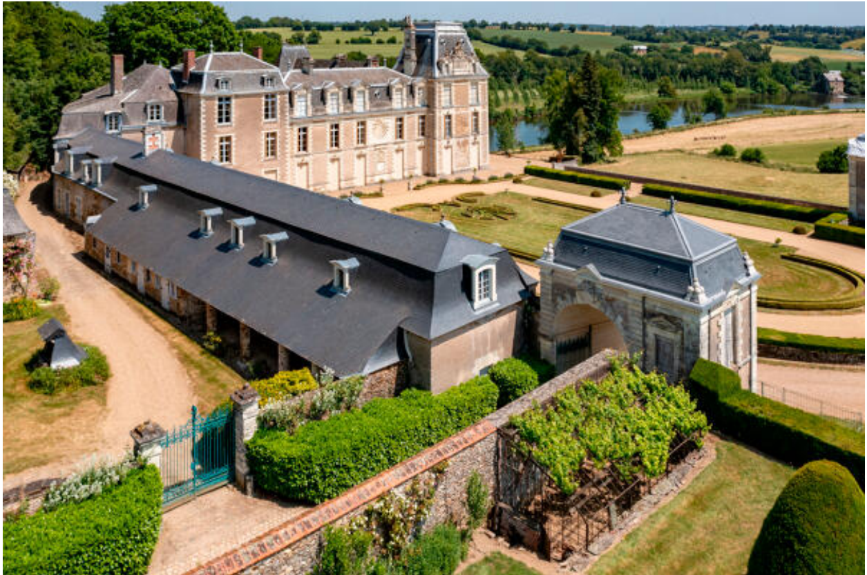
Le passage couvert et l'accès au jardin et aux dépendances.
