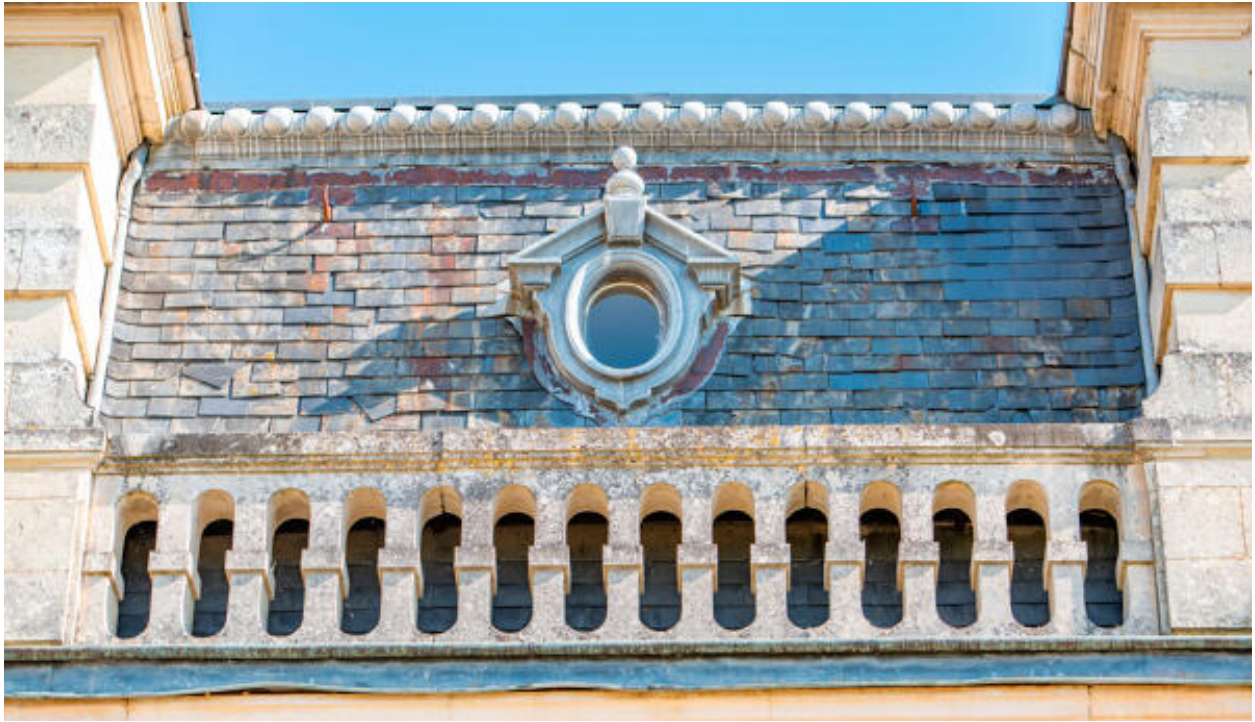
L'aile sud, la balustrade couronnant la façade et un oeil-de-boeuf.
