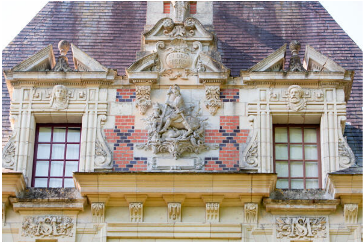
Le pavillon nord-est, les lucarnes de la façade latérale.
