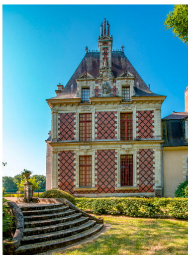
Le pavillon nord-est, élévation latérale. Phot. Pierre-Bernard Fourny IVR52_20235300724NUCA
