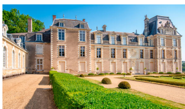
L'aile sud. Phot. Pierre-Bernard Fourny IVR52_20235300715NUCA
