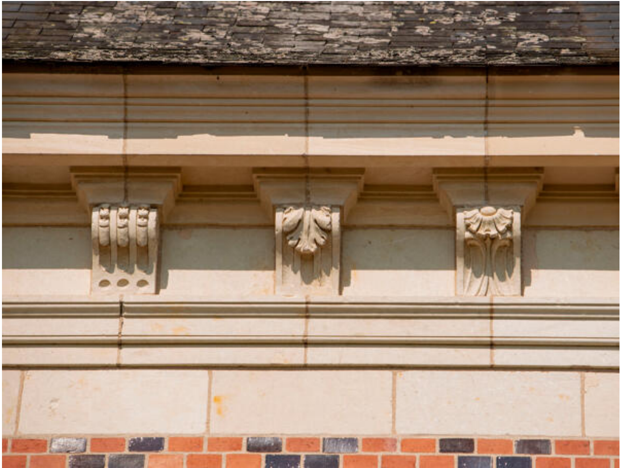
L'aile est, détail de la corniche.
