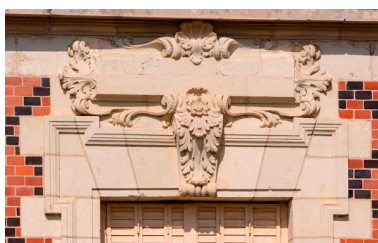
L'aile est, linteau à agrafe et motif en table sculptés. Phot. Pierre-Bernard Fourny IVR52_20235300743NUCA
