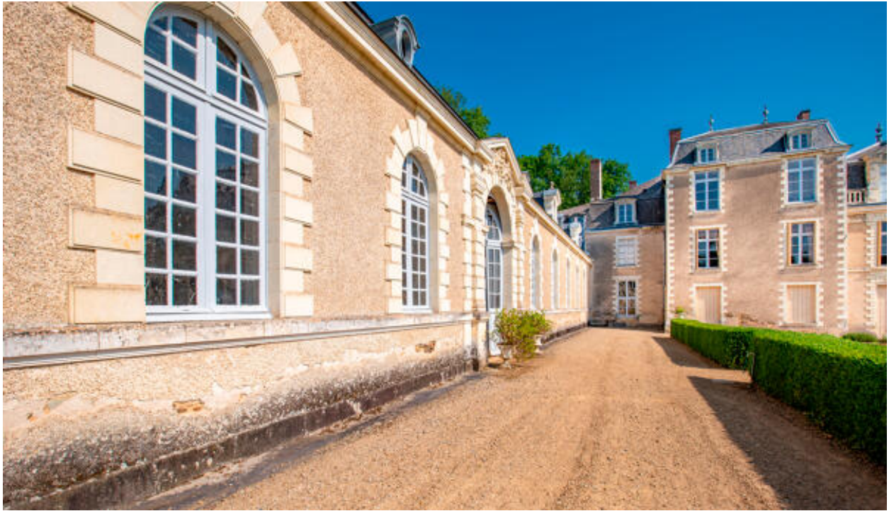
La façade de l'orangerie.
