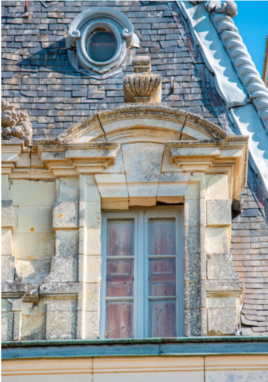
Le pavillon sud-est, détail d'une lucarne.
