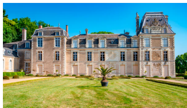
L'aile sud. Phot. Pierre-Bernard Fourny IVR52_20235300691NUCA
