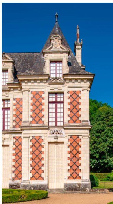
Le pavillon nord-est, élévation antérieure. Phot. Pierre-Bernard Fourny IVR52_20235300721NUCA
