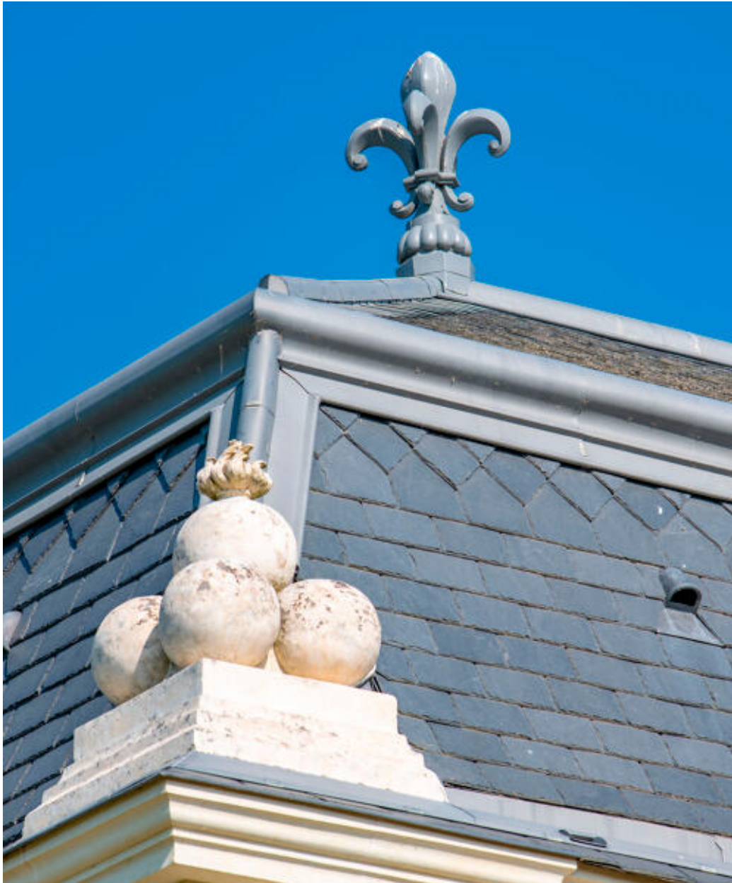
Le passage couvert, amortissement sculpté en boulets de canon et épi de faitage en forme de fleur de lys.
