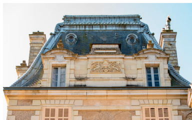
Le pavillon sud-est, détail du comble. Phot. Pierre-Bernard Fourny IVR52_20235300752NUCA
