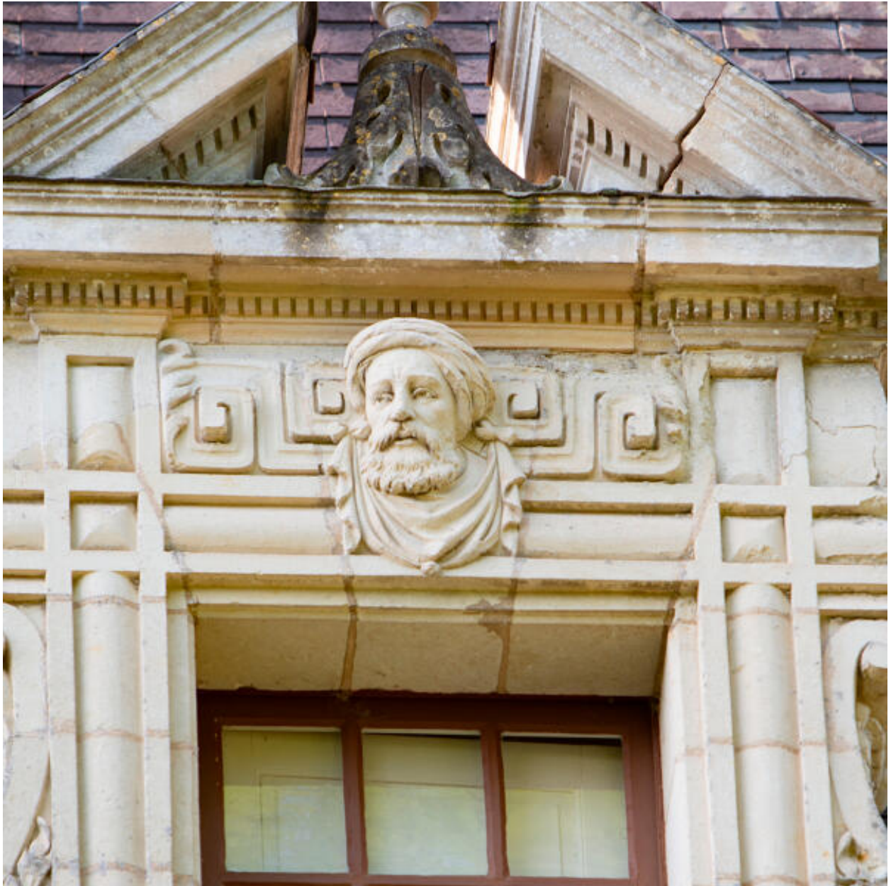
Le pavillon nord-est, détail d'une lucarne sculptée.
