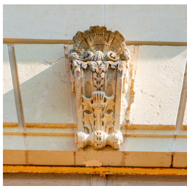
Le pavillon sud-est, détail d'une agrafe. Phot. Pierre-Bernard Fourny IVR52_20235300705NUCA
