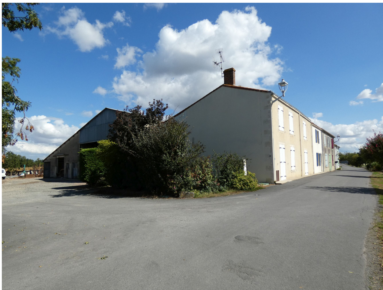
Vue depuis l'ouest.
