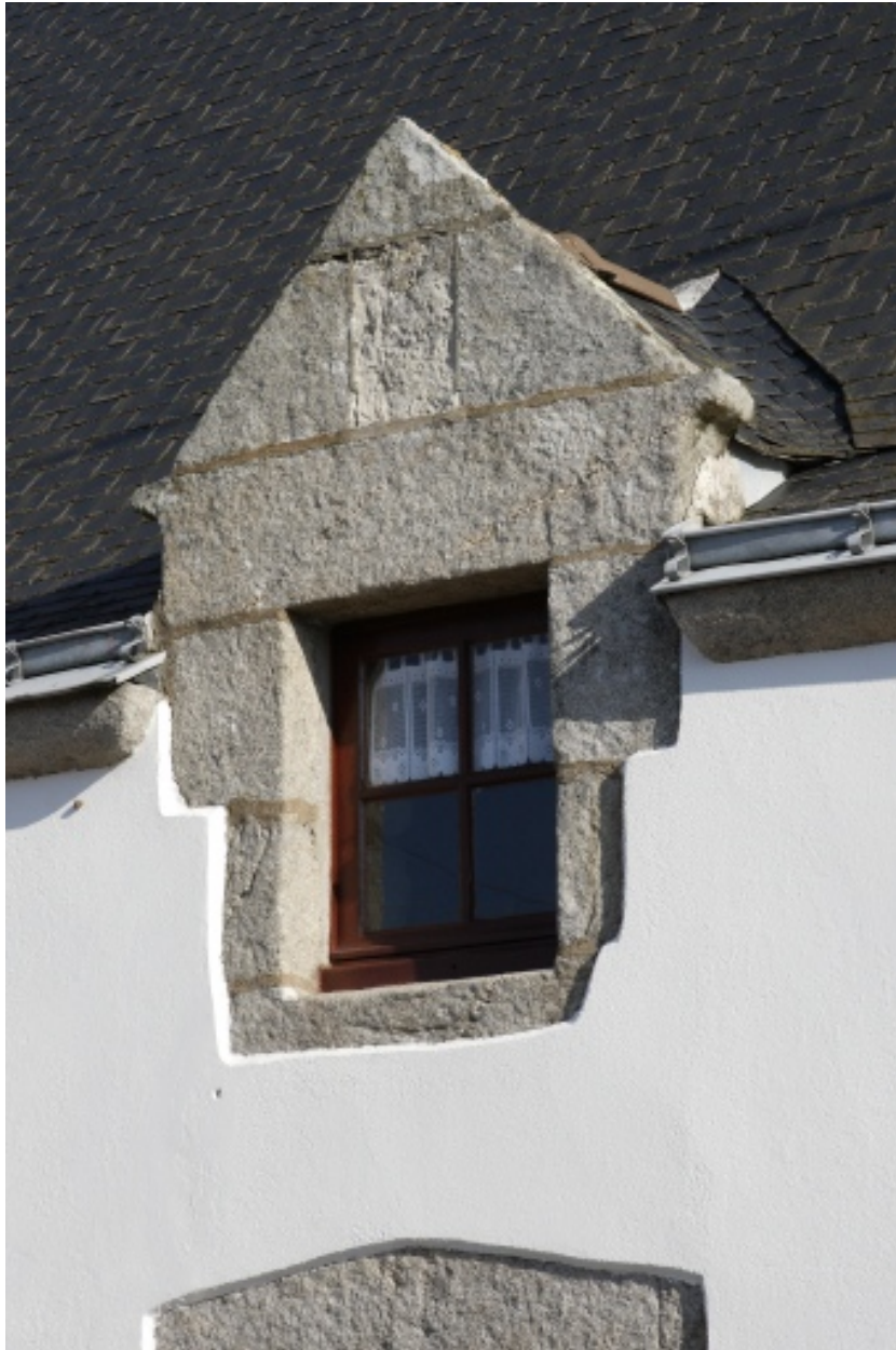
Détail de la lucarne du 1er logement (4 rue du Meunier).
