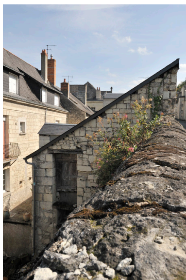
Escalier extérieur couvert, en fond de parcelle, avec accès à la rue haute (rue Françoise de Maridor).
