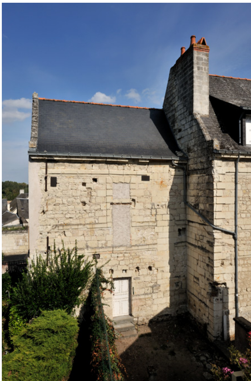
Façade postérieure de la travée ouest.
