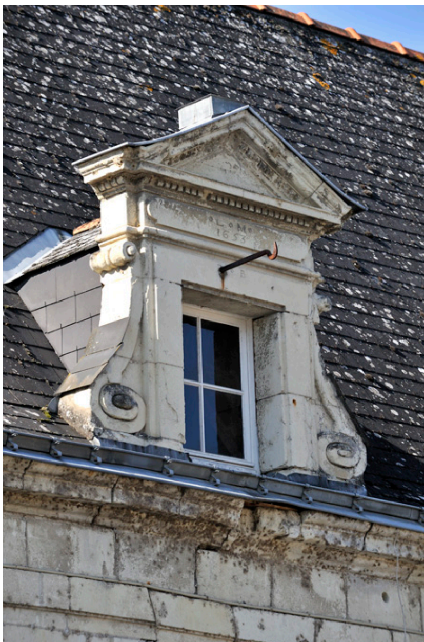
Lucarne axiale de l'aile principale, portant la date de 1653.
