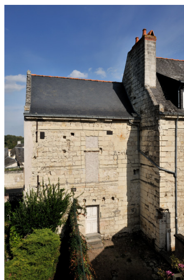
Façade postérieure de la travée ouest. Phot. Bruno Rousseau, Phot. Youenn Communeau IVR52_20114902588NUCA
